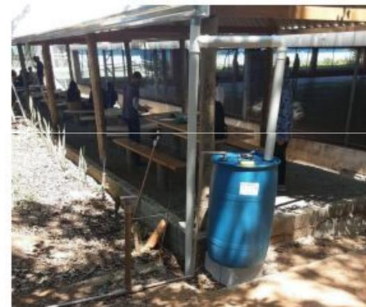
Figura 3 . Bomba d'água manual e cisterna prontos para o uso.
