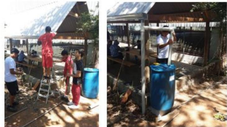
Figura 2 . Montagem do sistema de captação de água pluvial.
