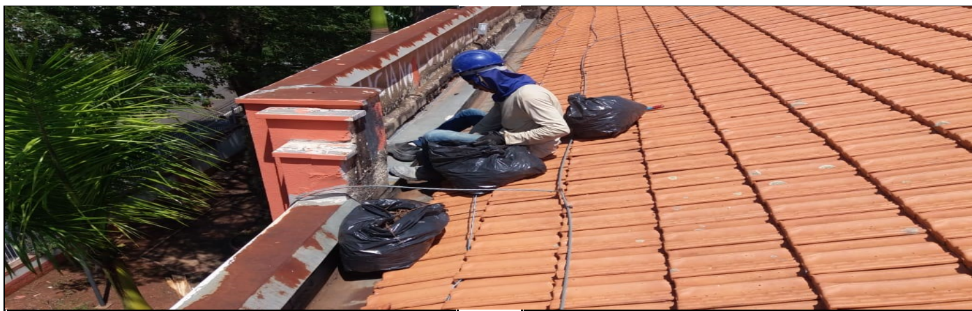
Limpeza do telhado
