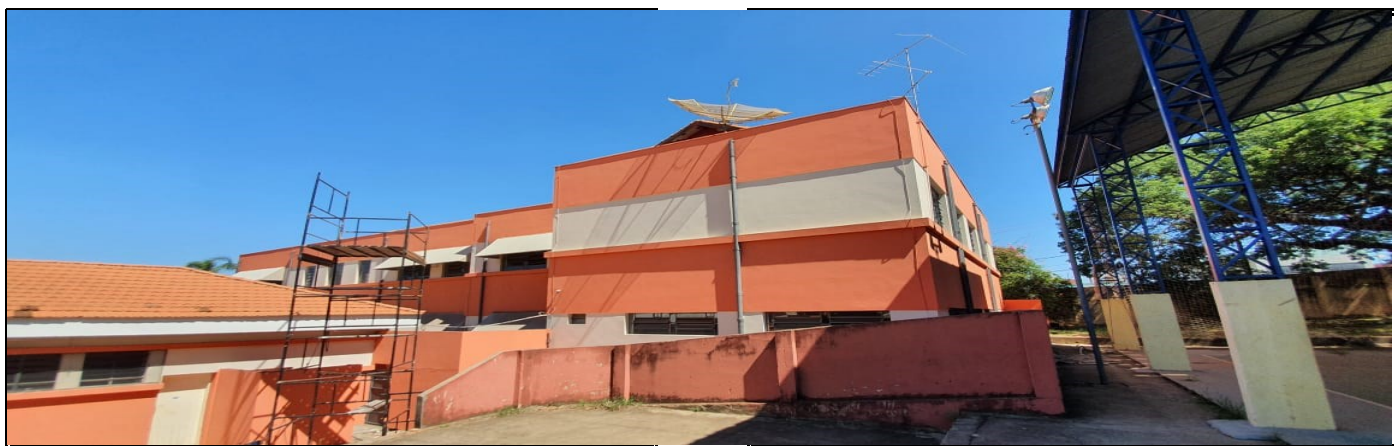
Pintura externa do prédio escolar
