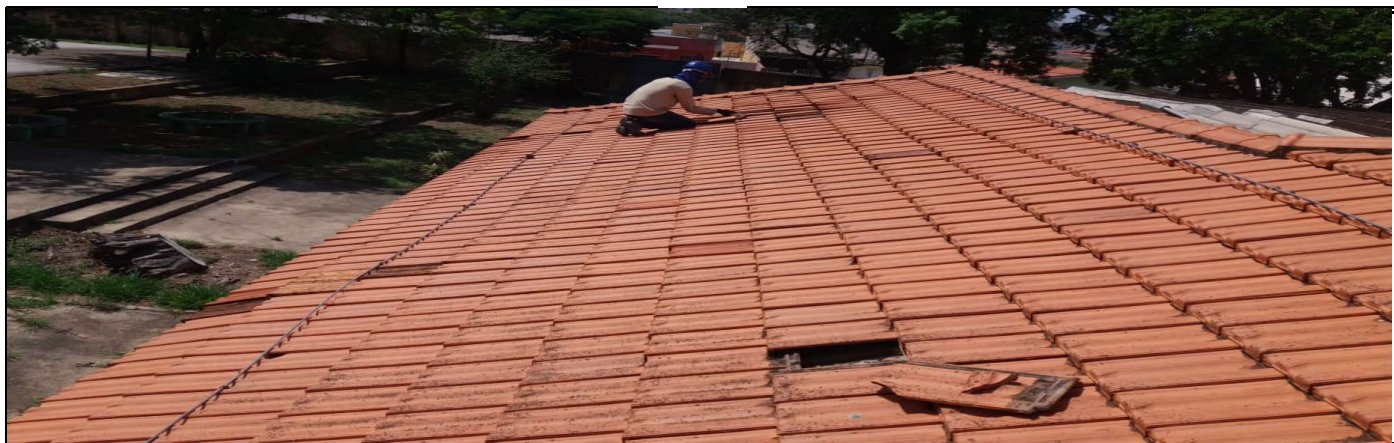
Troca de telhas de cerâmica
