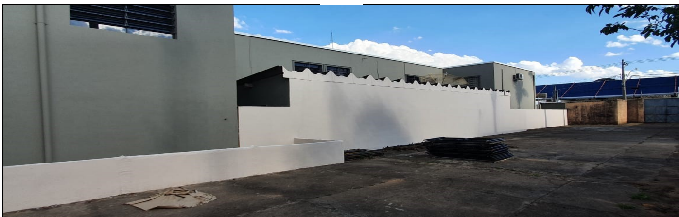
Pintura externa do prédio escolar
