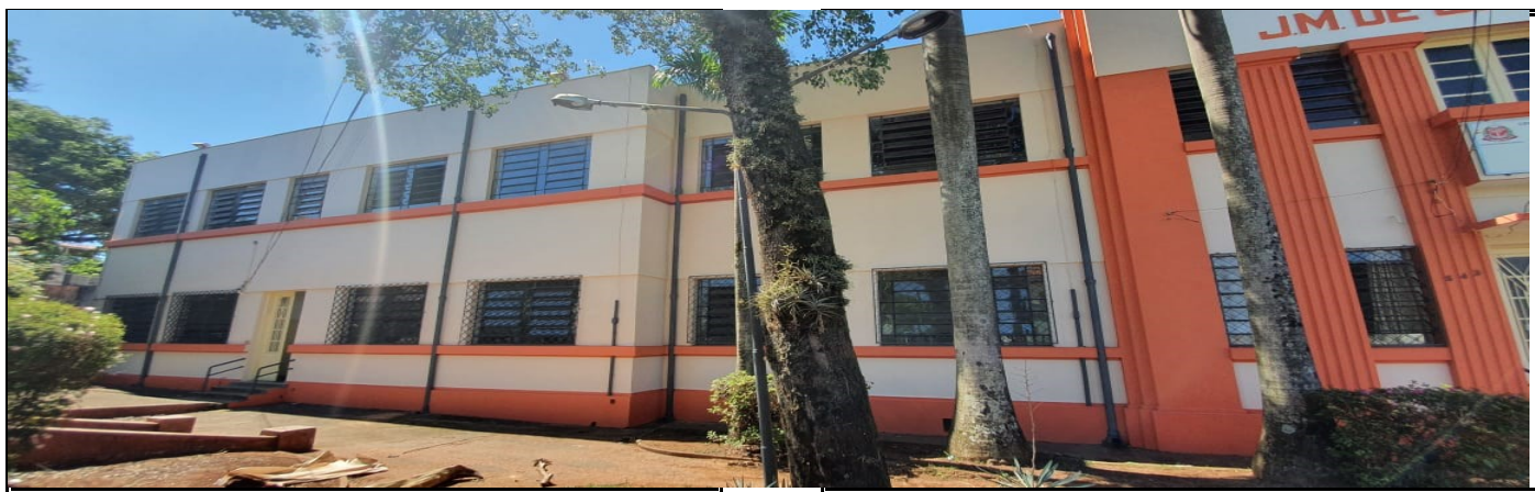
Pintura externa do prédio escolar
