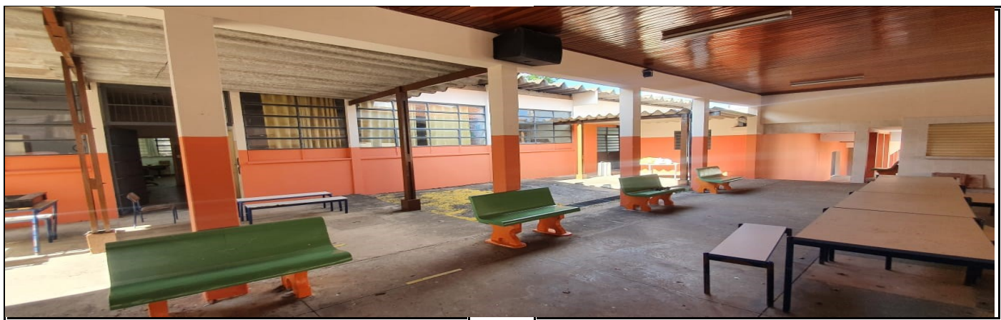
Pintura externa do prédio escolar
