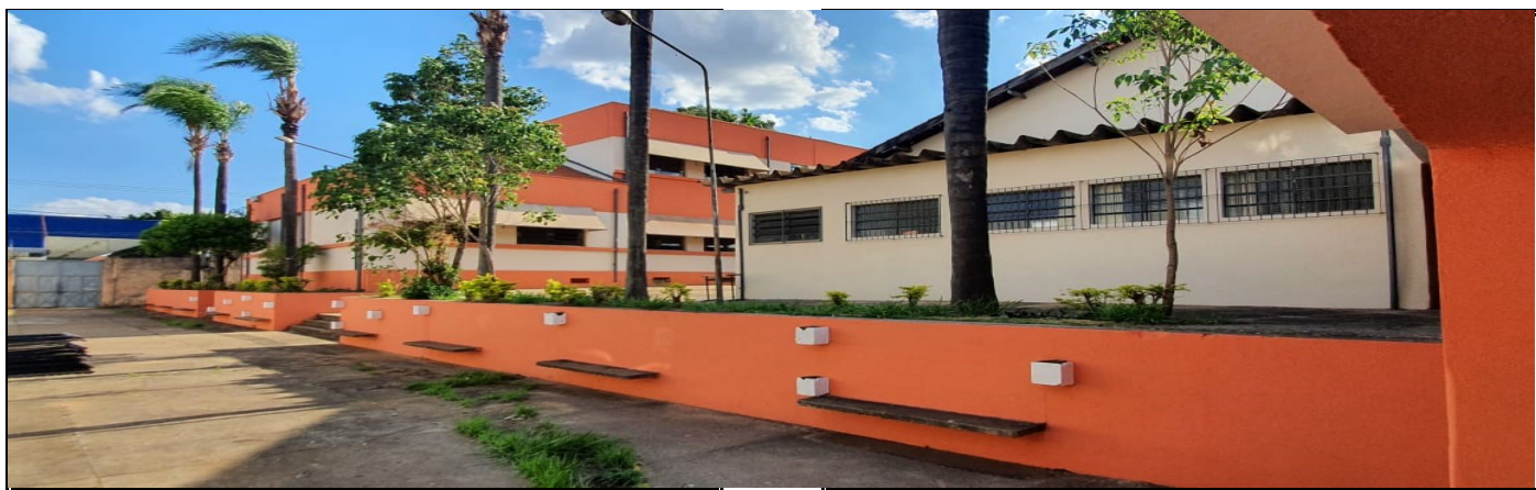
Pintura externa do prédio escolar
