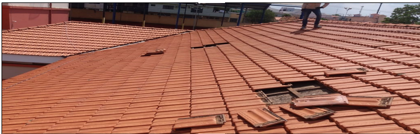
Troca de telhas de cerâmica
