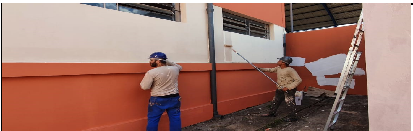
Pintura externa do prédio escolar
