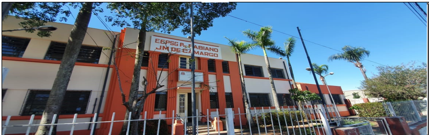
Pintura externa do prédio escolar
