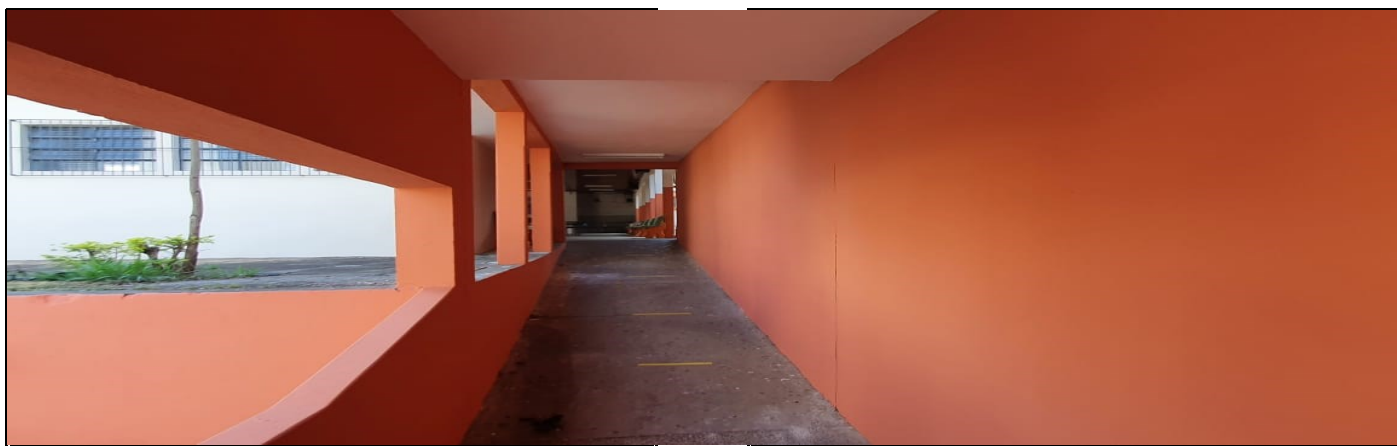
Pintura externa do prédio escolar
