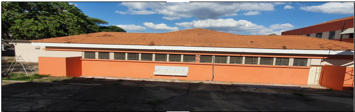
Pintura externa do prédio escolar
