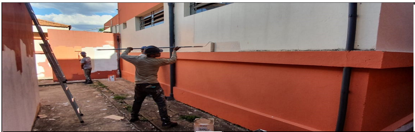
Pintura externa do prédio escolar
