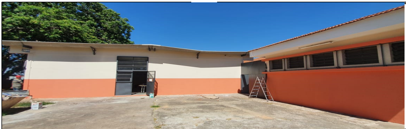
Pintura externa do prédio escolar
