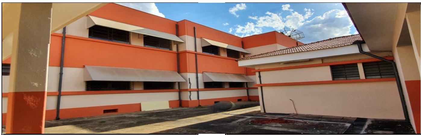
Pintura externa do prédio escolar
