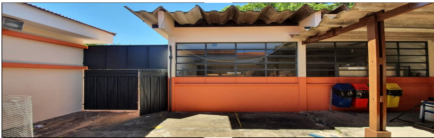
Pintura externa do prédio escolar
