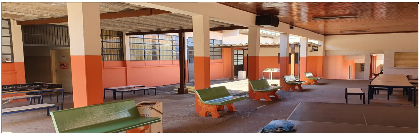
Pintura externa do prédio escolar
