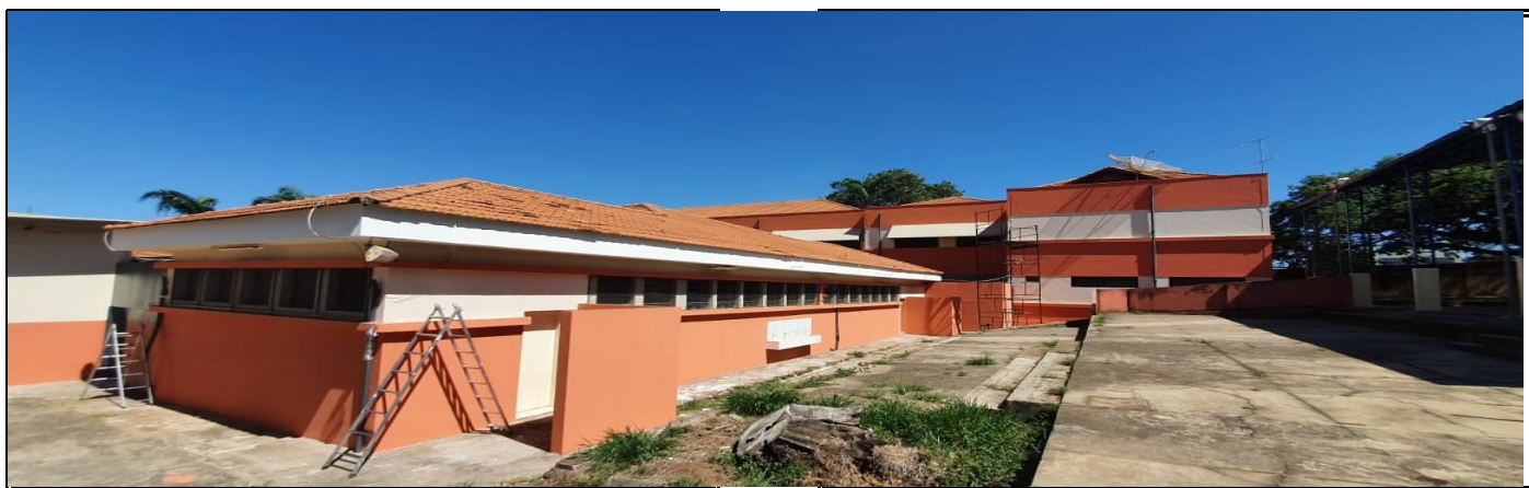
Pintura externa do prédio escolar
