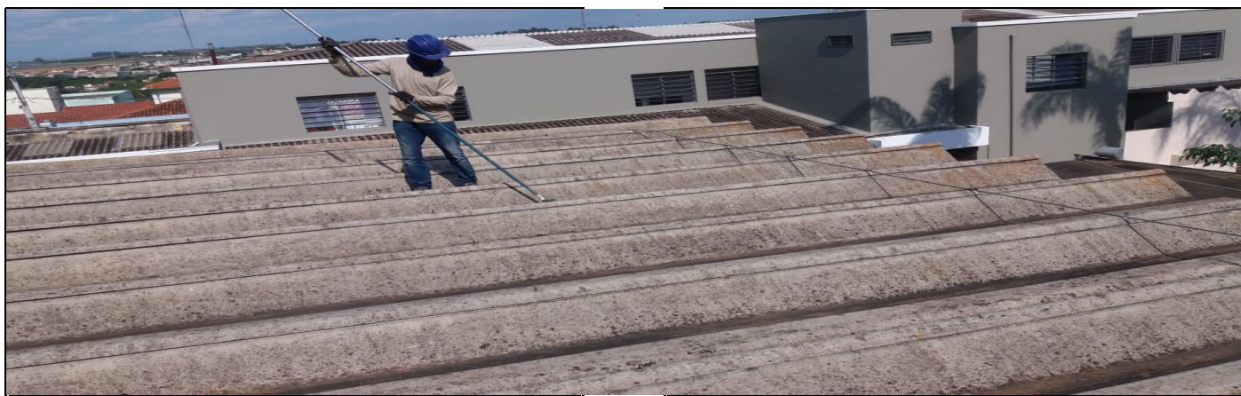
Limpeza do telhado
