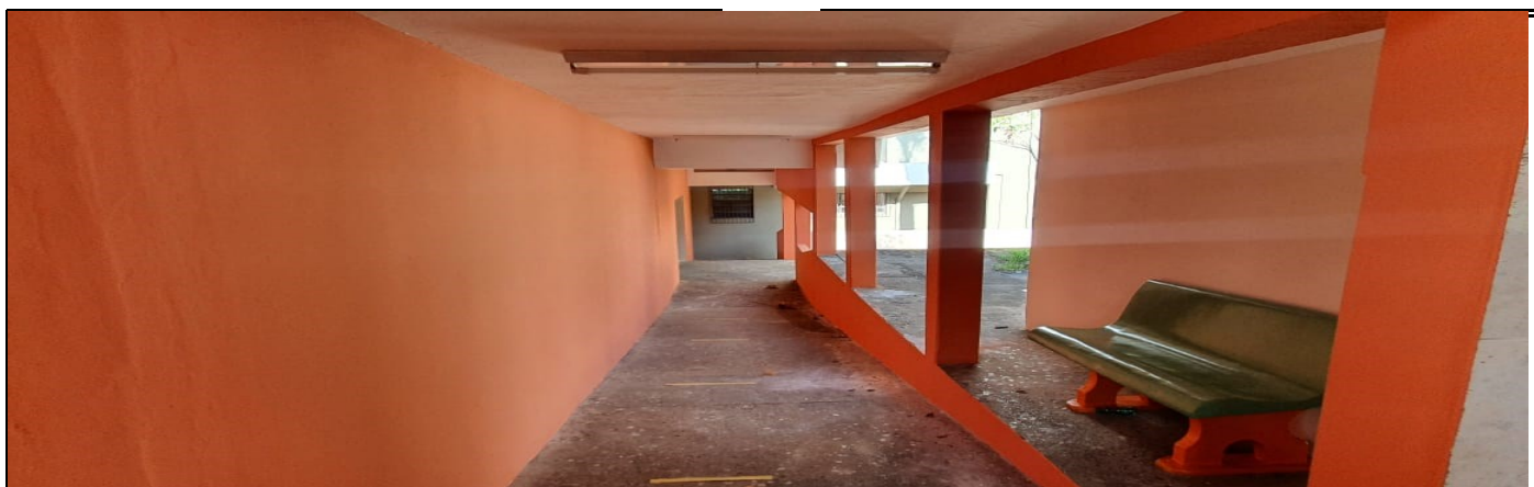
Pintura externa do prédio escolar
