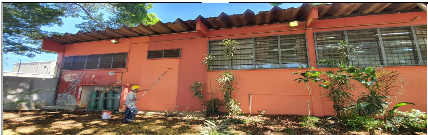
Pintura externa do prédio escolar
