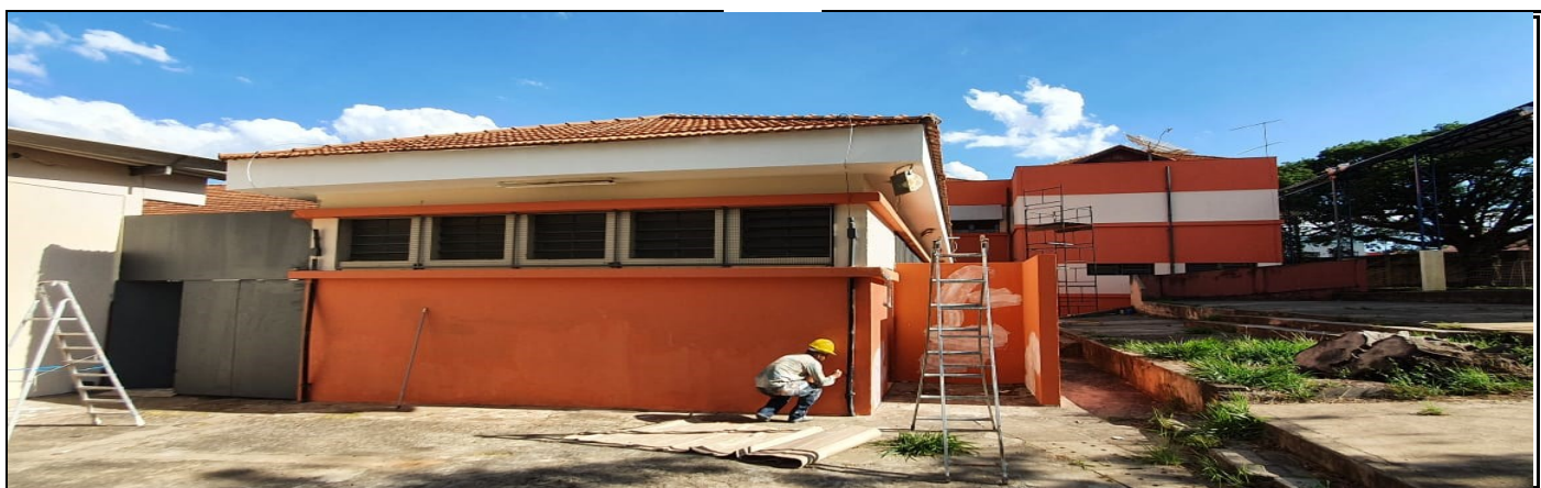
Pintura externa do prédio escolar
