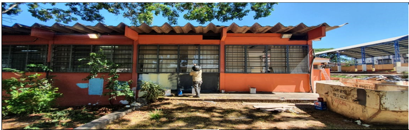
Pintura externa do prédio escolar
