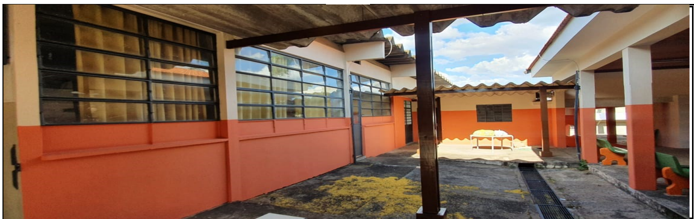
Pintura externa do prédio escolar
