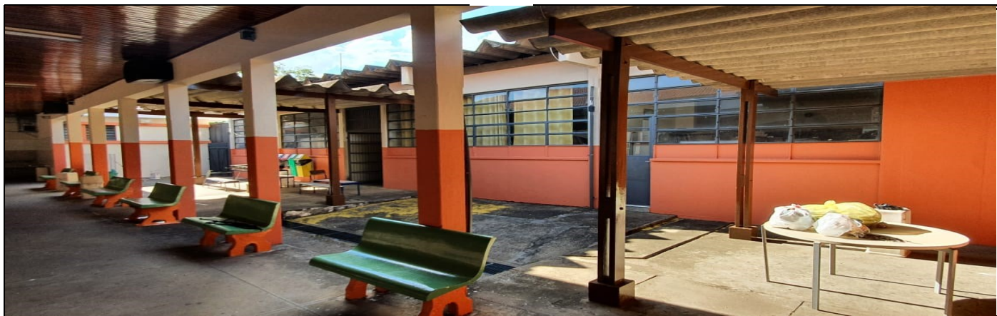
Pintura externa do prédio escolar
