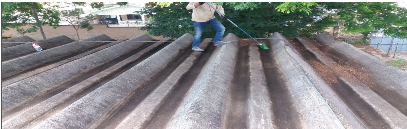
Limpeza do telhado
