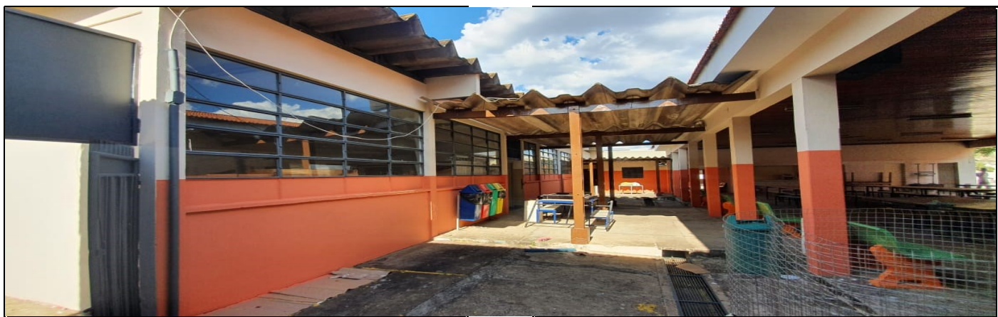
Pintura externa do prédio escolar
