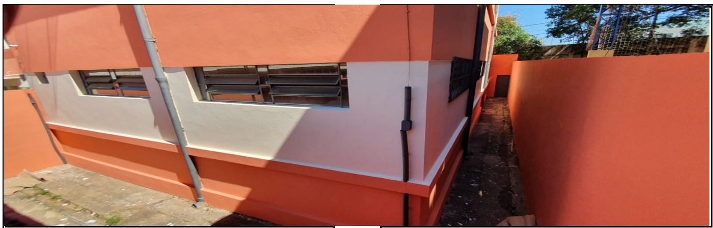
Pintura externa do prédio escolar
