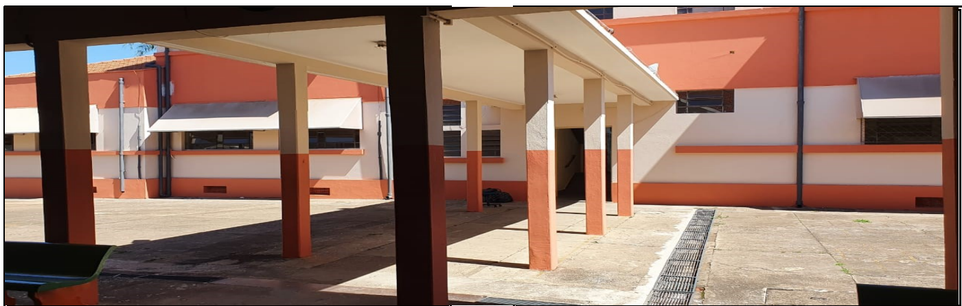
Pintura externa do prédio escolar
