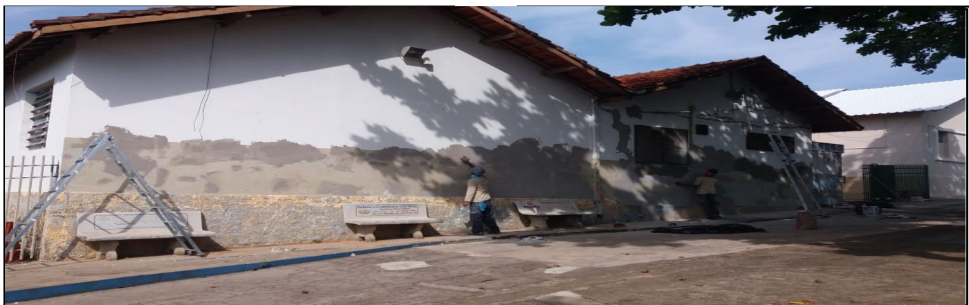
Pintura na parte externa do prédio escolar
