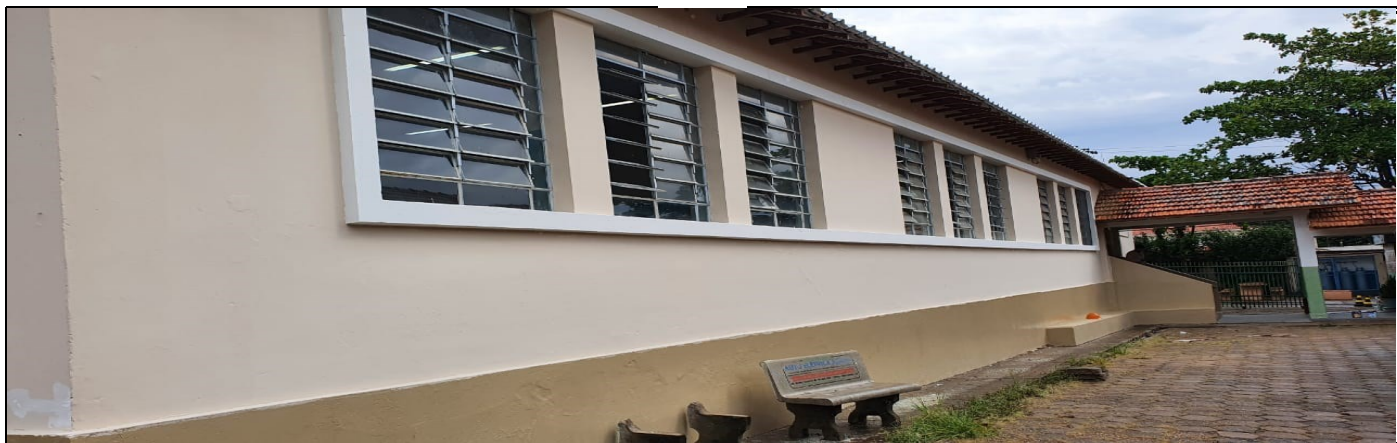
Pintura na parte externa do prédio escolar
