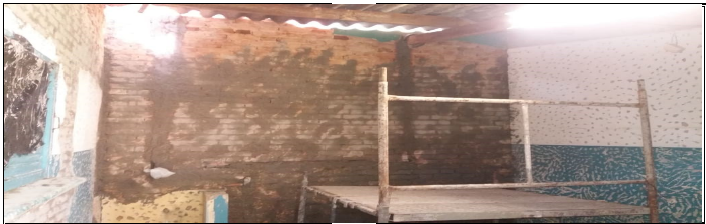
Colocação de revestimento na sala das faxineiras
