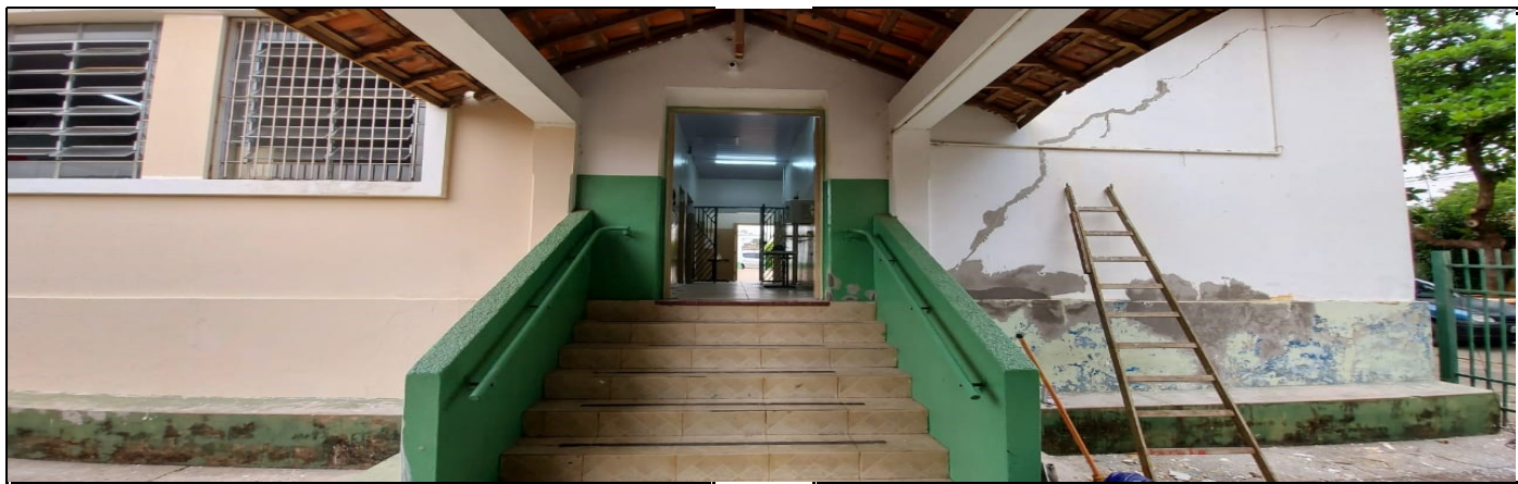
Pintura na parte externa do prédio escolar
