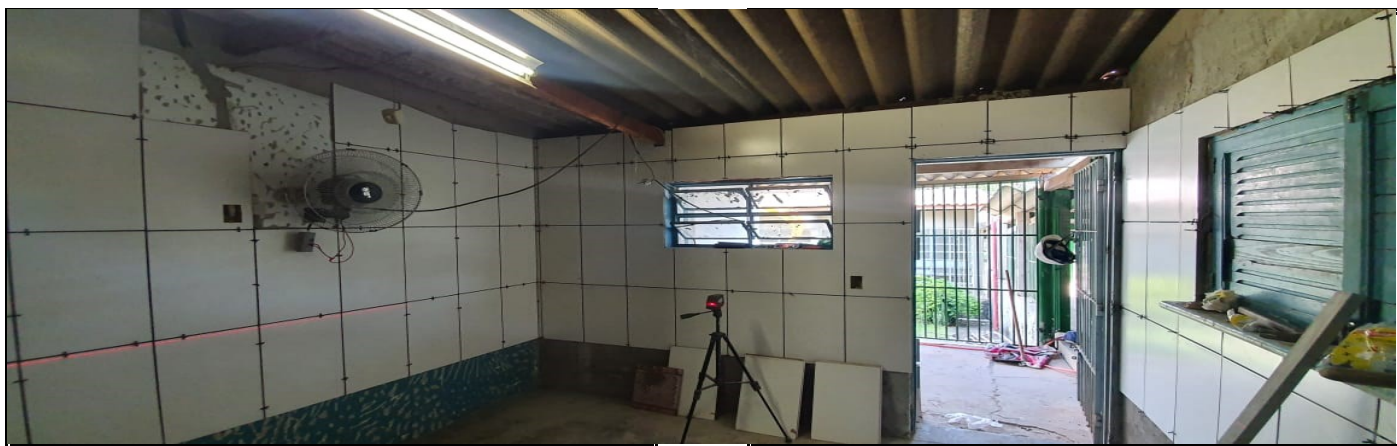
Colocação de revestimento na sala das faxineiras
