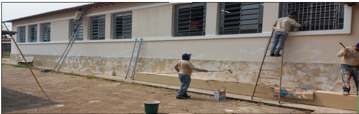
Pintura na parte externa do prédio escolar
