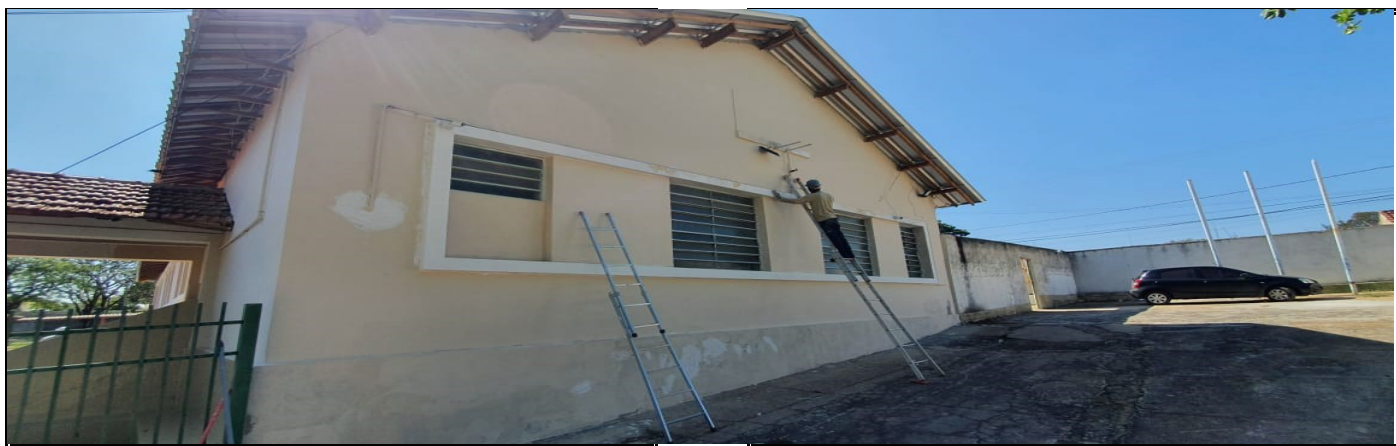
Pintura na parte externa do prédio escolar
