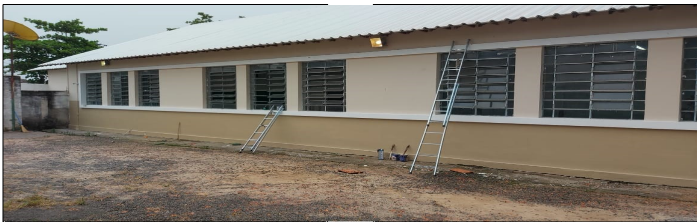
Pintura na parte externa do prédio escolar
