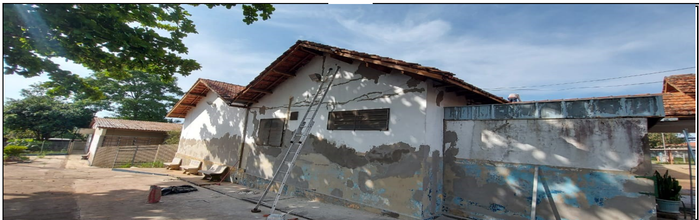
Pintura na parte externa do prédio escolar
