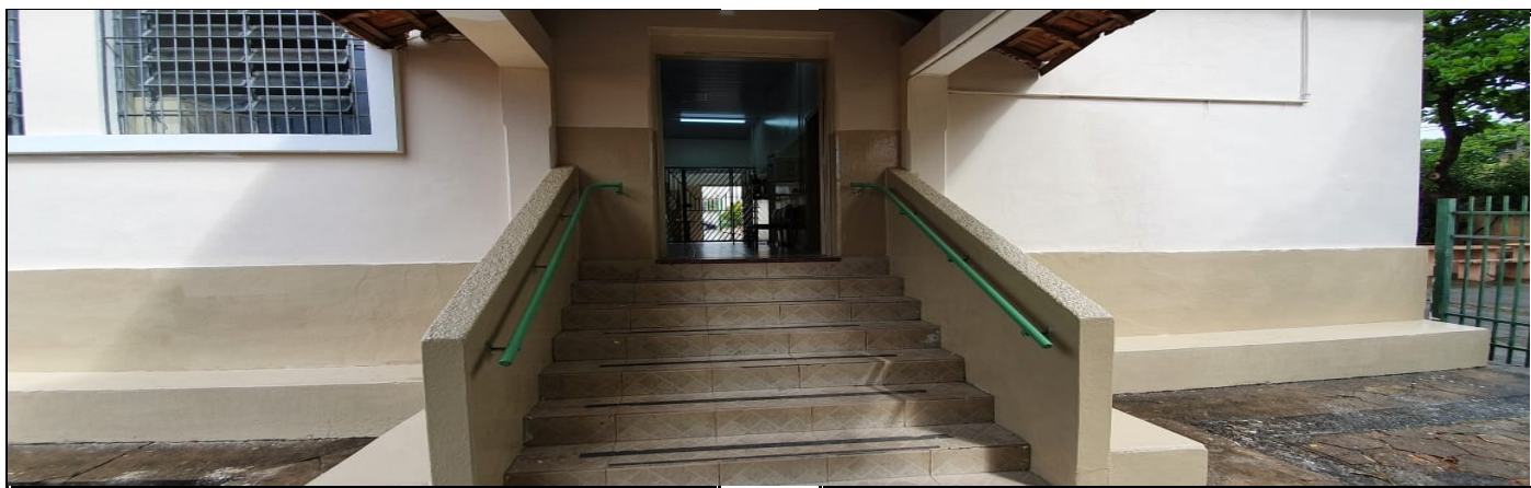
Pintura na parte externa do prédio escolar
