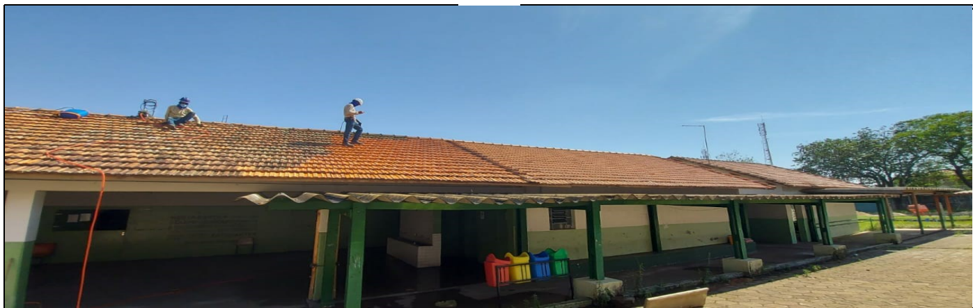
Limpeza do telhado e troca de telhas quebradas
