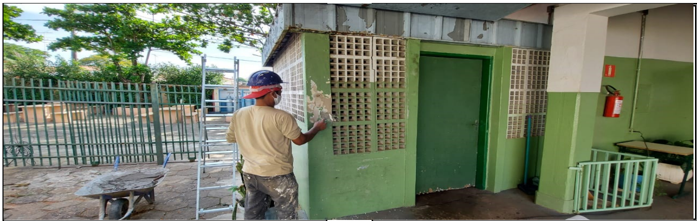
Pintura na parte externa do prédio escolar
