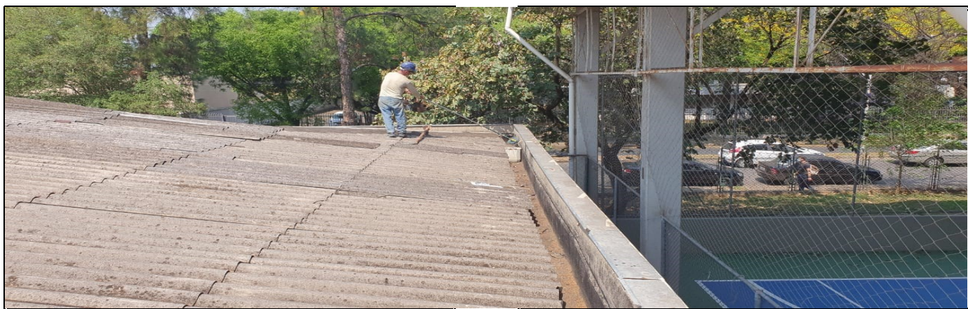
Limpeza das calhas e telhado
