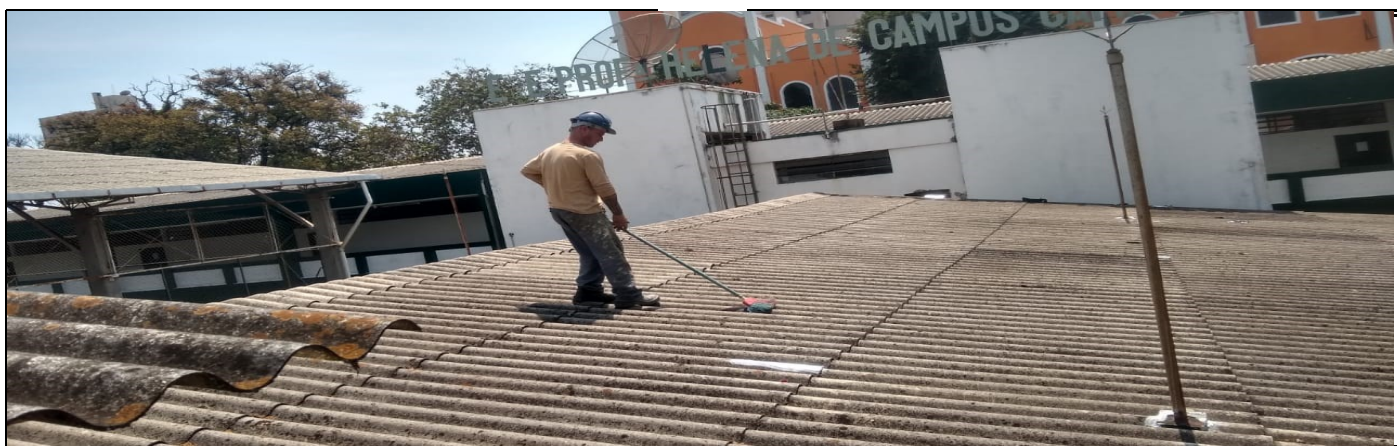
Limpeza das calhas e telhado
