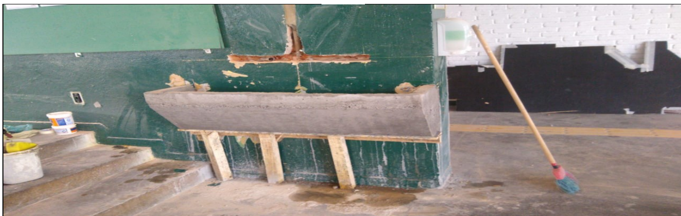
Construção de um lavatório no pátio coberto
