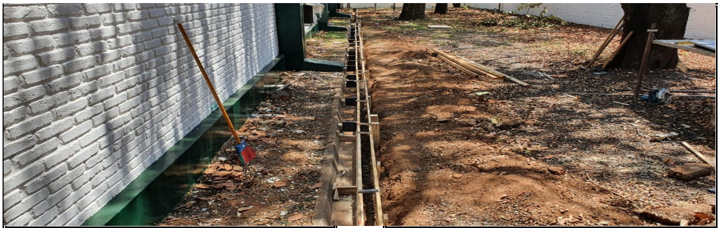
Reconstrução de canaleta pluvial
