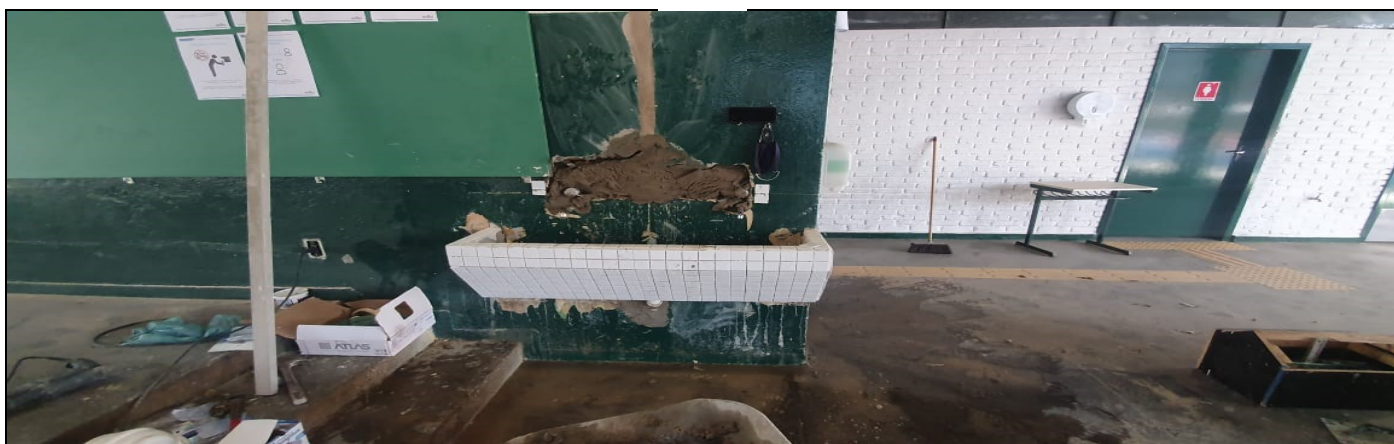
Construção de um lavatório no pátio coberto
