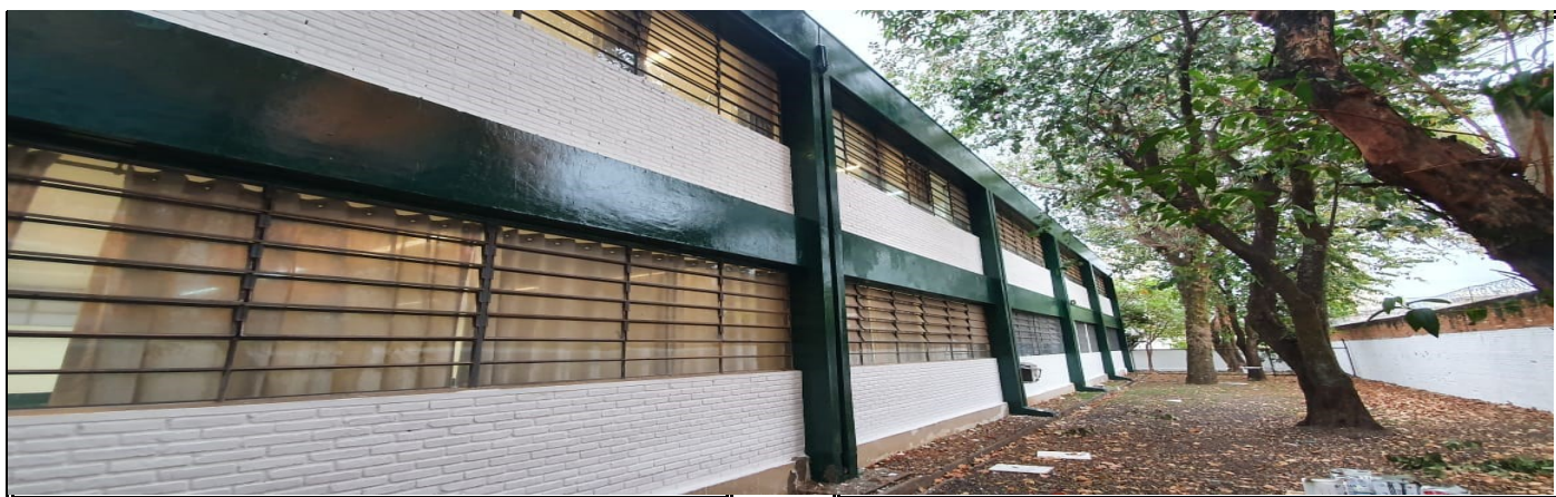
Pintura da parte externa do prédio escolar
