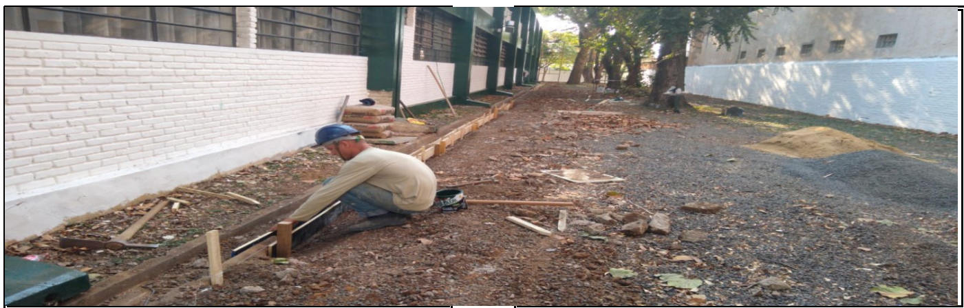
Reconstrução de canaleta pluvial
