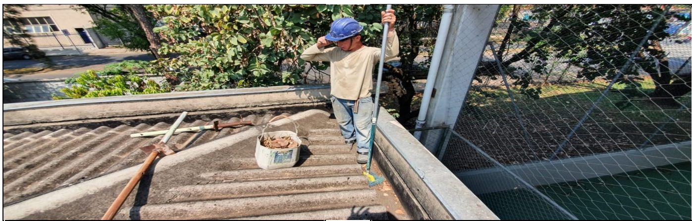
Limpeza das calhas e telhado
