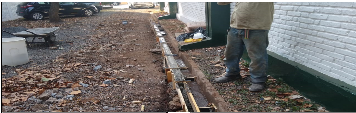
Reconstrução de canaleta pluvial
