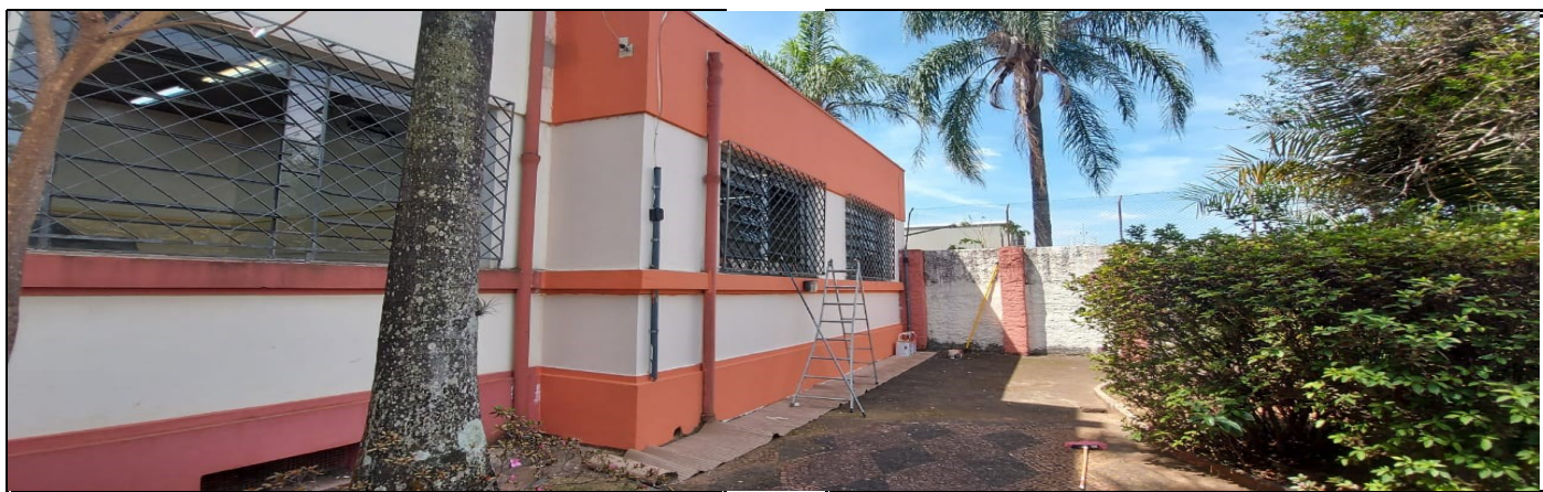
Pintura da parte externa do prédio escolar
