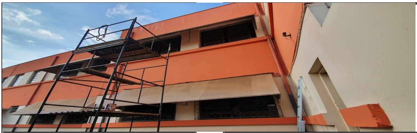
Pintura da parte externa do prédio escolar
