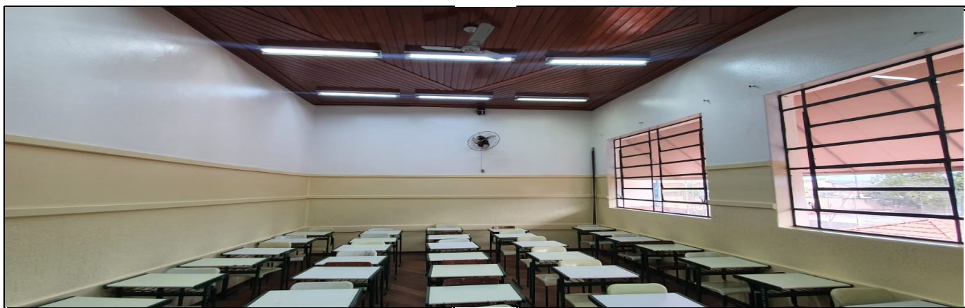
Pintura da parte interna do prédio escolar
