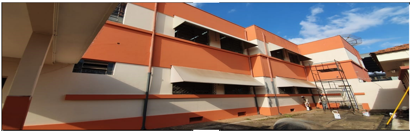
Pintura da parte externa do prédio escolar
