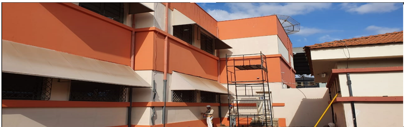
Pintura da parte externa do prédio escolar
