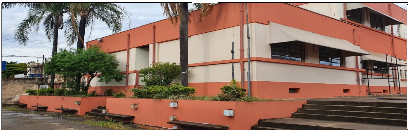
Pintura da parte externa do prédio escolar
