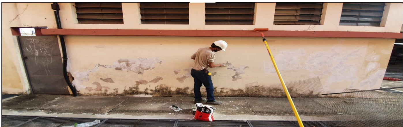
Pintura da parte externa do prédio escolar
