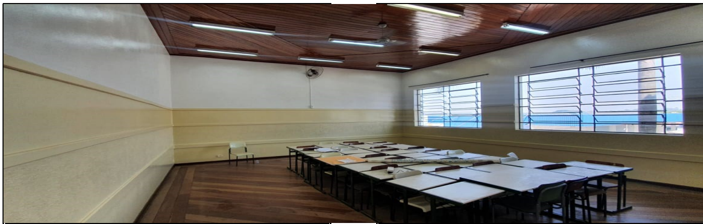
Pintura da parte interna do prédio escolar
