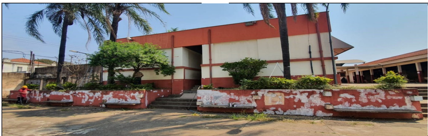
Pintura da parte externa do prédio escolar
