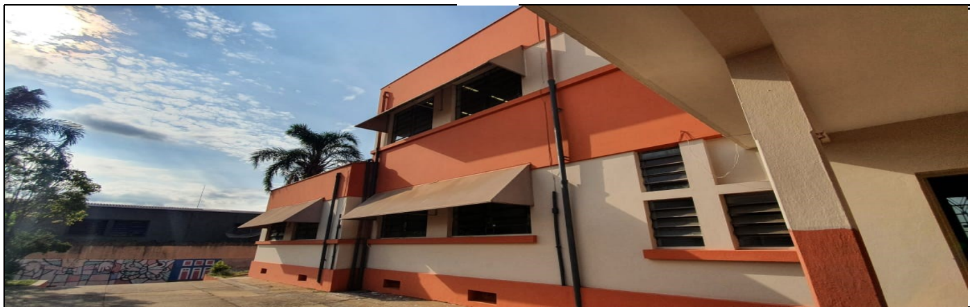
Pintura da parte externa do prédio escolar
