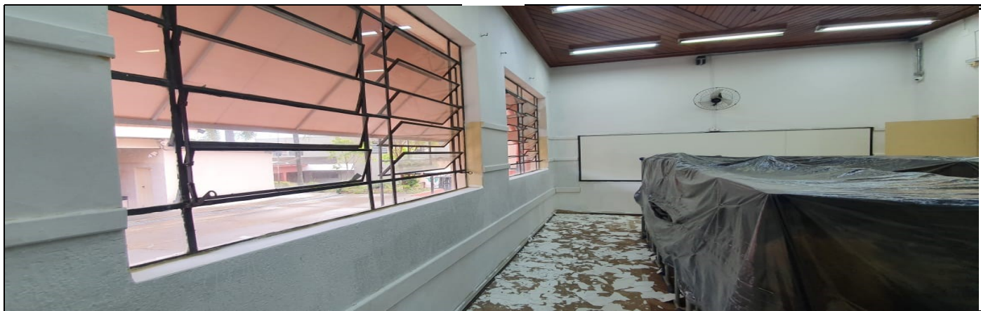
Pintura da parte interna do prédio escolar
