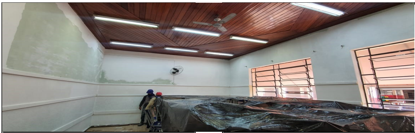
Pintura da parte interna do prédio escolar
