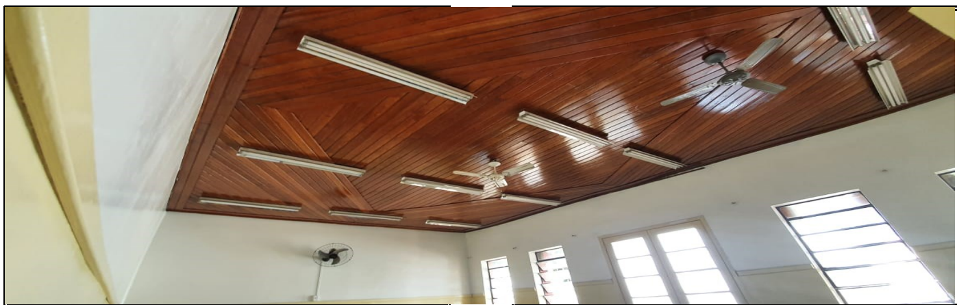
Pintura da parte interna do prédio escolar
