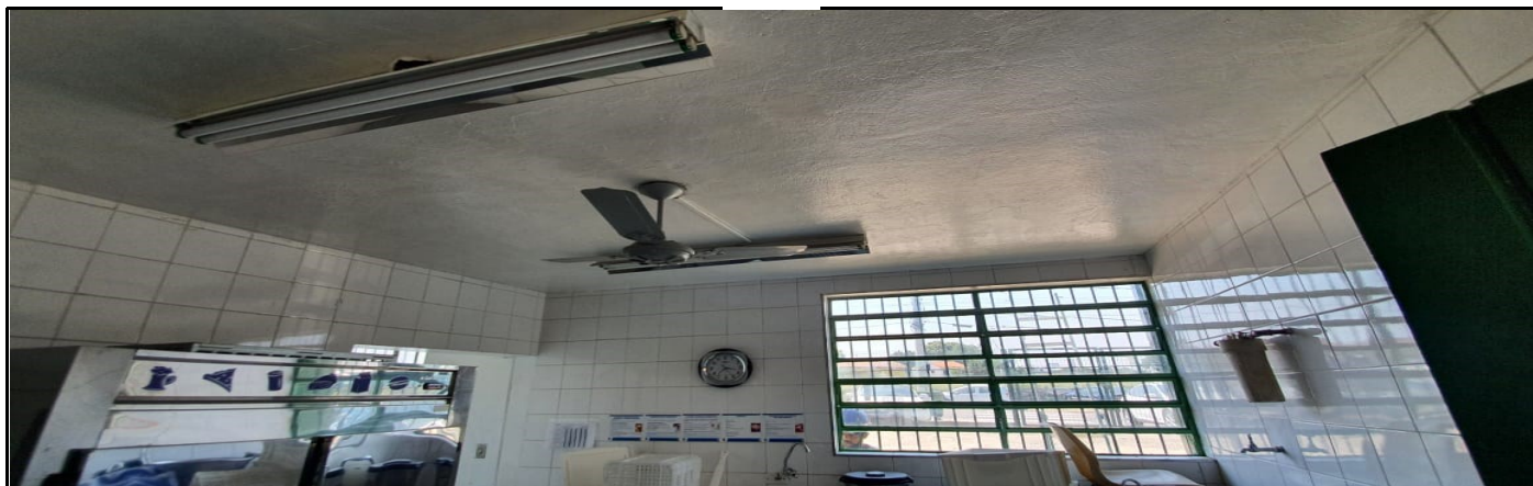
Pintura da cozinha
