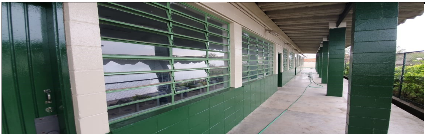
Pintura da parte externa do prédio escolar
