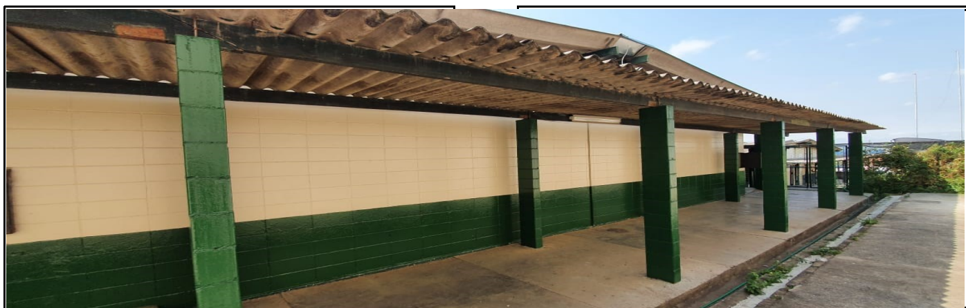
Pintura da parte externa do prédio escolar
