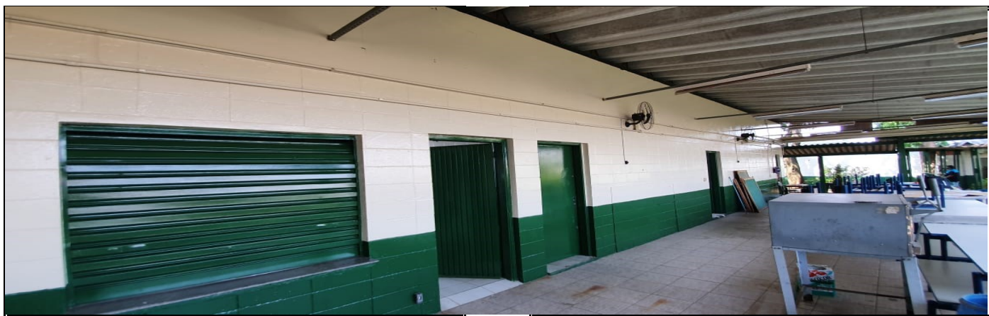
Pintura da parte externa do prédio escolar
