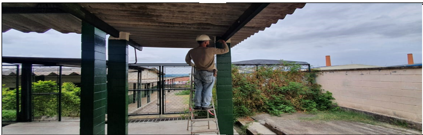
Pintura da parte externa do prédio escolar
