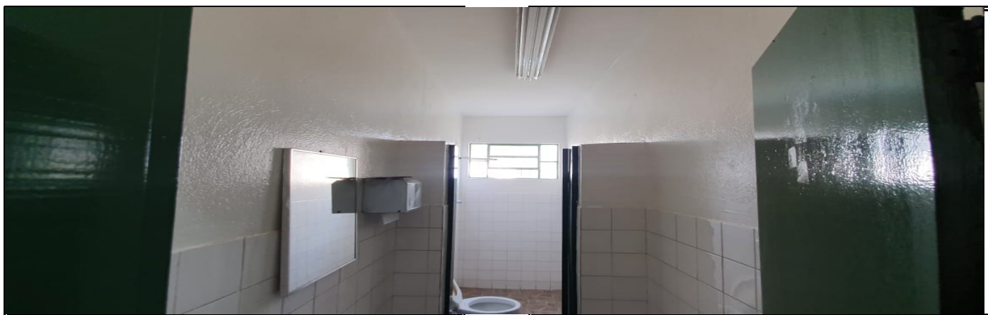
Pintura dos sanitários administrativos
