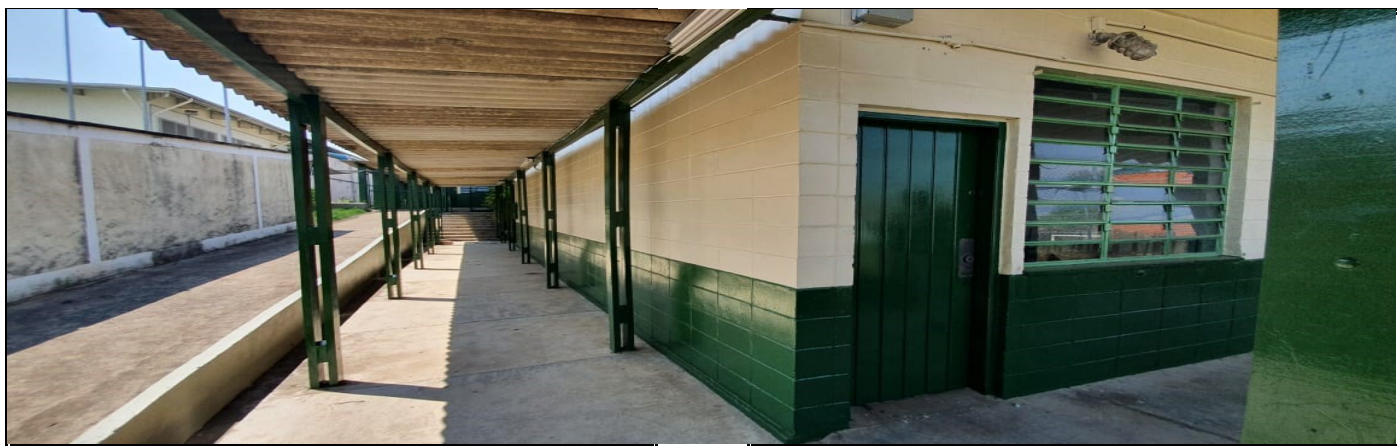
Pintura da parte externa do prédio escolar
