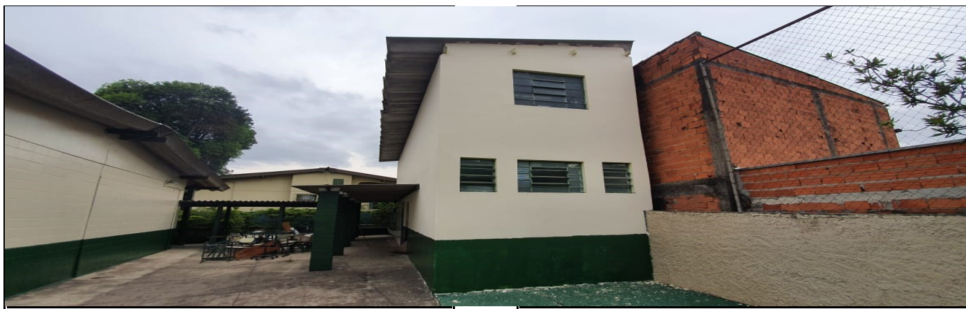
Pintura da parte externa do prédio escolar
