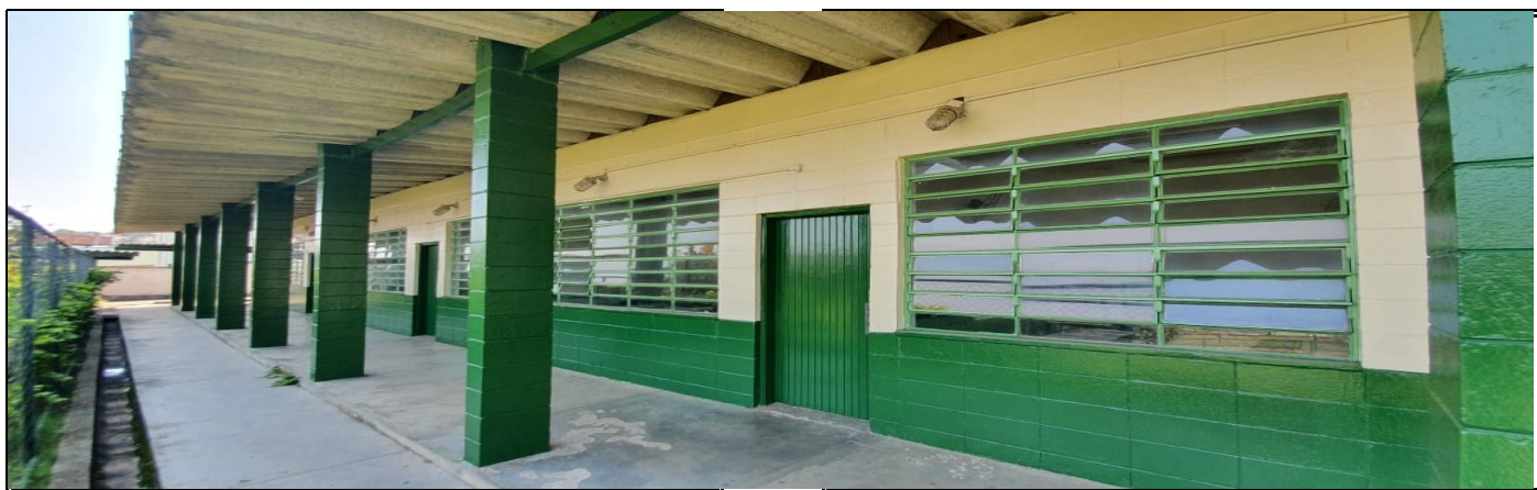
Pintura da parte externa do prédio escolar
