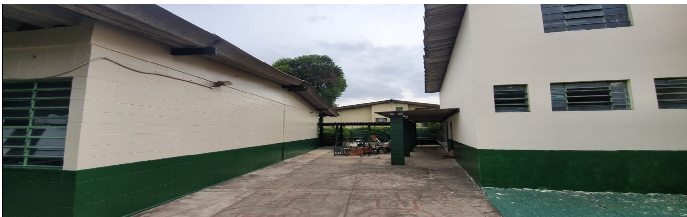
Pintura da parte externa do prédio escolar
