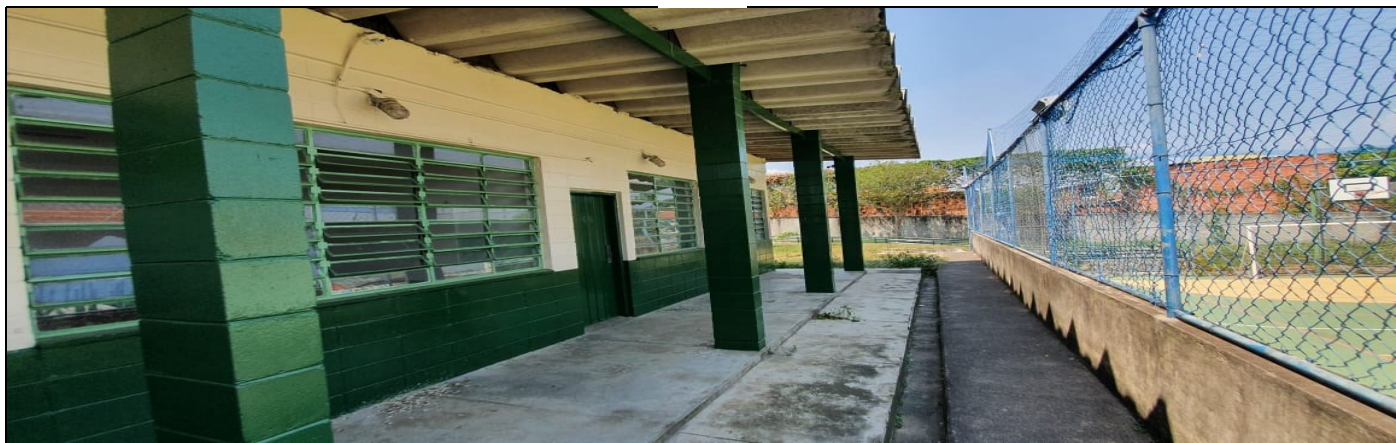
Pintura da parte externa do prédio escolar
