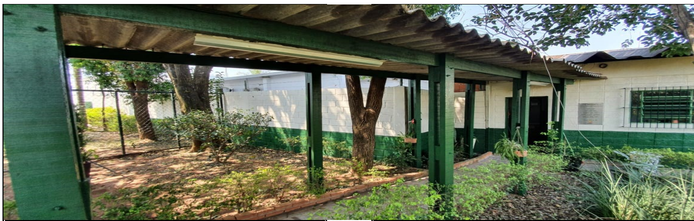
Pintura da parte externa do prédio escolar
