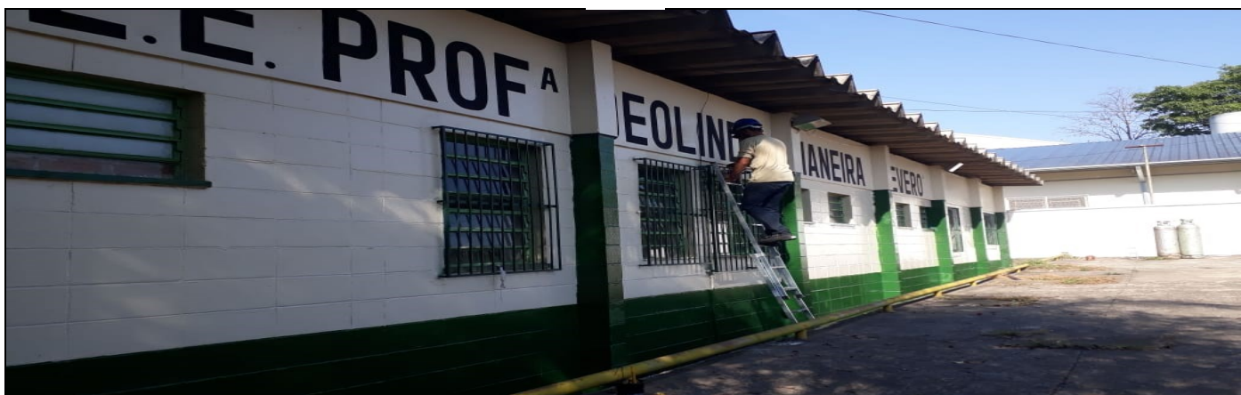
Pintura da parte externa do prédio escolar
