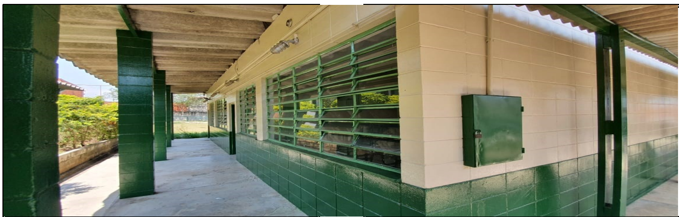
Pintura da parte externa do prédio escolar
