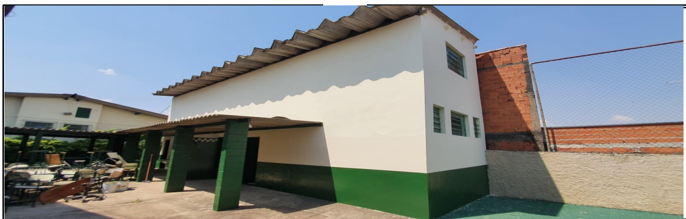
Pintura da parte externa do prédio escolar
