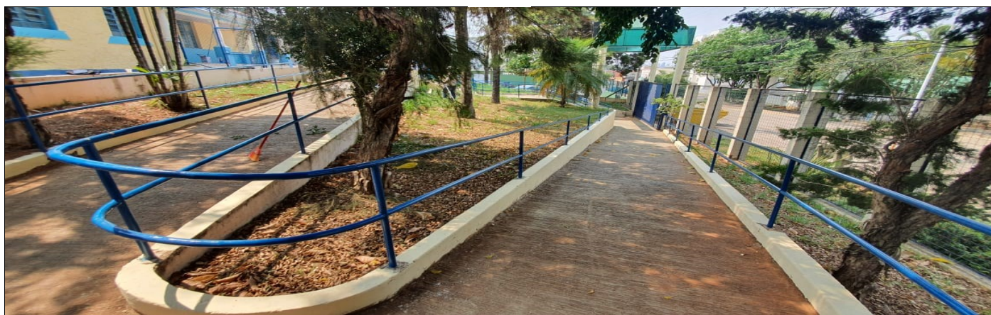
Pintura externa do prédio escolar
