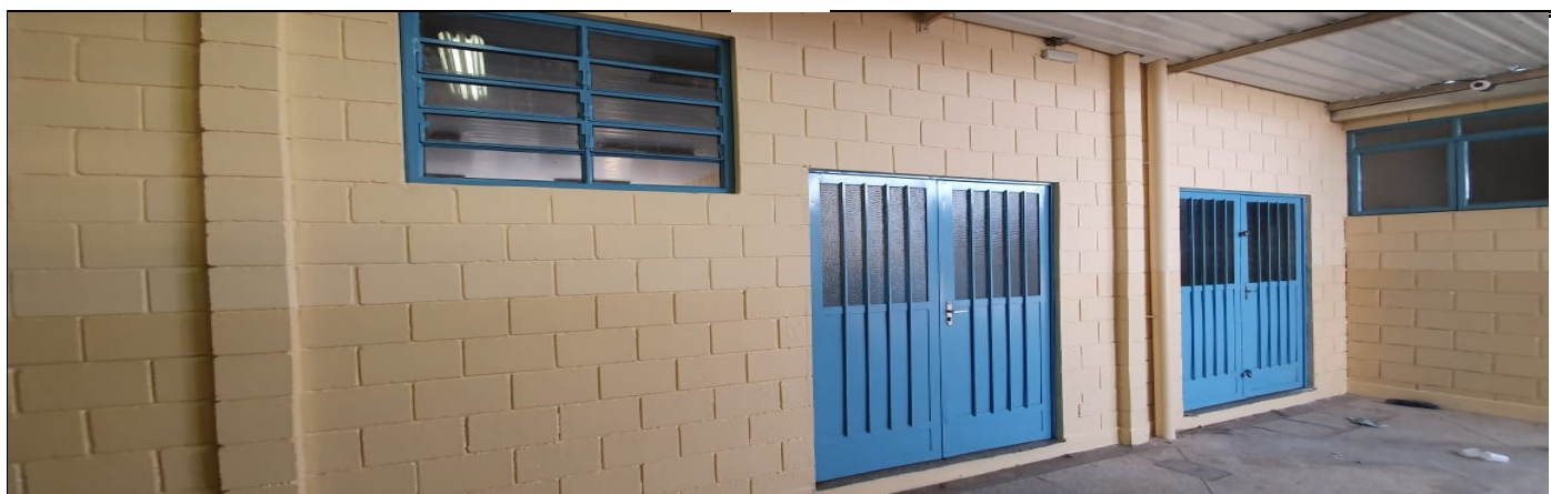
Pintura externa do prédio escolar
