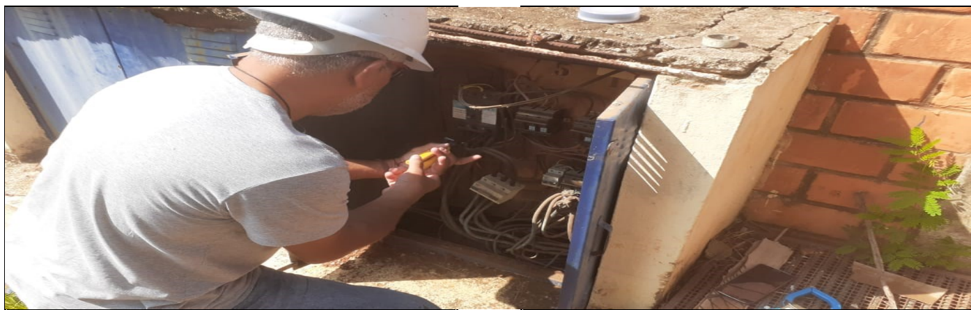
Manutenção da caixa elétrica
