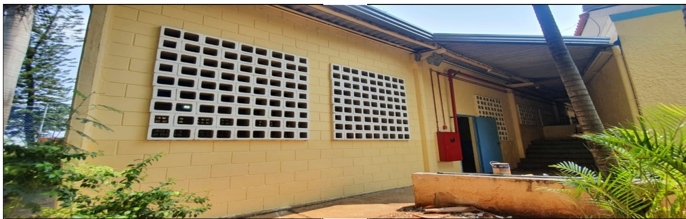
Pintura externa do prédio escolar
