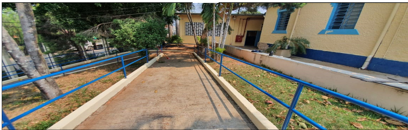
Pintura externa do prédio escolar
