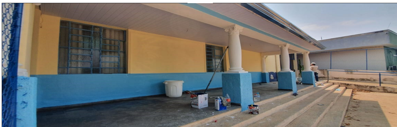
Pintura externa do prédio escolar
