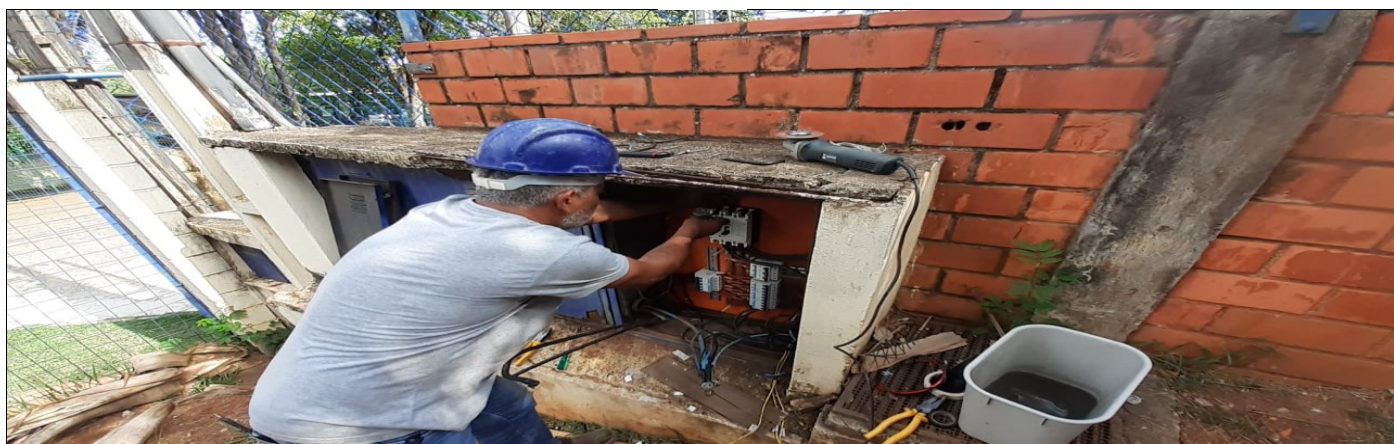
Manutenção da caixa elétrica
