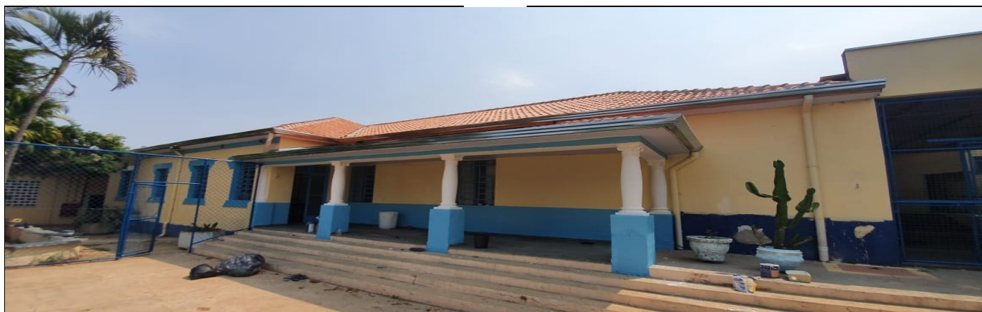
Pintura externa do prédio escolar
