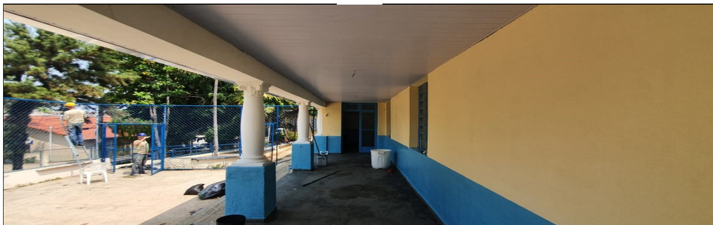
Pintura externa do prédio escolar
