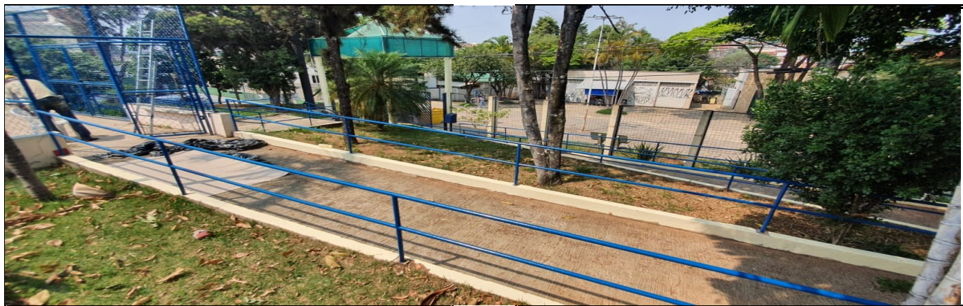
Pintura externa do prédio escolar
