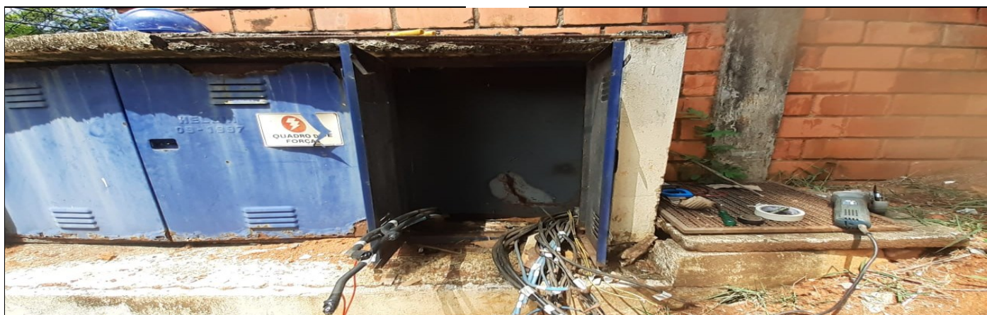
Manutenção da caixa elétrica
