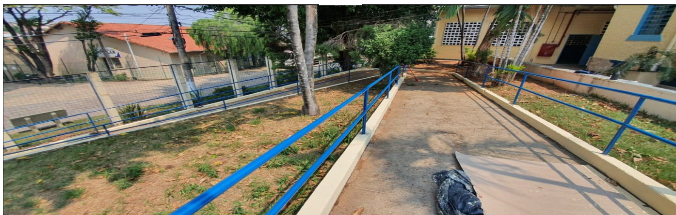
Pintura externa do prédio escolar
