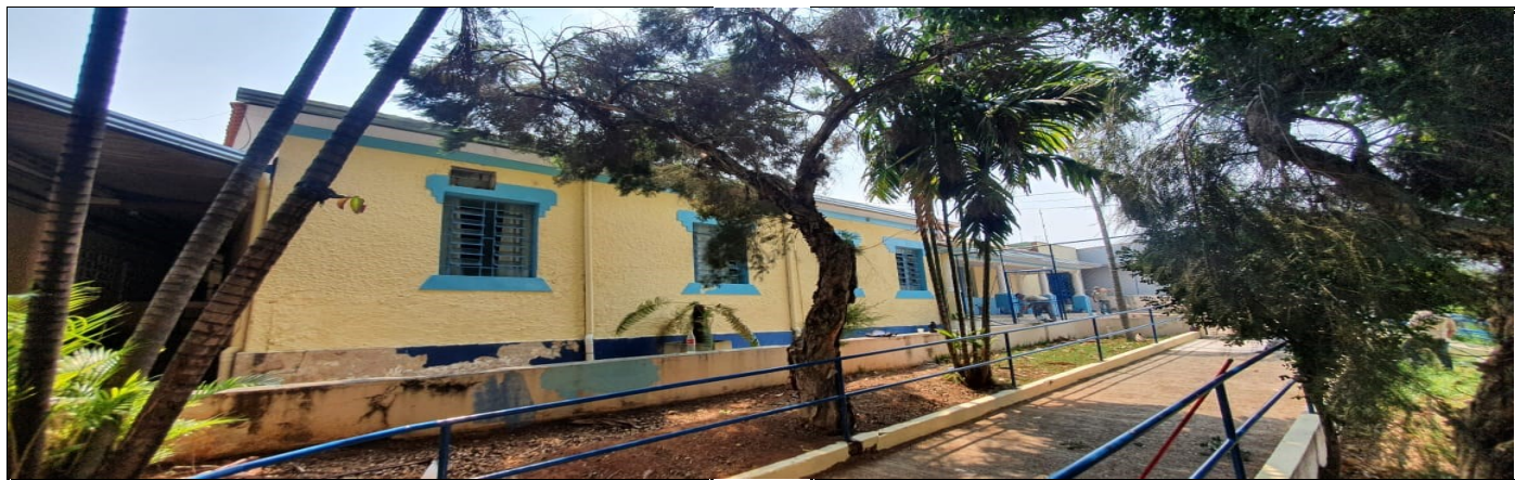
Pintura externa do prédio escolar
