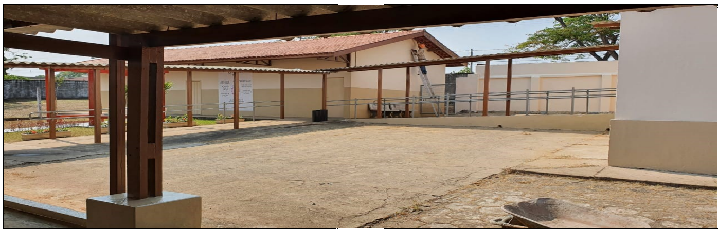
Pintura externa do prédio escolar
