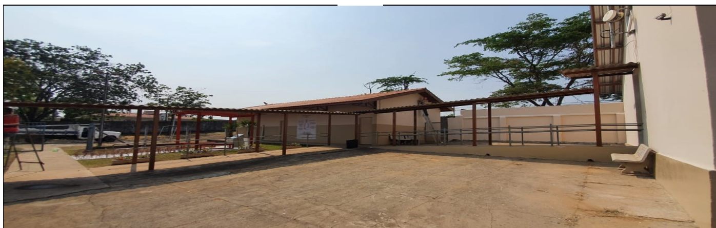
Pintura externa do prédio escolar
