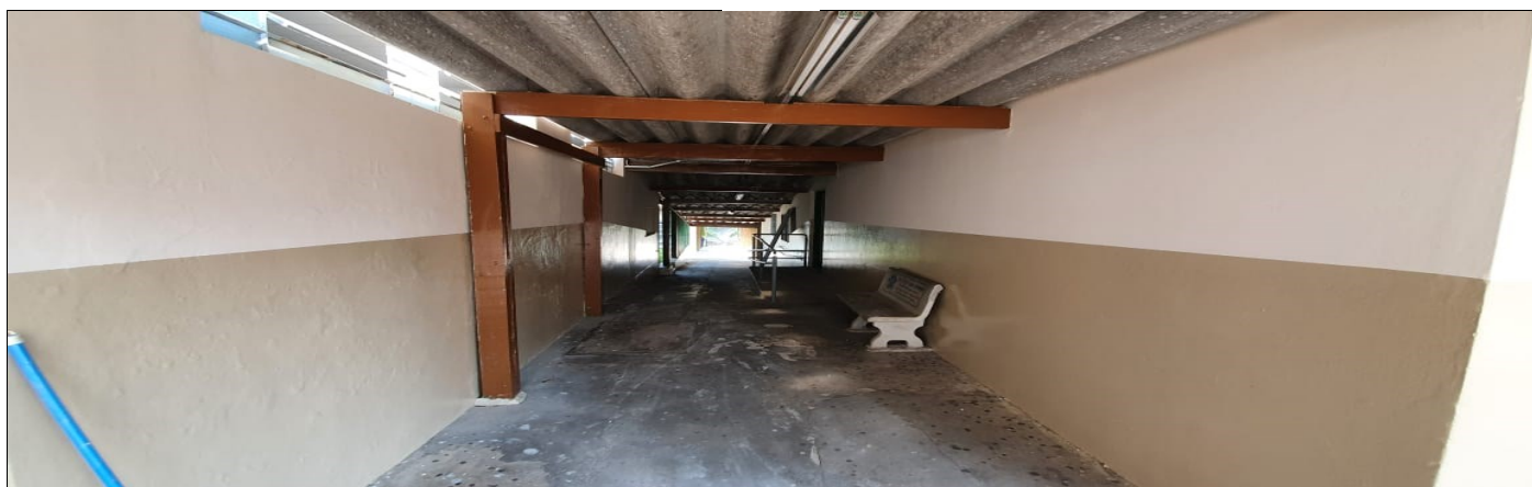
Pintura externa do prédio escolar
