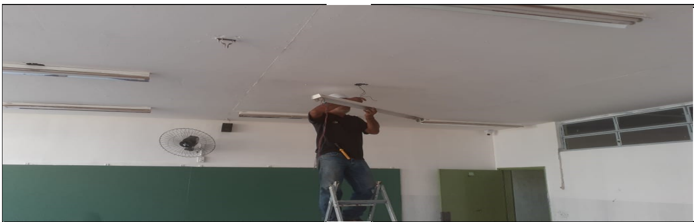
Manutenção elétrica - troca de lâmpadas
