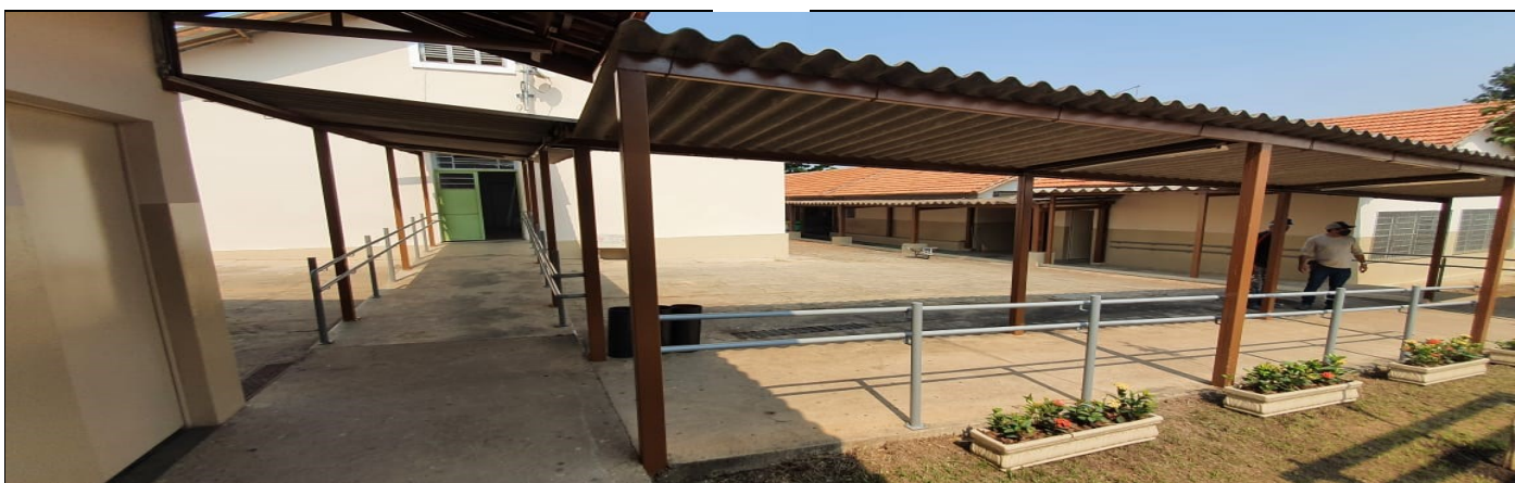
Pintura externa do prédio escolar
