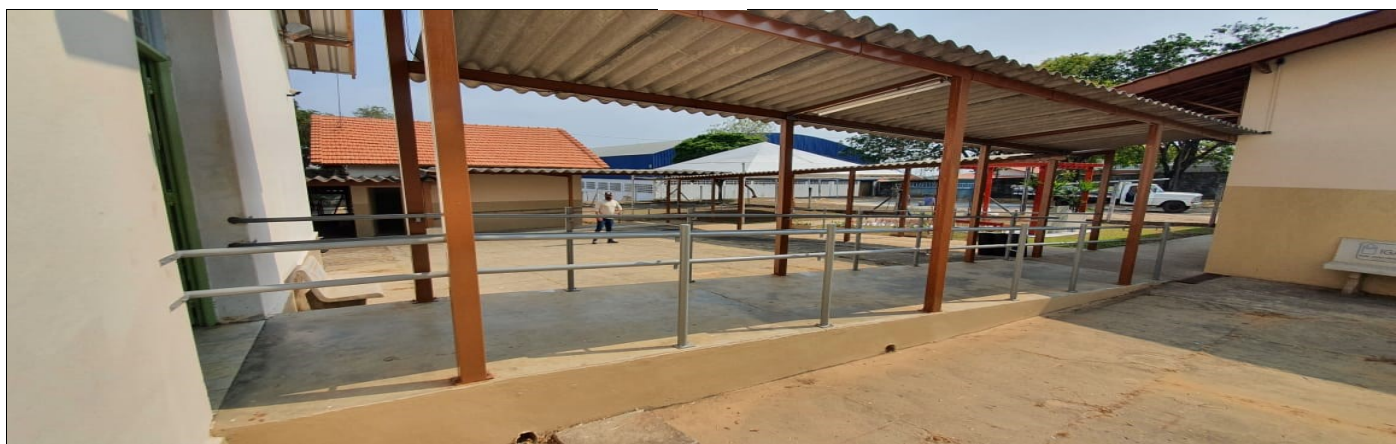
Pintura externa do prédio escolar
