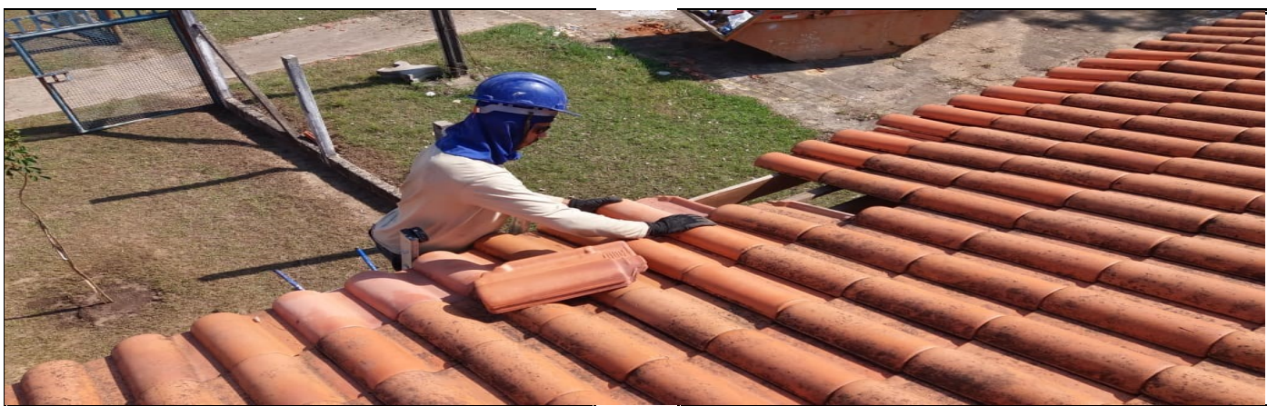
Troca de telhas
