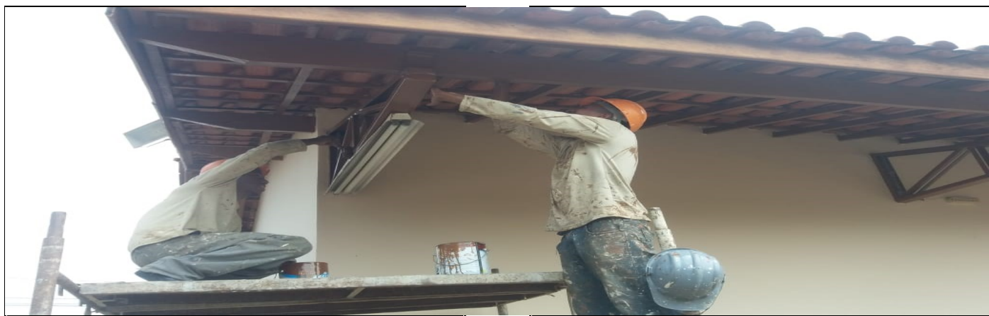
Pintura externa do prédio escolar
