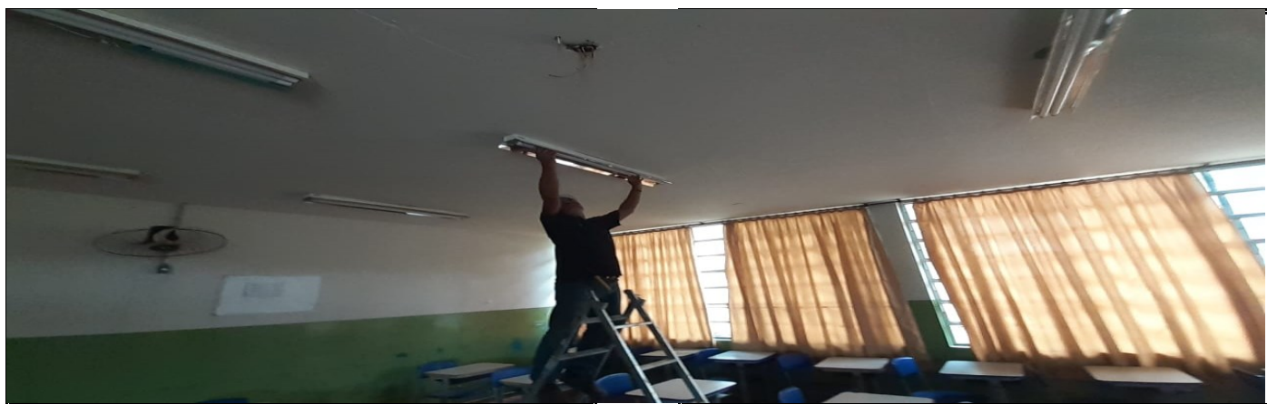
Manutenção elétrica - troca de lâmpadas
