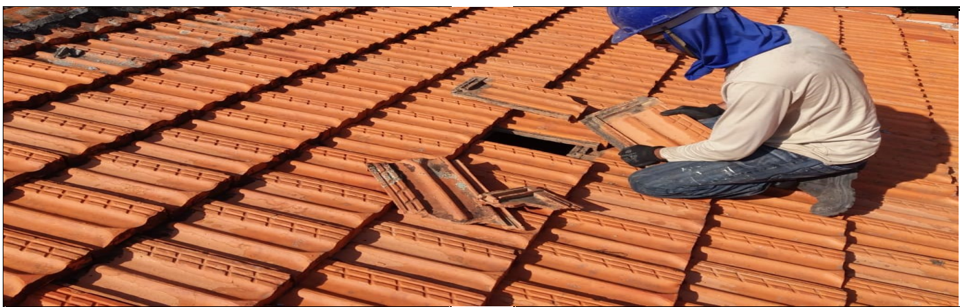
Troca de telhas
