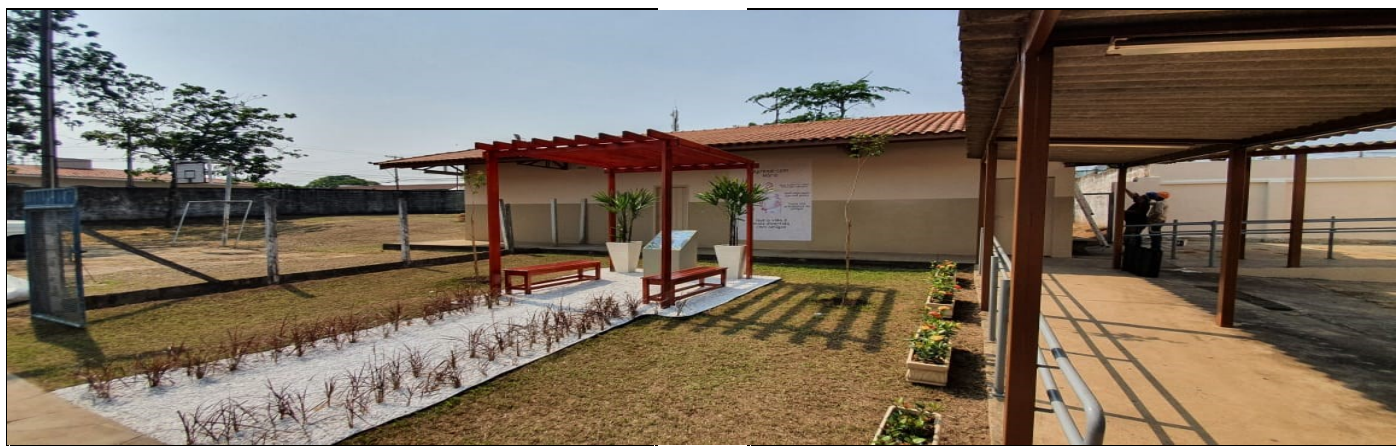
Pintura externa do prédio escolar
