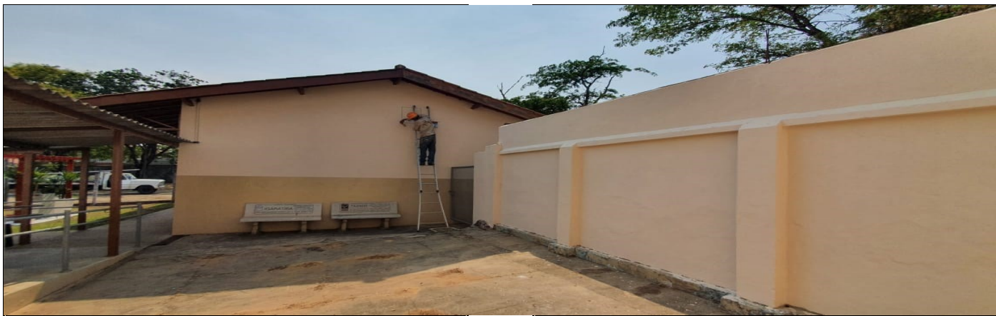
Pintura externa do prédio escolar
