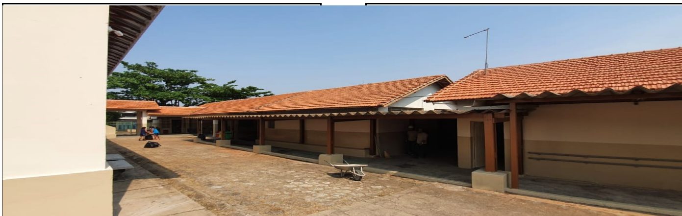
Pintura externa do prédio escolar
