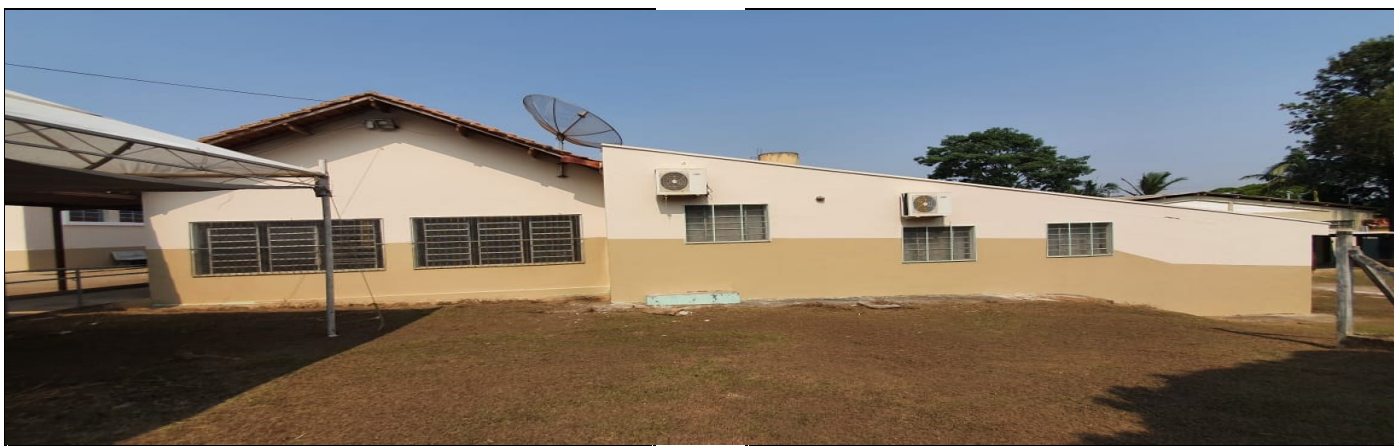
Pintura externa do prédio escolar
