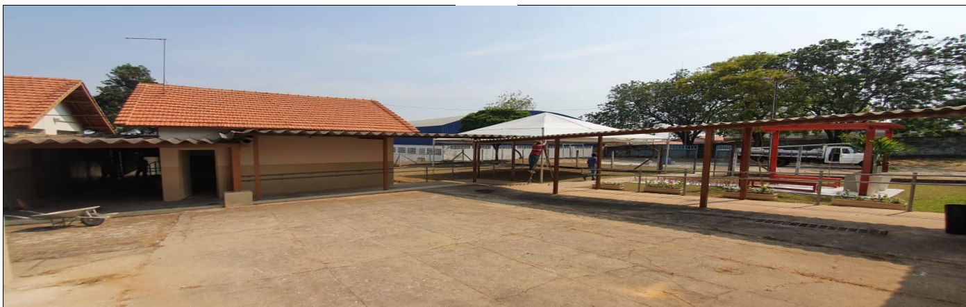
Pintura externa do prédio escolar
