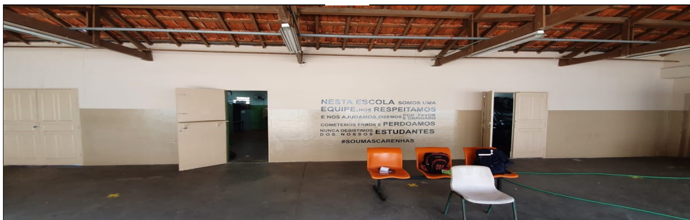
Pintura externa do prédio escolar
