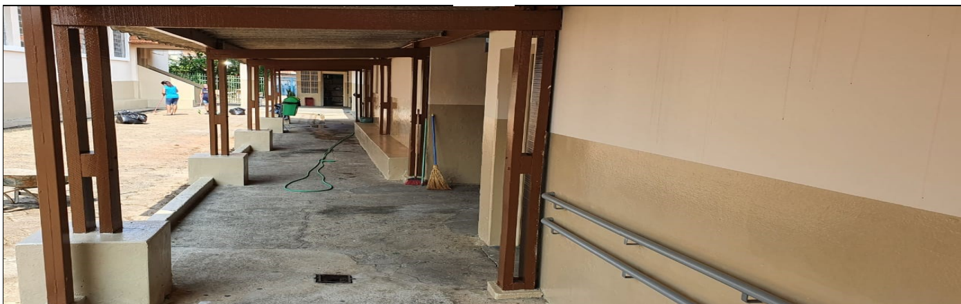
Pintura externa do prédio escolar
