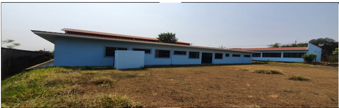
Pintura da parte externa do prédio escolar
