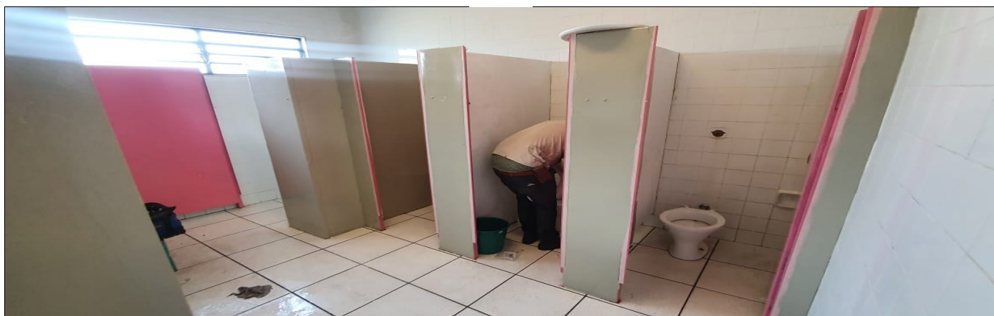
Desentupimento dos vasos sanitários
