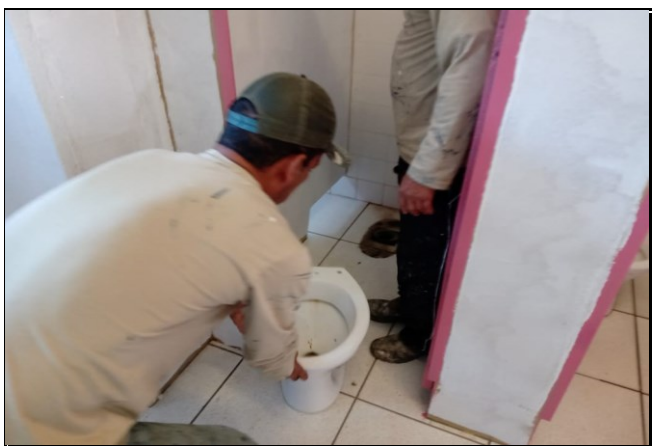
Desentupimento dos vasos sanitários e troca de válvulas
