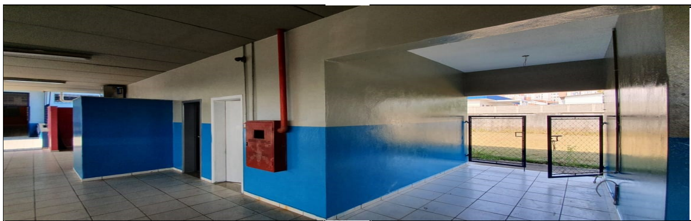
Pintura da parte externa do prédio escolar
