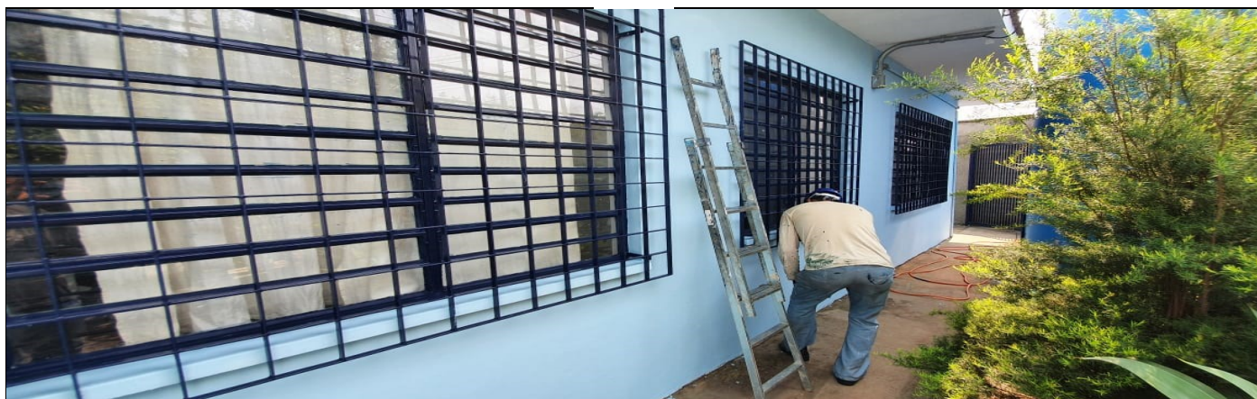
Pintura da parte externa do prédio escolar
