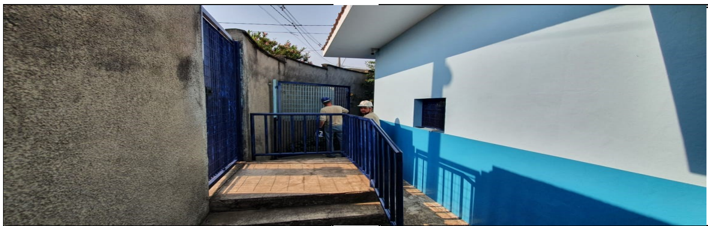
Pintura da parte externa do prédio escolar
