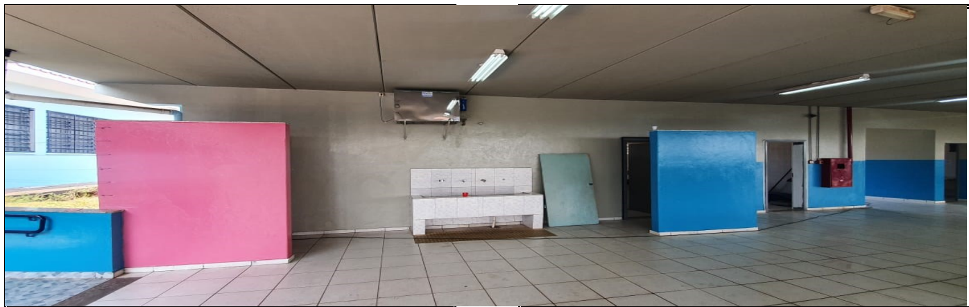
Pintura da parte externa do prédio escolar
