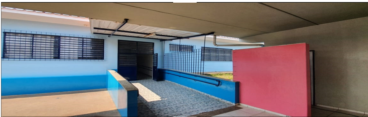
Pintura da parte externa do prédio escolar
