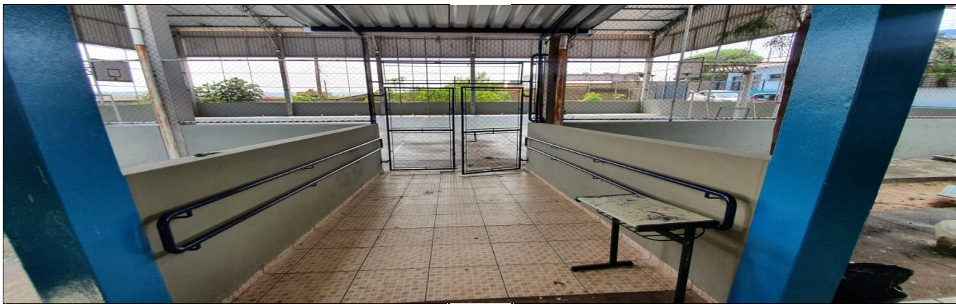
Pintura da parte externa do prédio escolar
