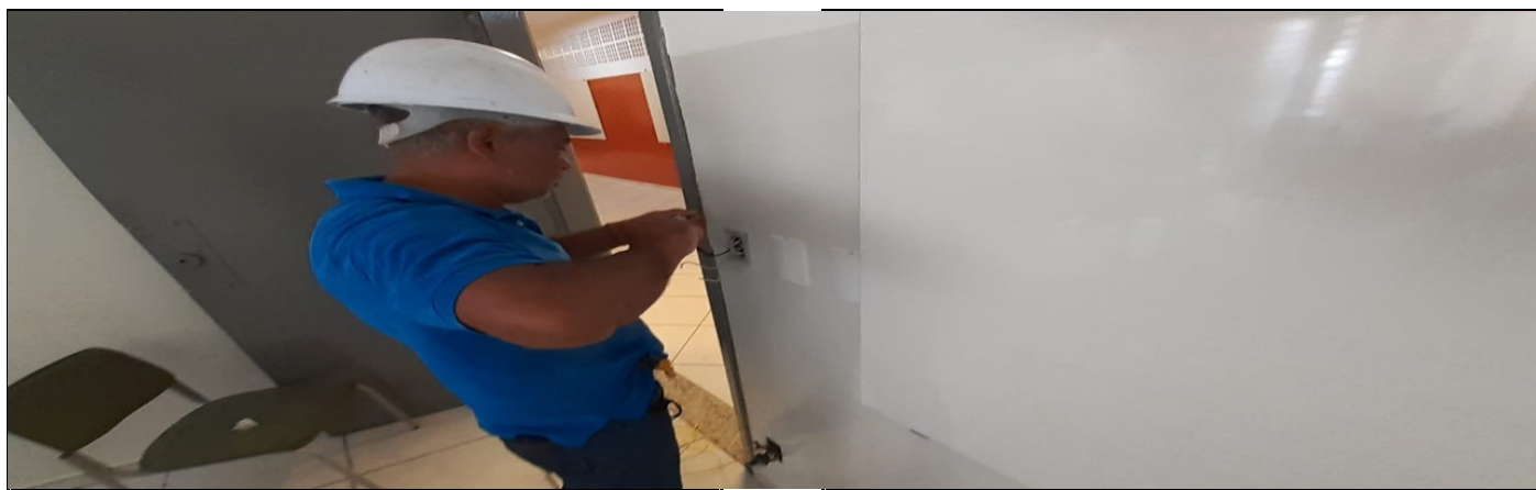
Manutenção e troca de tomadas
