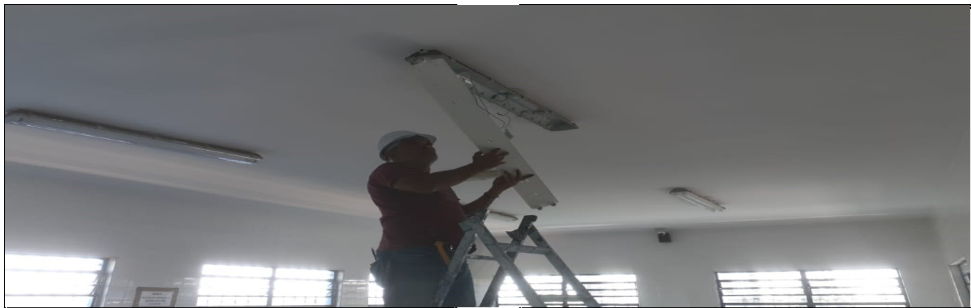
Manutenção elétrica e troca de lâmpadas
