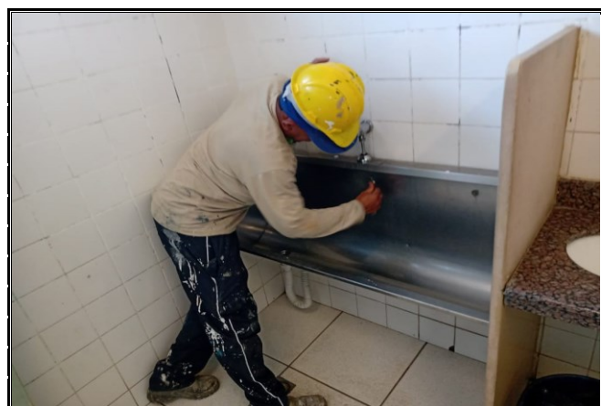
Desentupimento e limpeza de ramais
