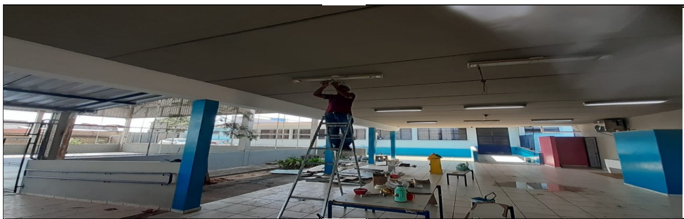
Manutenção elétrica e troca de lâmpadas
