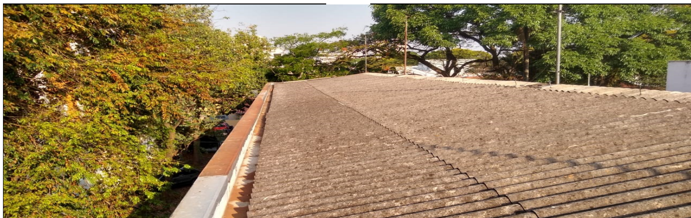
Limpeza das calhas
