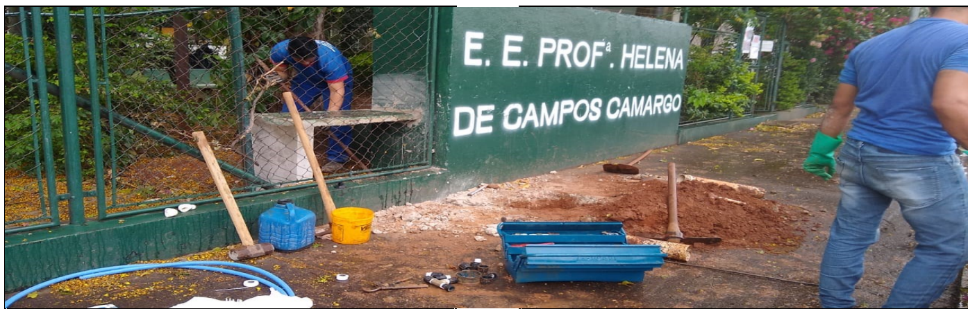
Troca do cavalete de entrada de água da escola pelo SAAE
