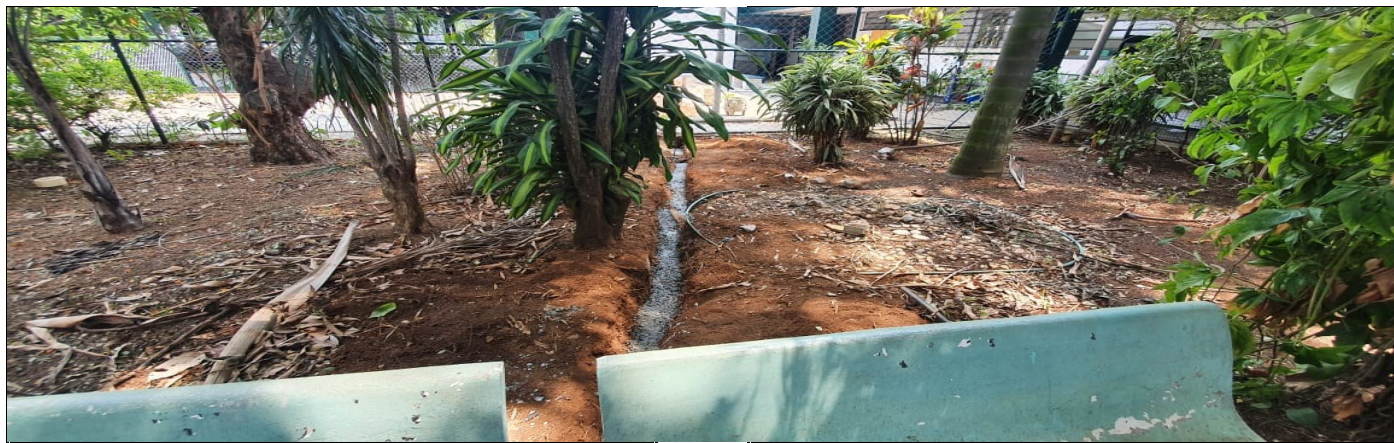
Nova entrada de água da escola
