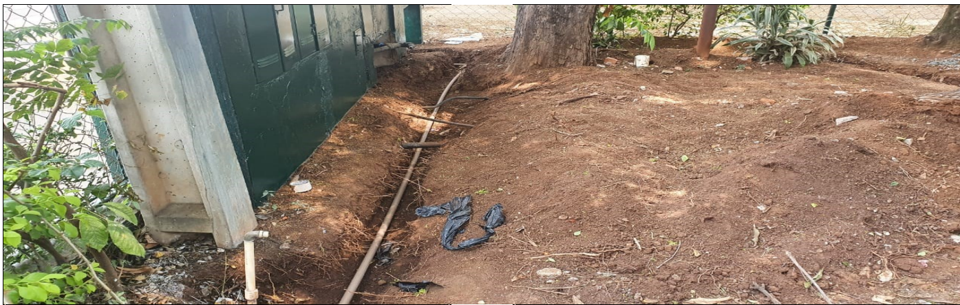
Nova entrada de água da escola
