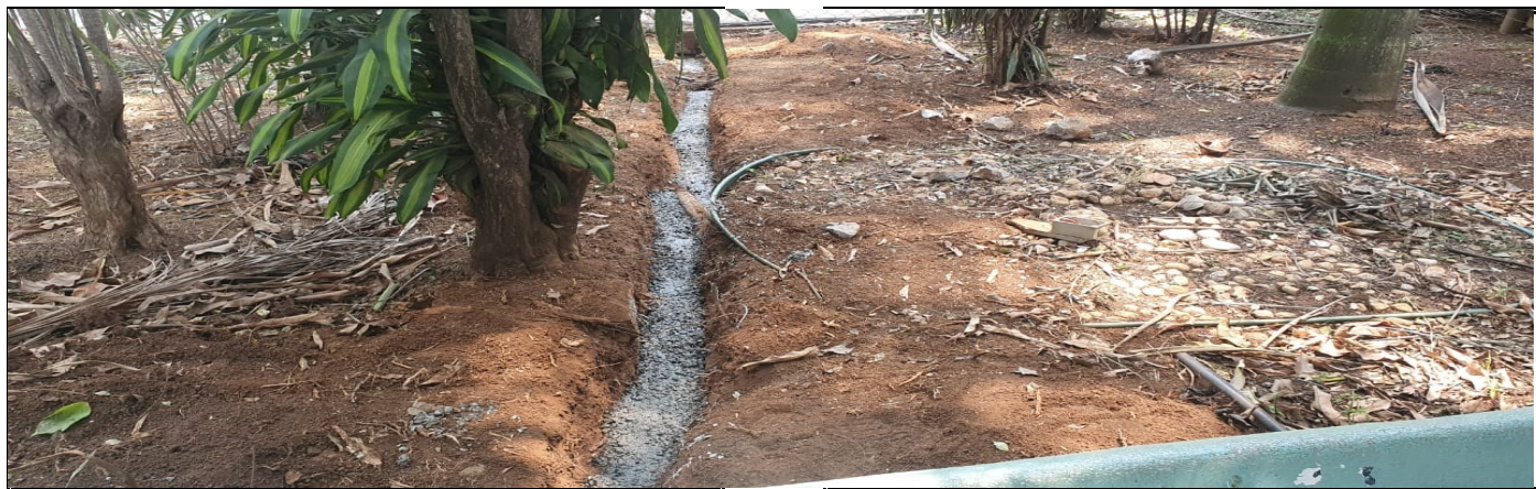
Nova entrada de água da escola
