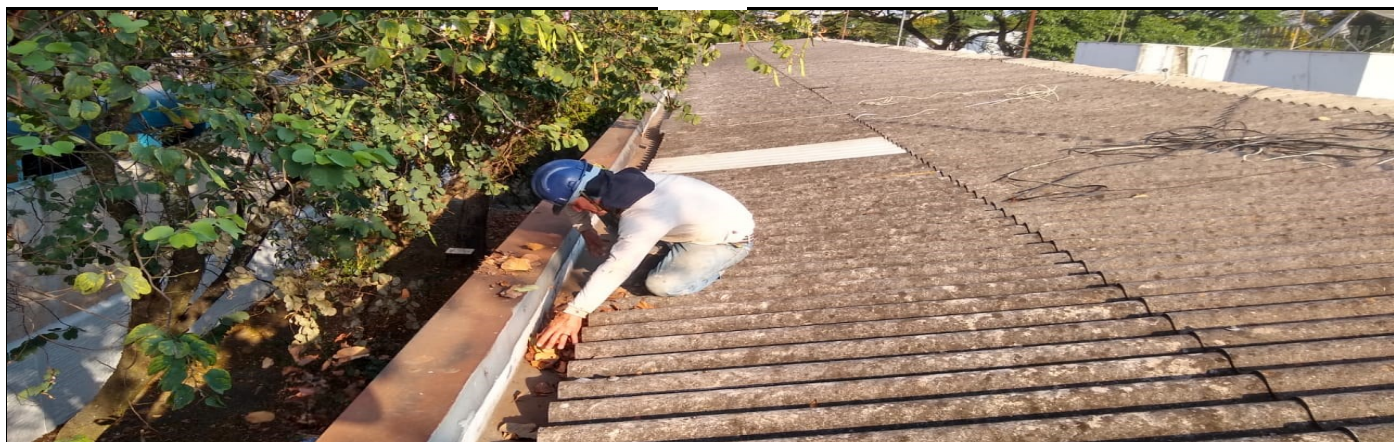
Limpeza das calhas
