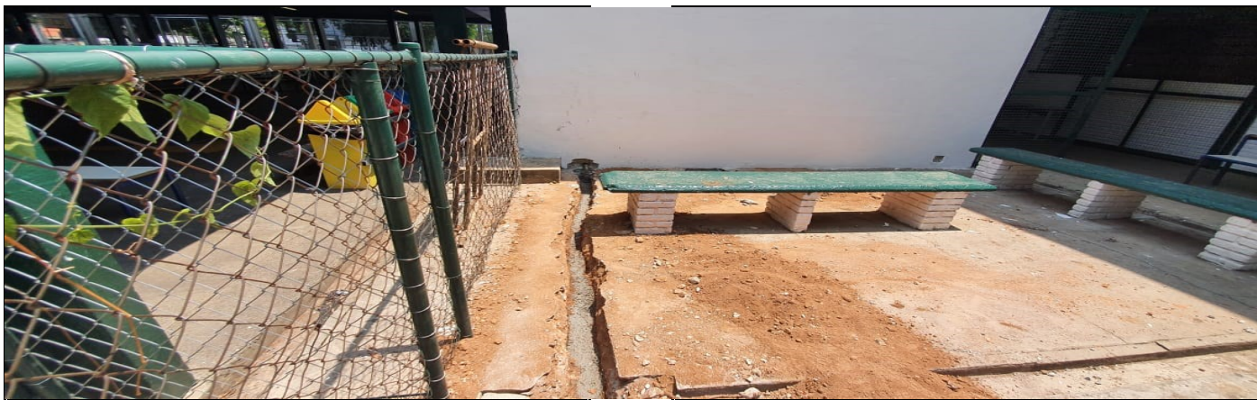
Nova entrada de água da escola
