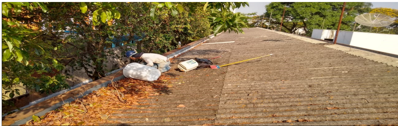
Limpeza das calhas
