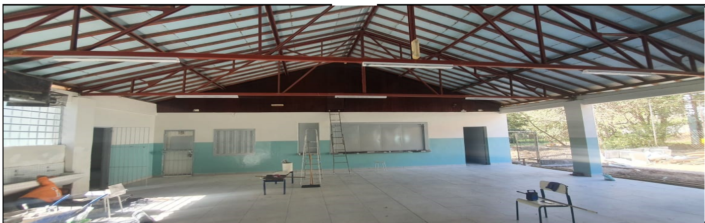
Reforma da cozinha
