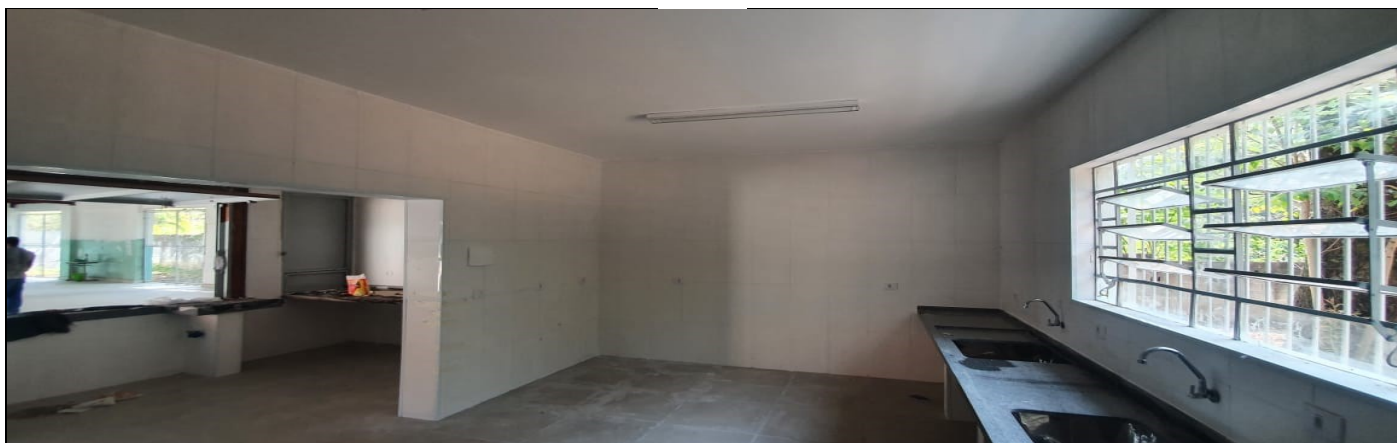
Reforma da cozinha
