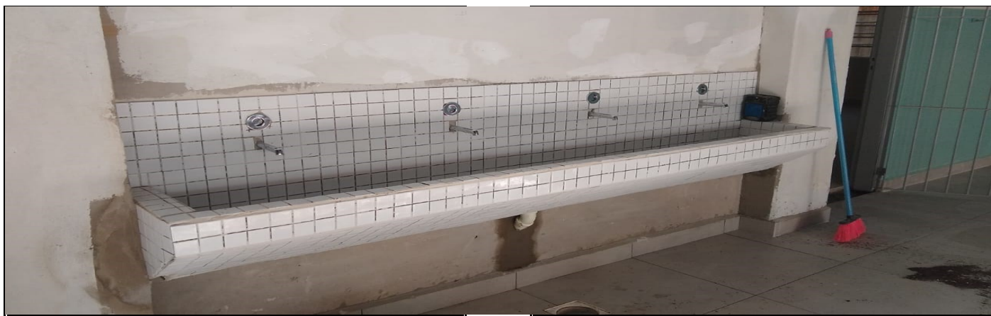
Reforma do bebedouro
