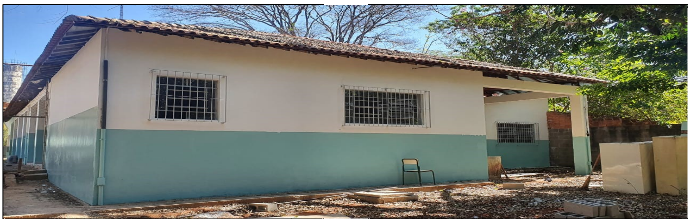
Pintura da área externa da cozinha
