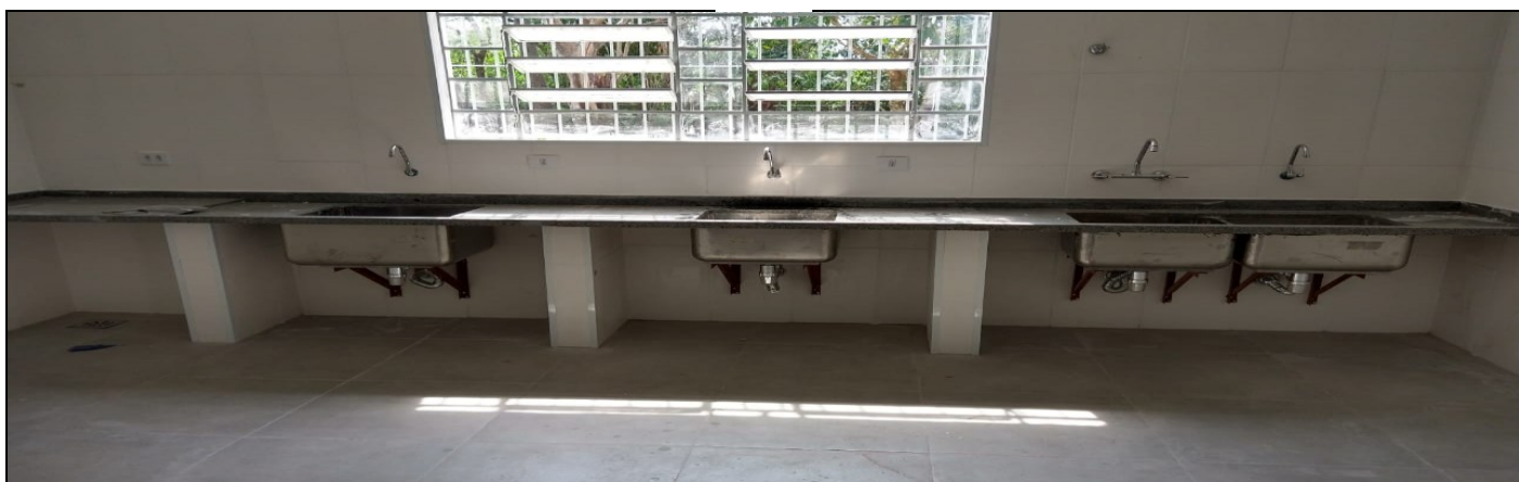
Reforma da cozinha
