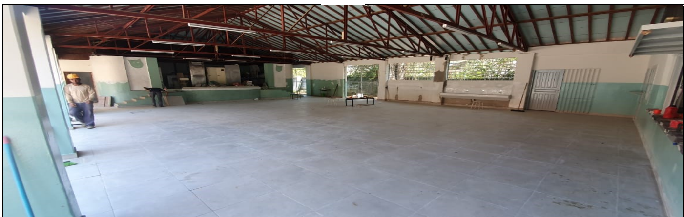
Colocação de piso porcelanato no pátio coberto
