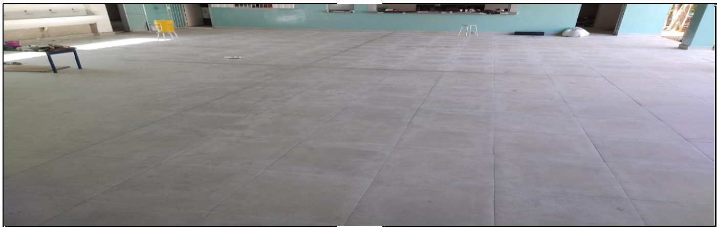
Colocação de piso porcelanato no pátio coberto
