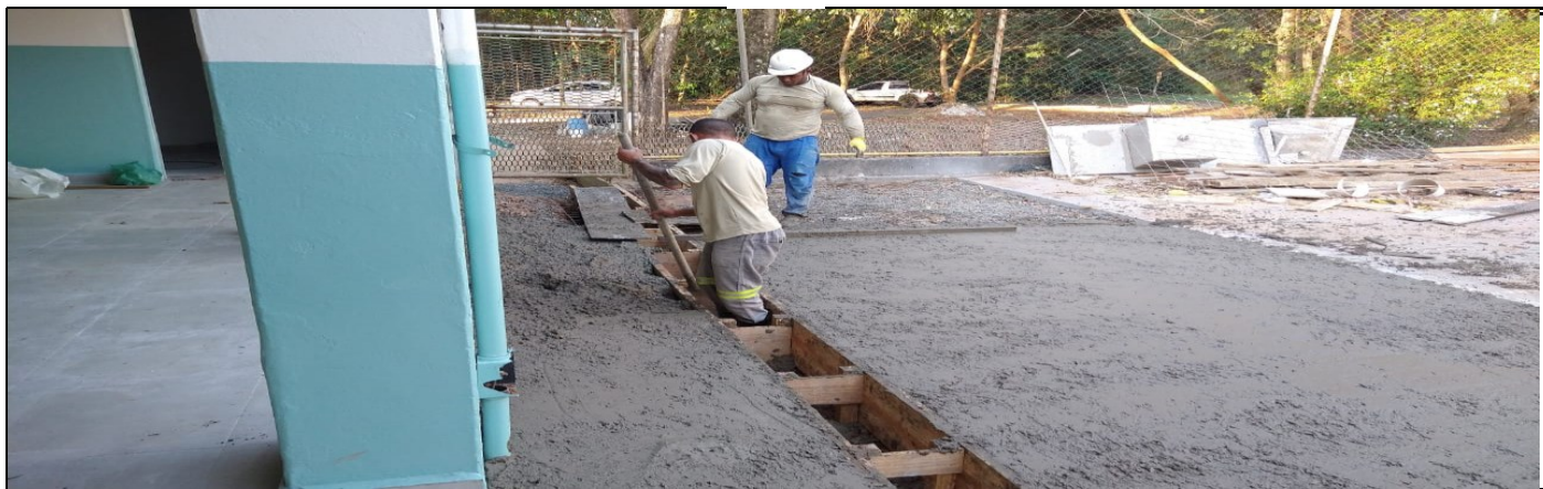
Execução de canaletas para escoamento de águas pluviais
