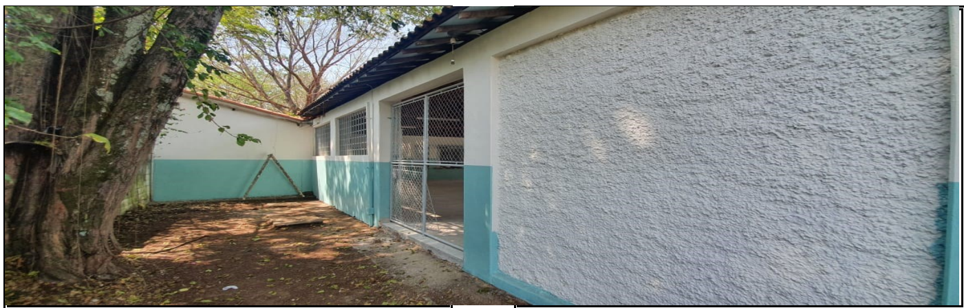
Pintura da área externa da sala de leitura e pátio coberto
