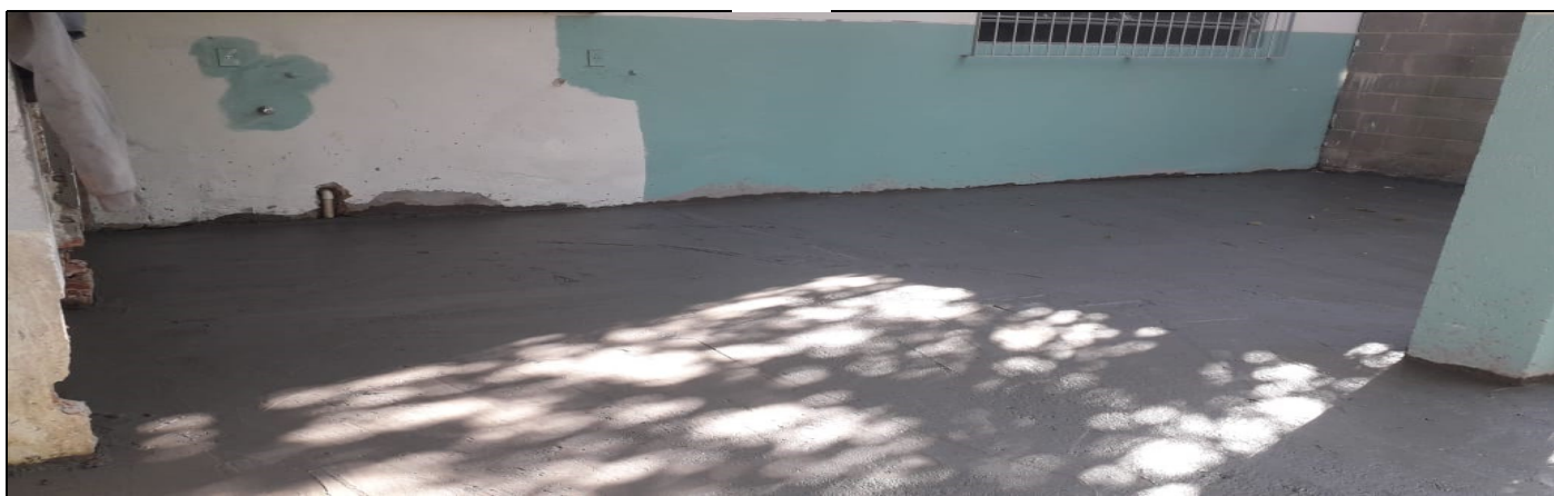
Execução de novo piso na área externa da cozinha
