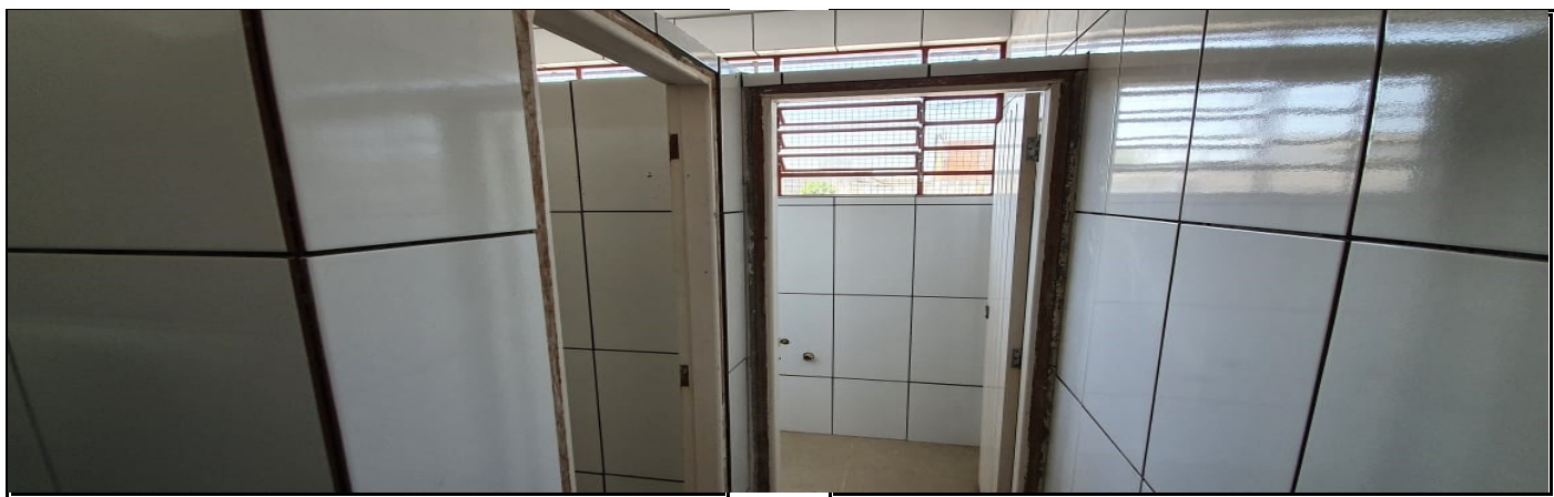
Reforma dos sanitários administrativos
