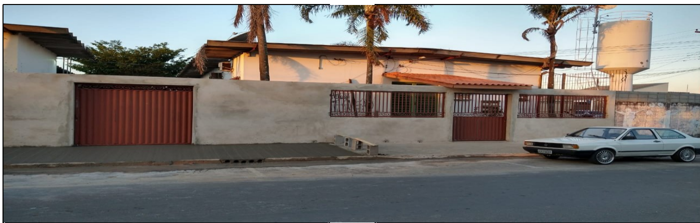
Reforma do muro e da fachada da escola
