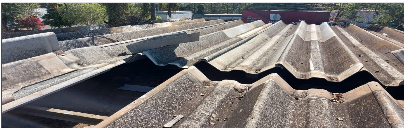
Troca de telhas danificadas
