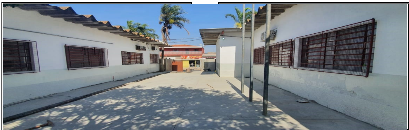
Execução de novo piso de concreto entre o bloco das salas de aula e administrativo
