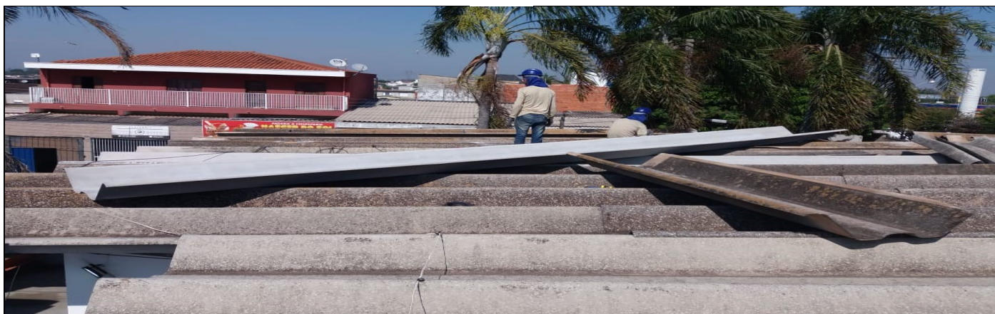
Troca de telhas danificadas
