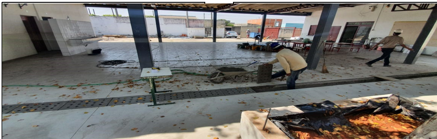
Colocação de tampas na canaleta pluvial
