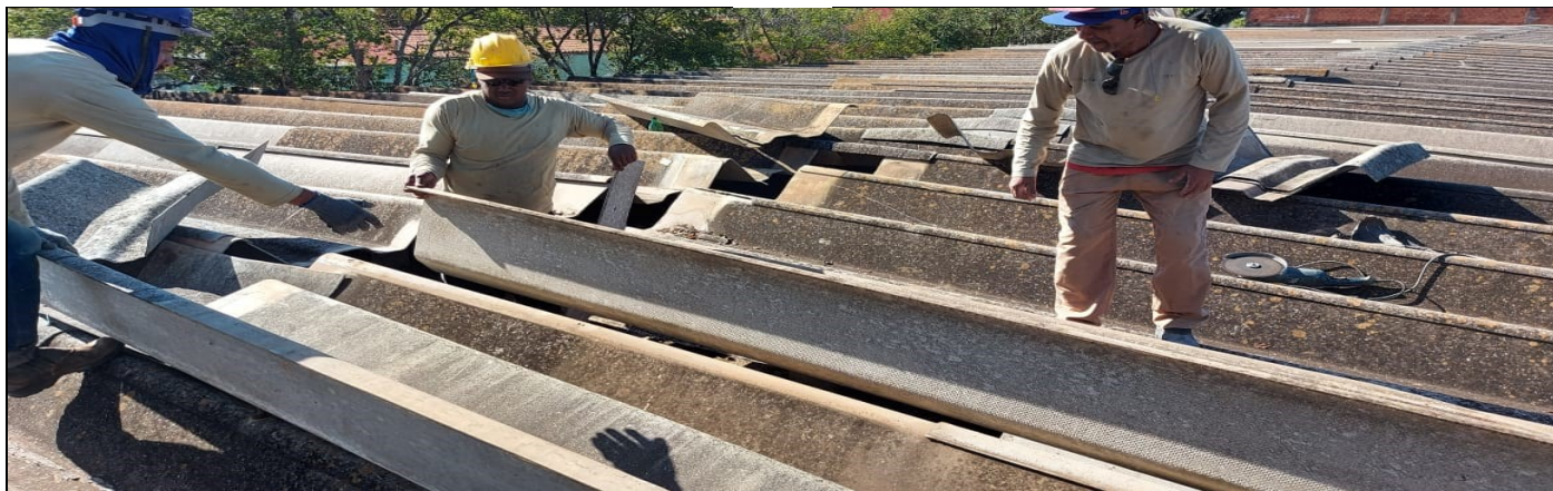
Troca de telhas danificadas
