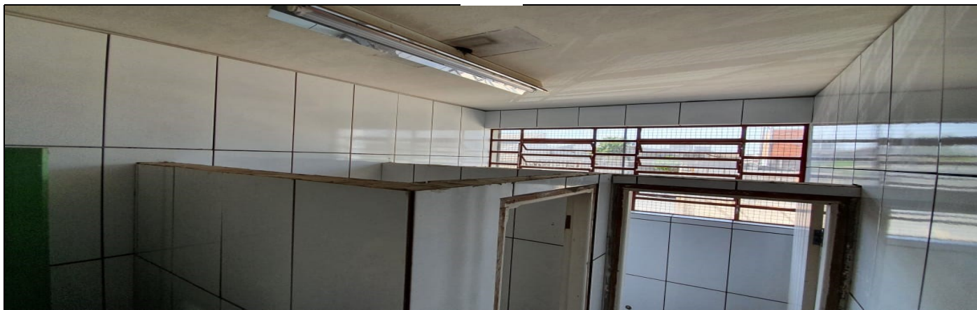
Reforma dos sanitários administrativos
