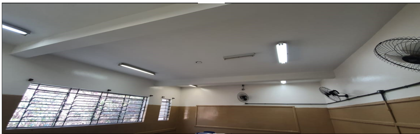
Pintura externa e interna da escola
