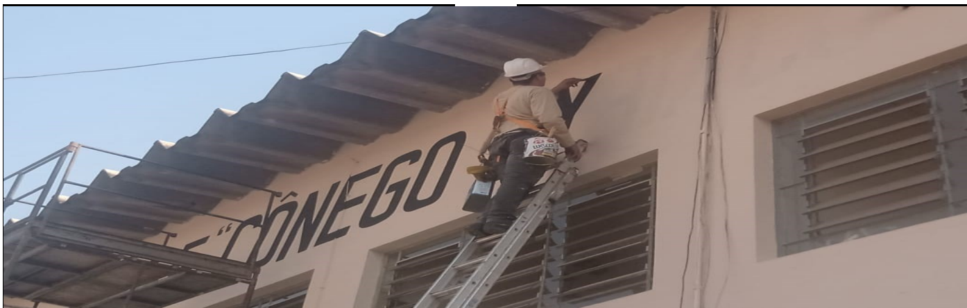
Pintura externa e interna da escola
