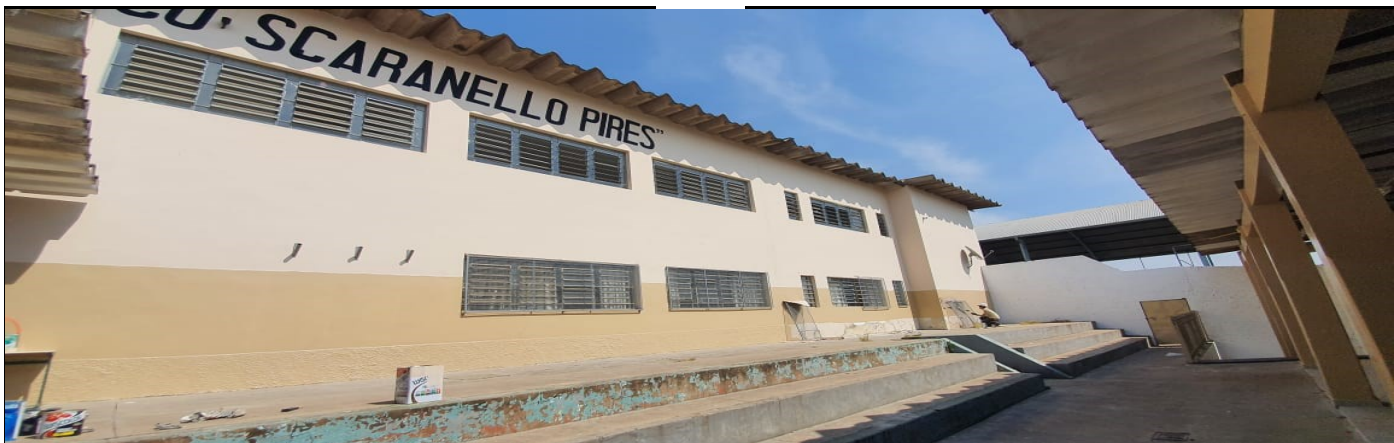
Pintura externa e interna da escola
