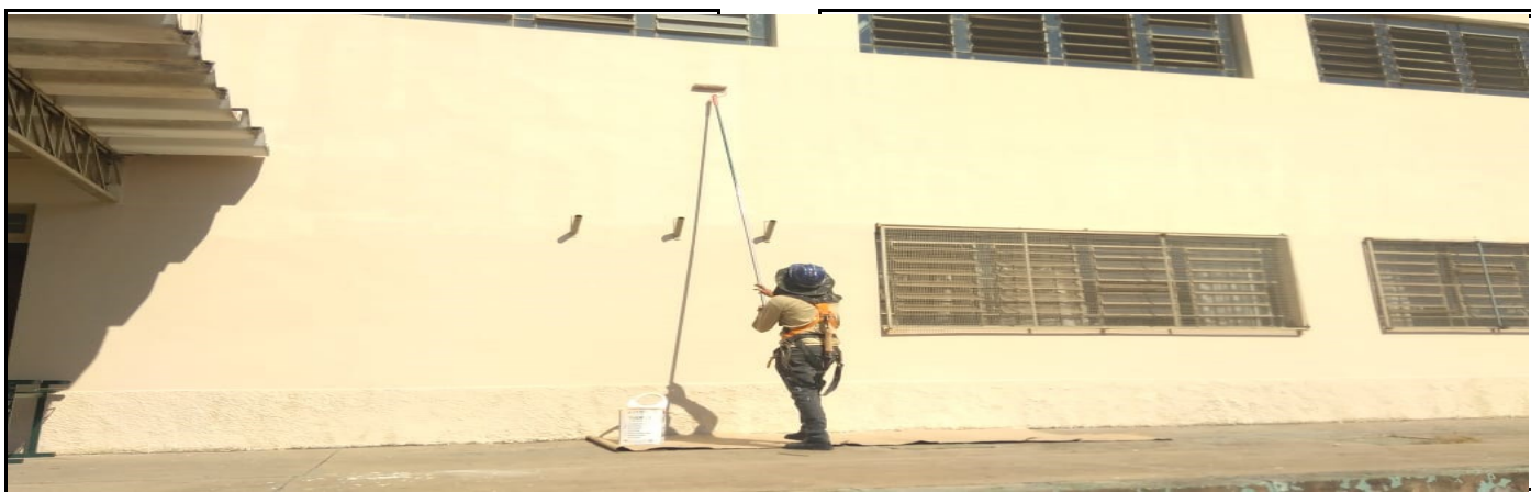
Pintura externa e interna da escola
