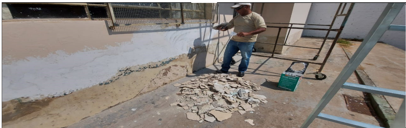
Pintura externa e interna da escola
