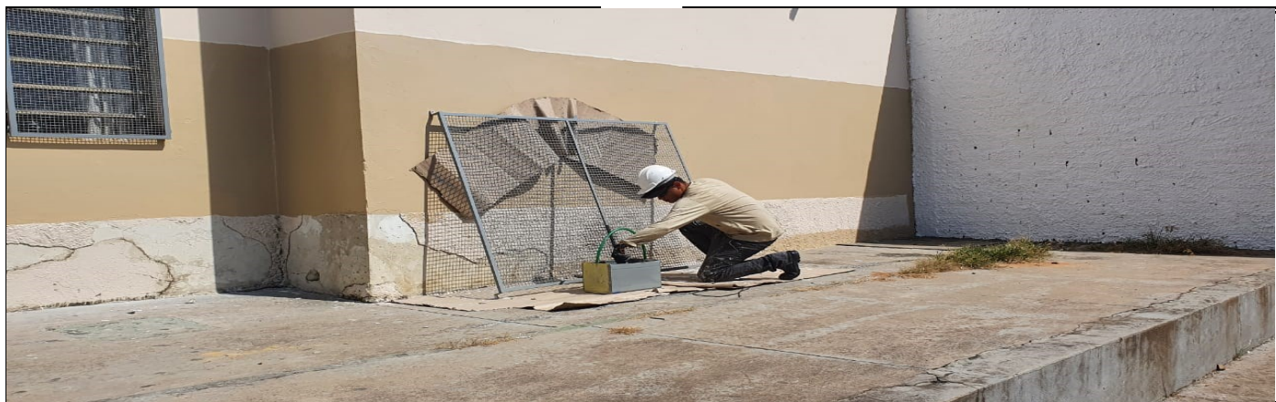
Pintura externa e interna da escola
