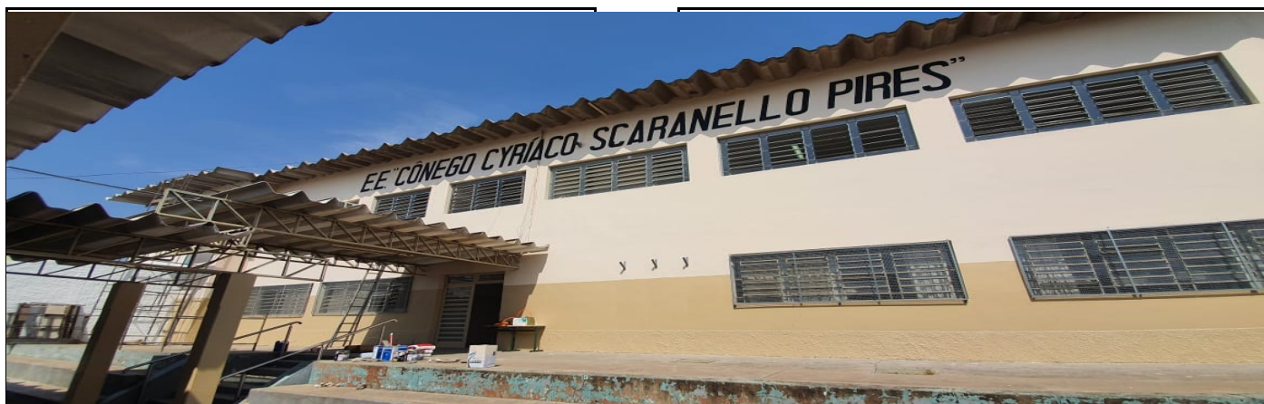
Pintura externa e interna da escola
