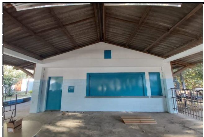
Reforma da cozinha
