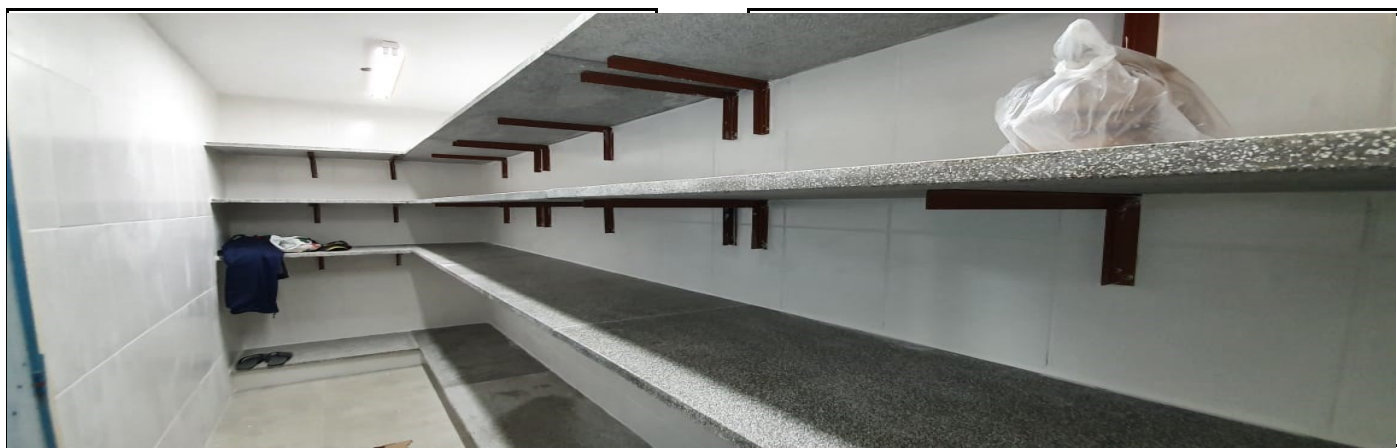
Reforma da cozinha
