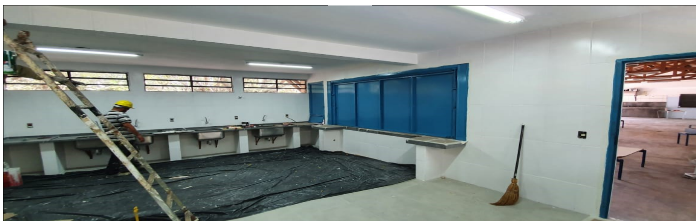
Reforma da cozinha
