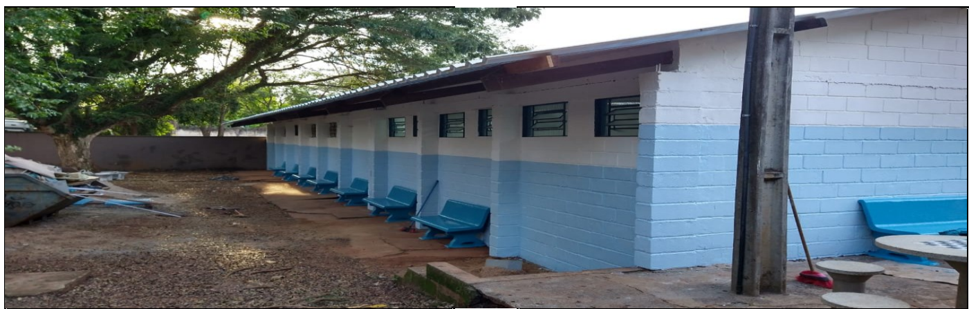
Reforma da sala de leitura
