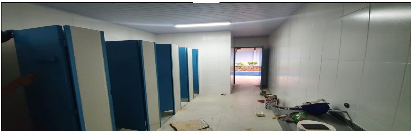
Reforma dos sanitários dos alunos
