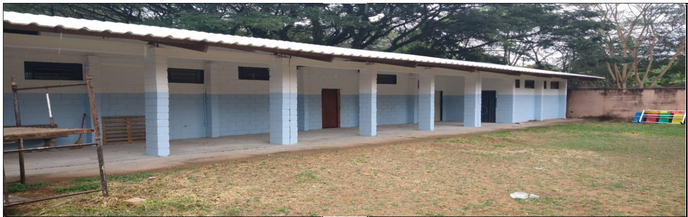
Reforma da sala de leitura
