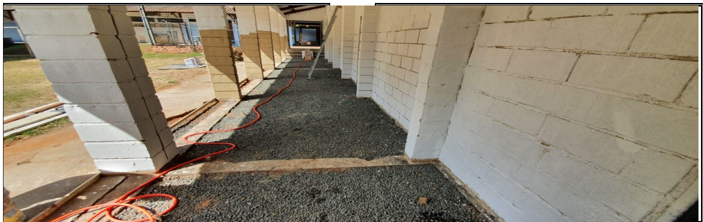
Reforma do corredor de acesso da sala de leitura
