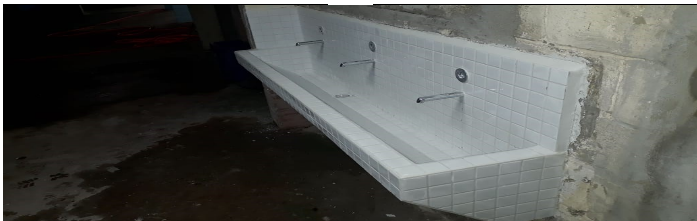
Reforma do bebedouro
