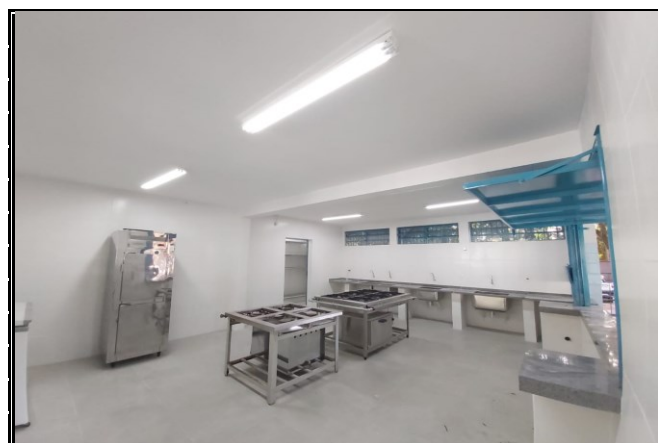
Reforma da cozinha
