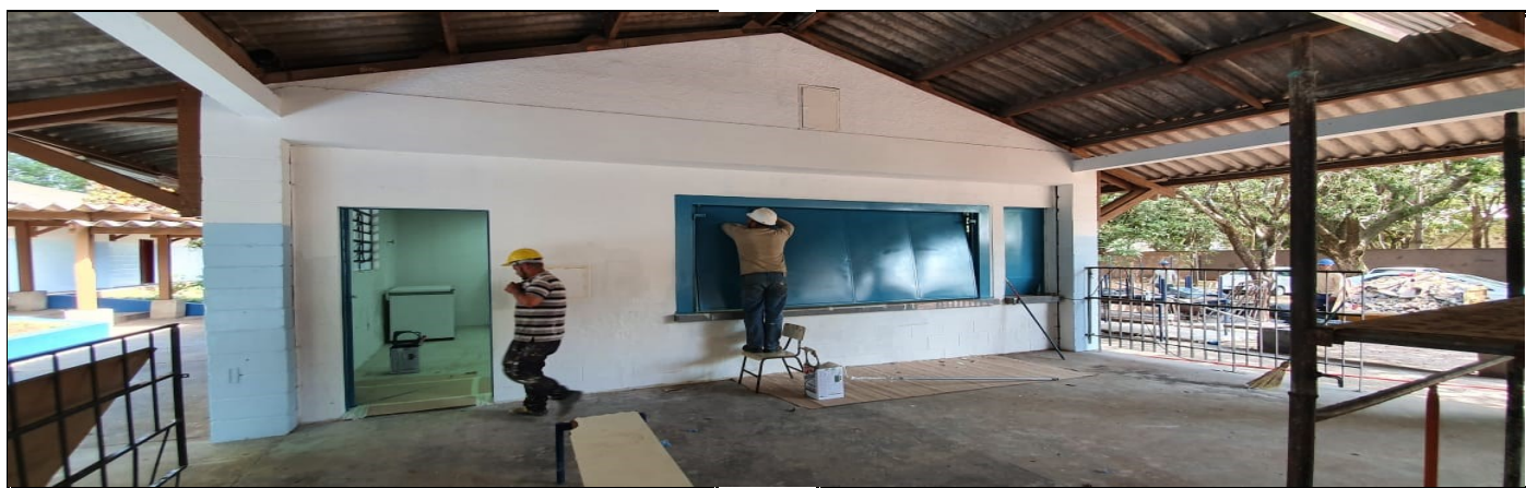
Reforma da cozinha
