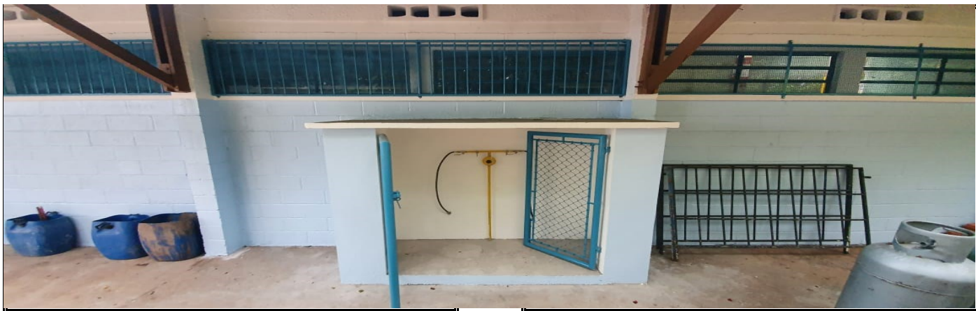
Reforma da instalação de gás
