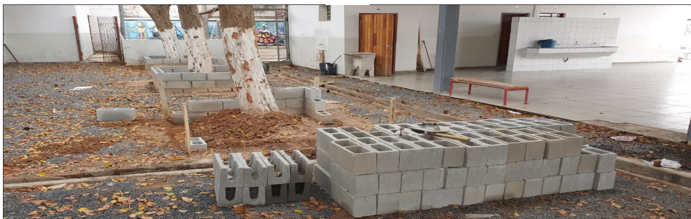
Reforma do piso e canteiros entre o bloco administrativo e salas de aula
