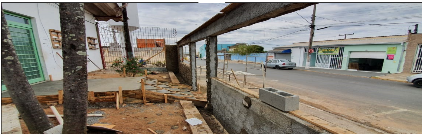
Reforma do muro frontal da escola e entrada dos alunos
