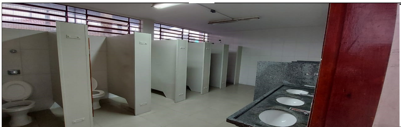
Reforma dos sanitários dos alunos
