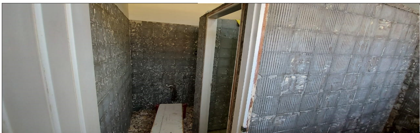
Reforma dos sanitários administrativos
