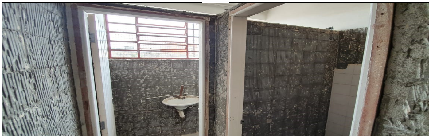
Reforma dos sanitários administrativos
