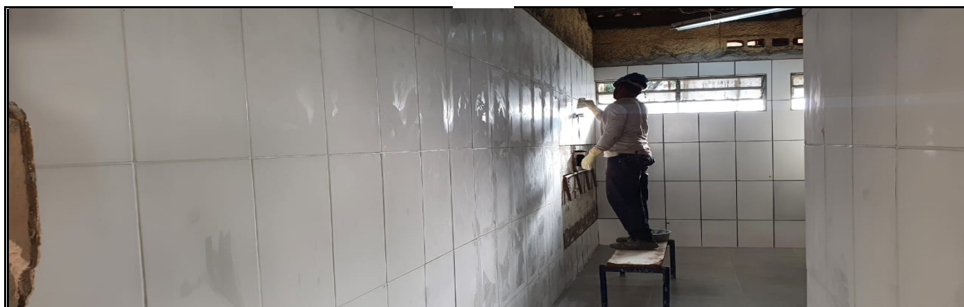
Reforma dos sanitários dos alunos
