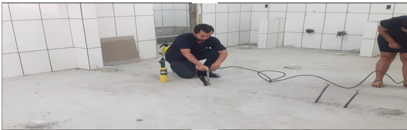
Reforma da cozinha
