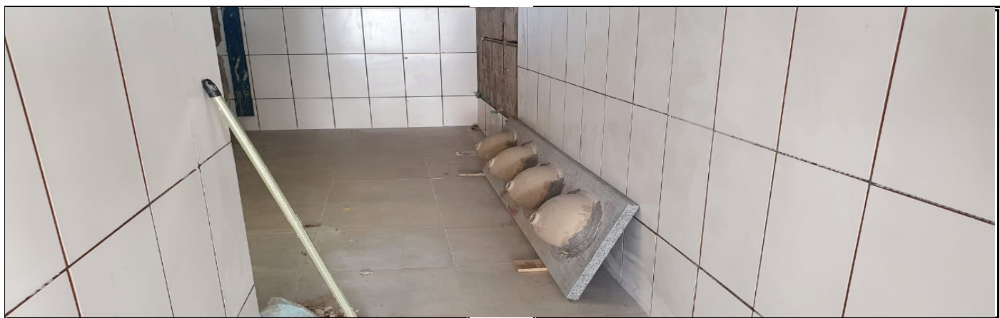
Reforma dos sanitários dos alunos
