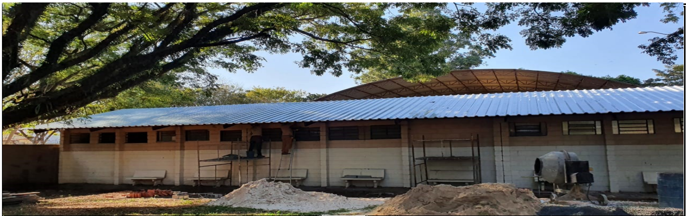
Reforma do telhado da sala de leitura
