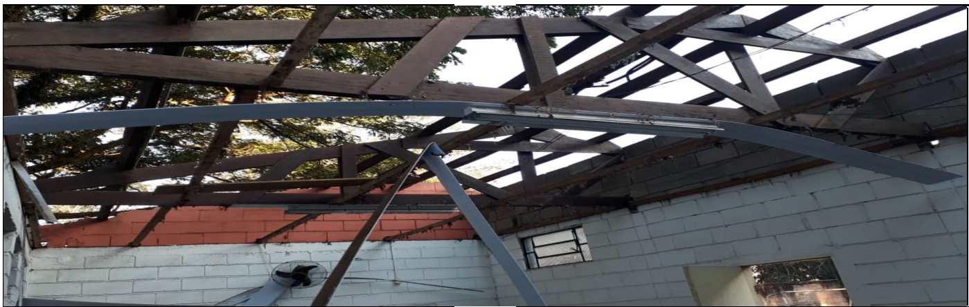
Reforma do telhado da sala de leitura
