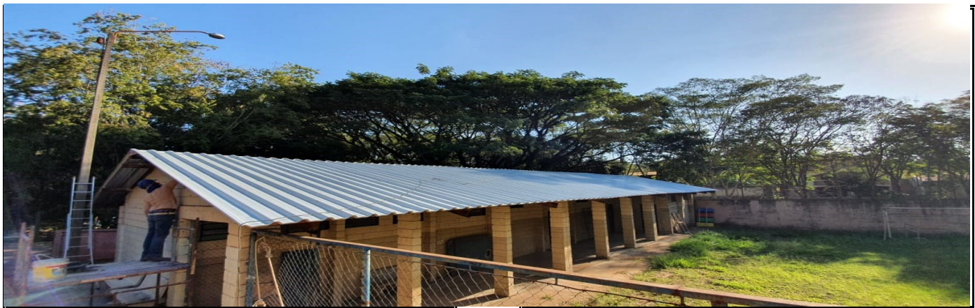
Reforma do telhado da sala de leitura
