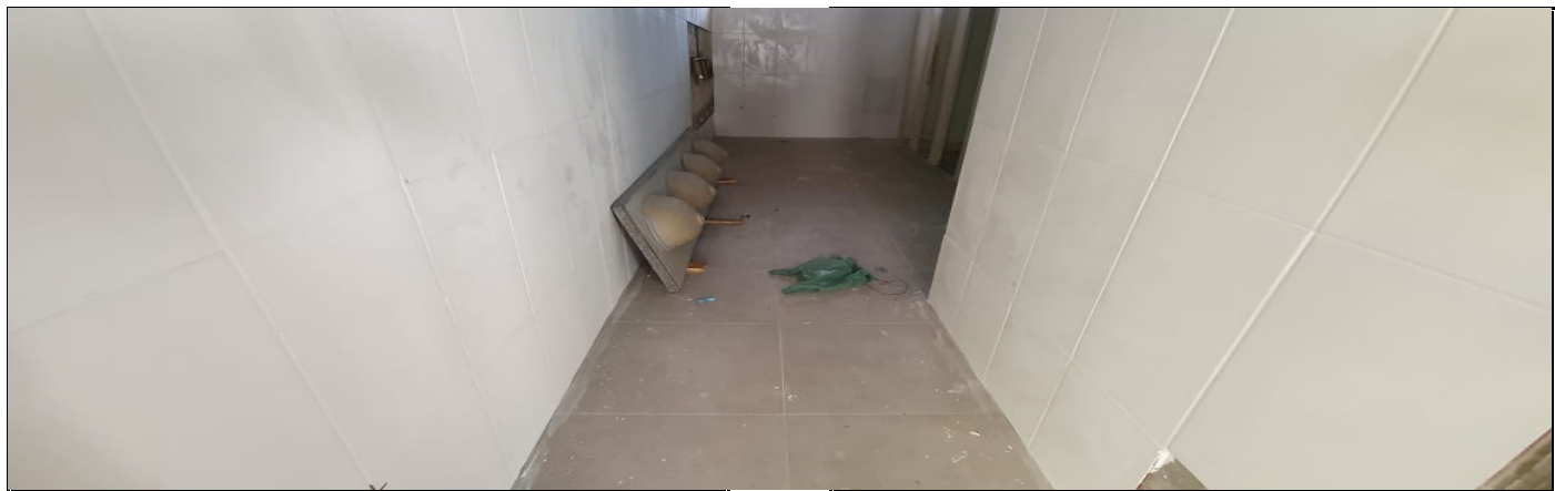
Reforma dos sanitários dos alunos
