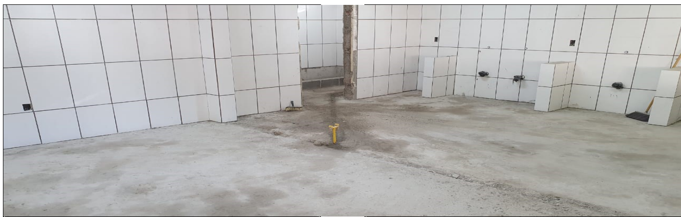
Reforma da cozinha
