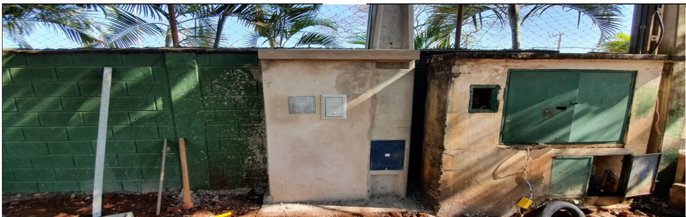
Execução de uma nova entrada de energia
