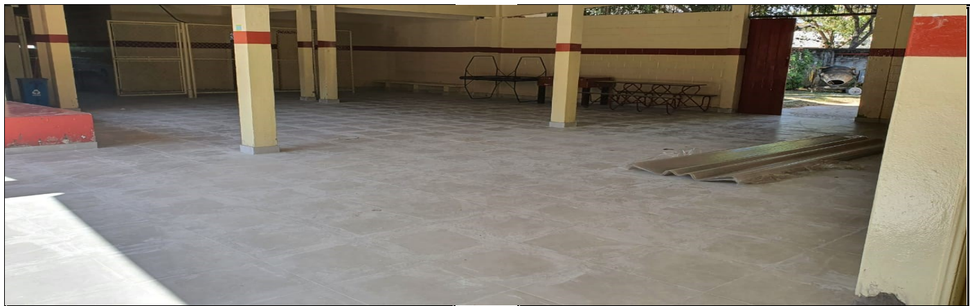
Colocação de piso no pátio coberto
