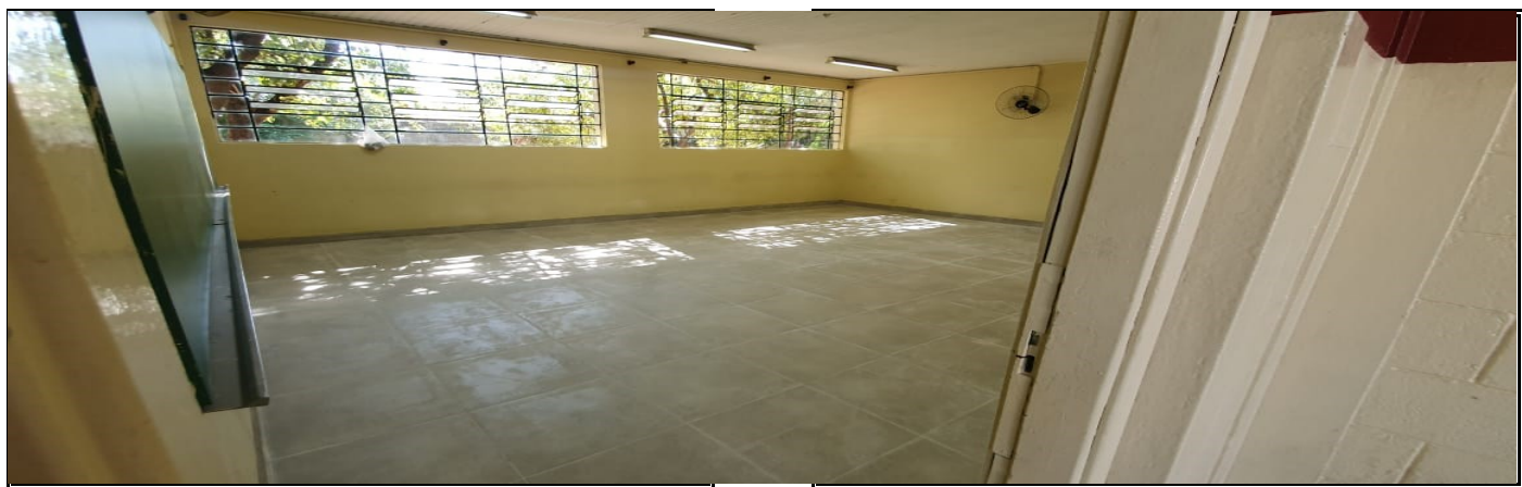
Colocação de piso na sala de aula
