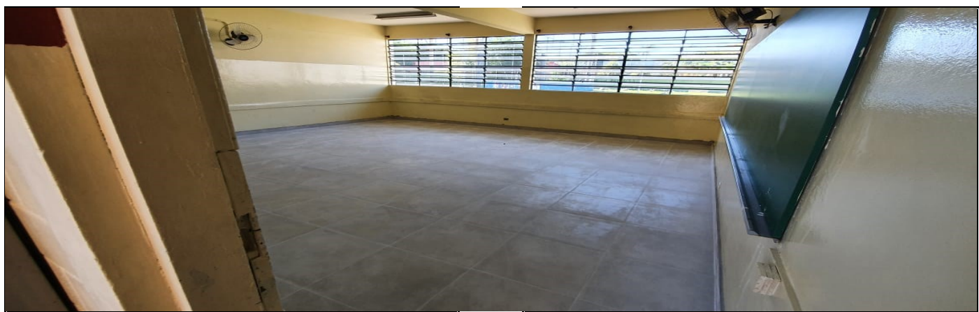
Colocação de piso na sala de aula
