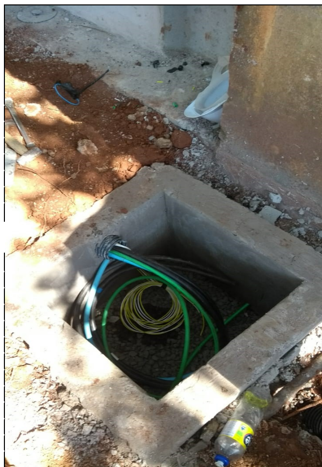
Execução de uma nova entrada de energia
