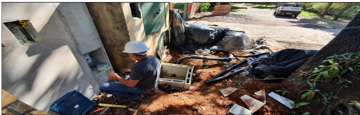
Execução de uma nova entrada de energia
