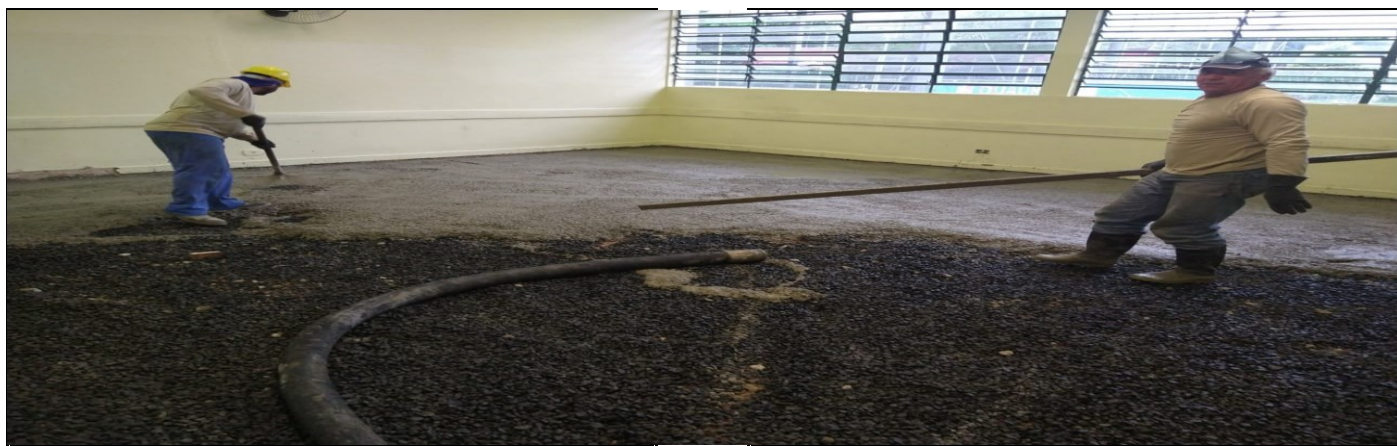
Reforma do piso de concreto na sala de aula com nivelamento para colocação de piso porcelanato
