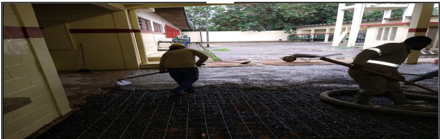
Reforma do piso de concreto do pátio coberto com nivelamento para colocação de piso porcelanato
