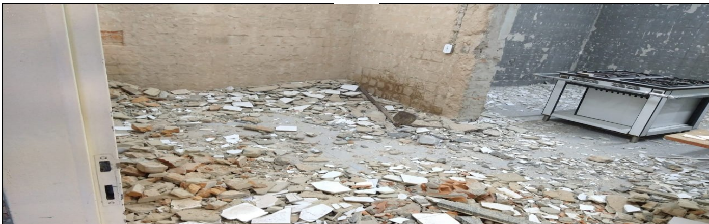
Reforma da cozinha
