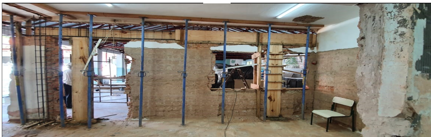
Reforma da cozinha
