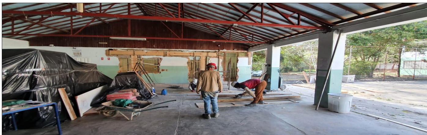
Reforma da cozinha
