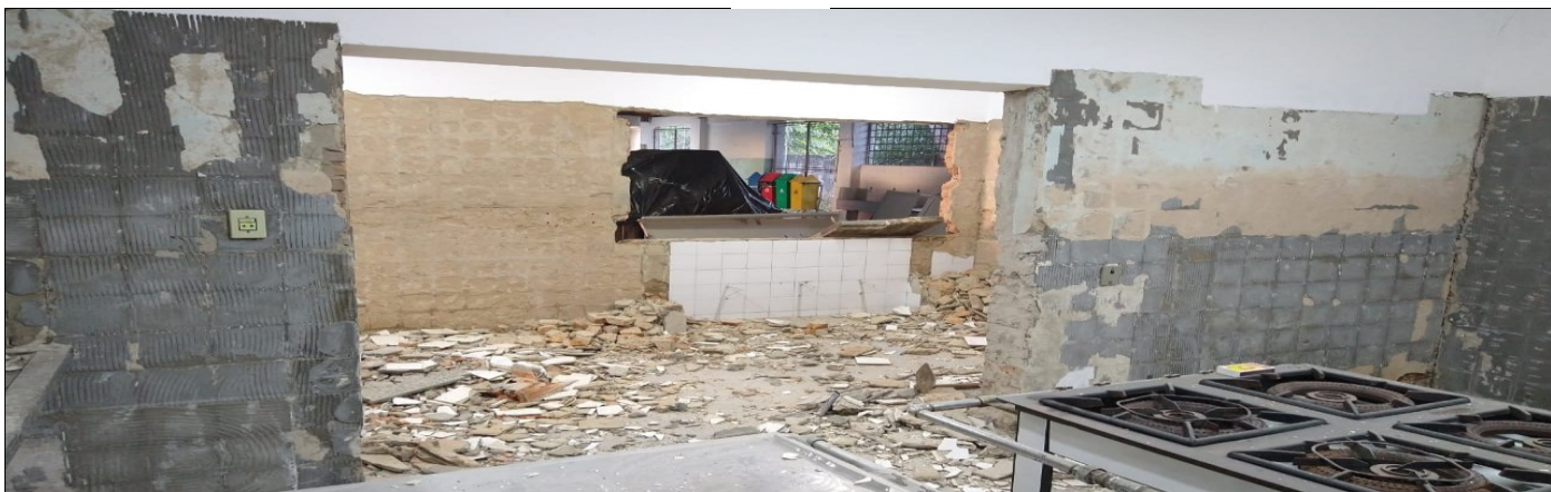
Reforma da cozinha
