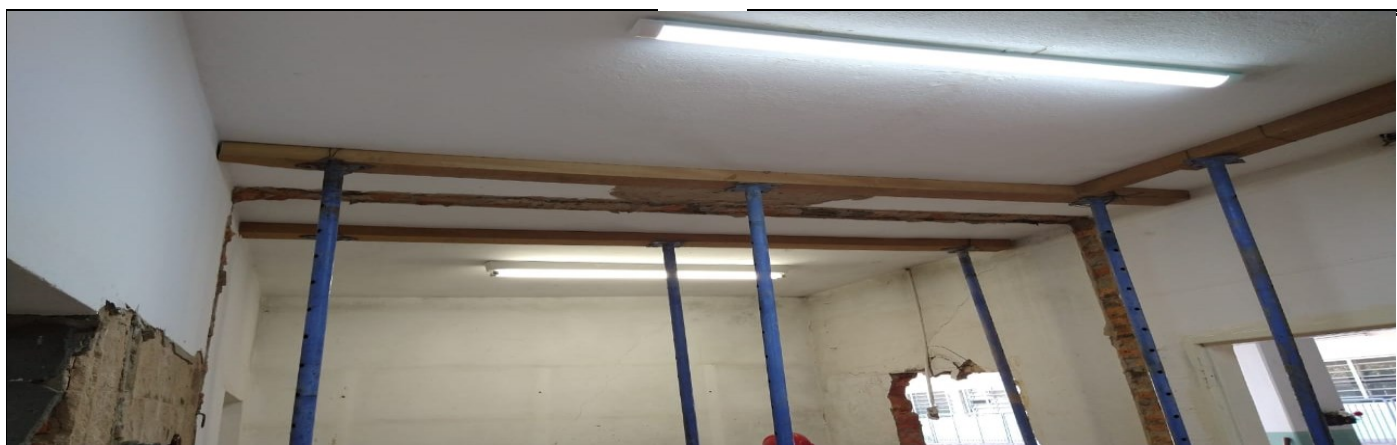
Reforma da cozinha
