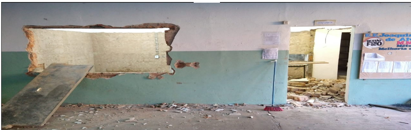
Reforma da cozinha
