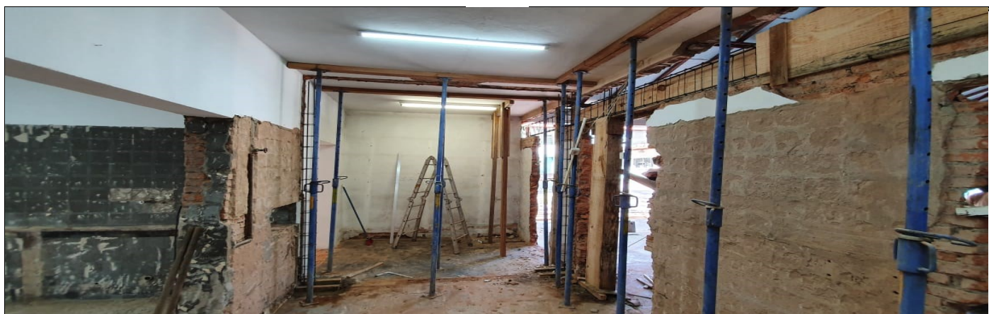
Reforma da cozinha
