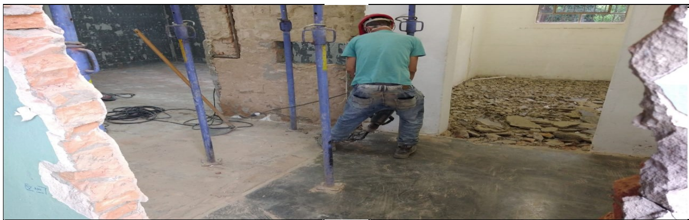
Reforma da cozinha
