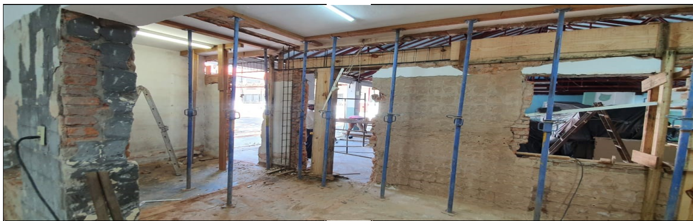
Reforma da cozinha
