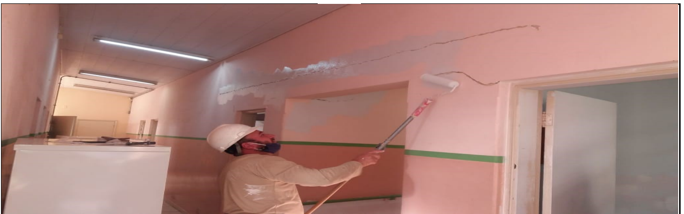
Pintura do bloco administrativo
