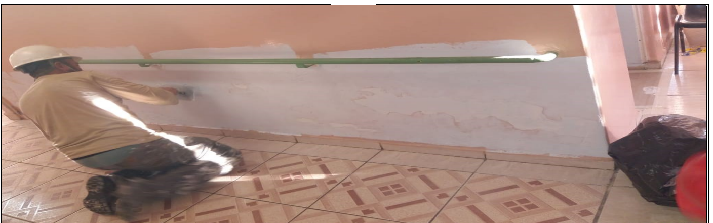
Pintura do bloco administrativo
