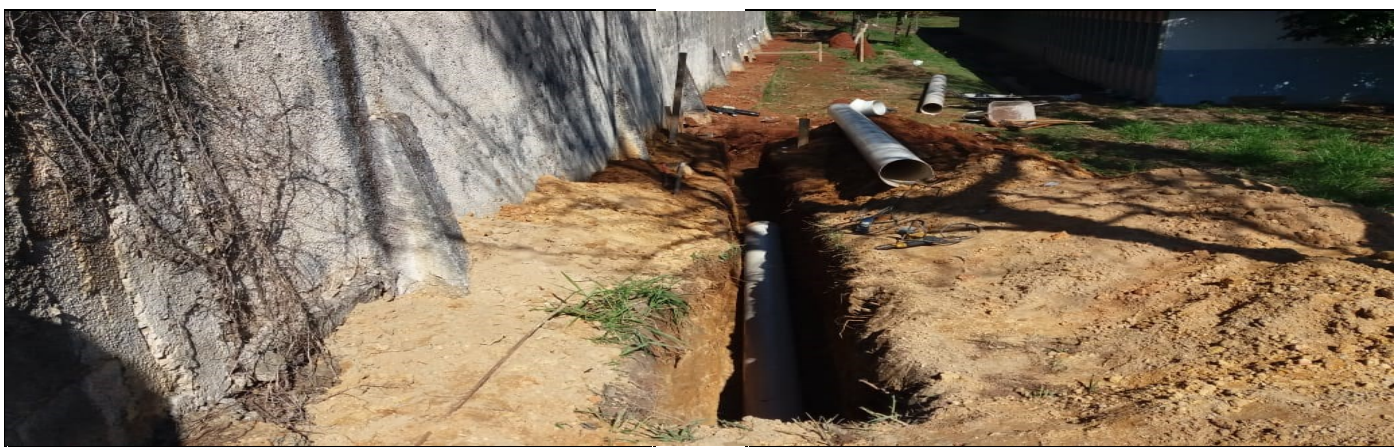
Reforma e complementação do sistema de drenagem de águas pluviais
