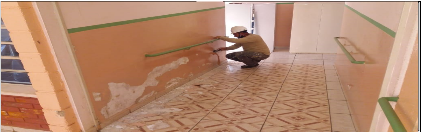
Pintura do bloco administrativo
