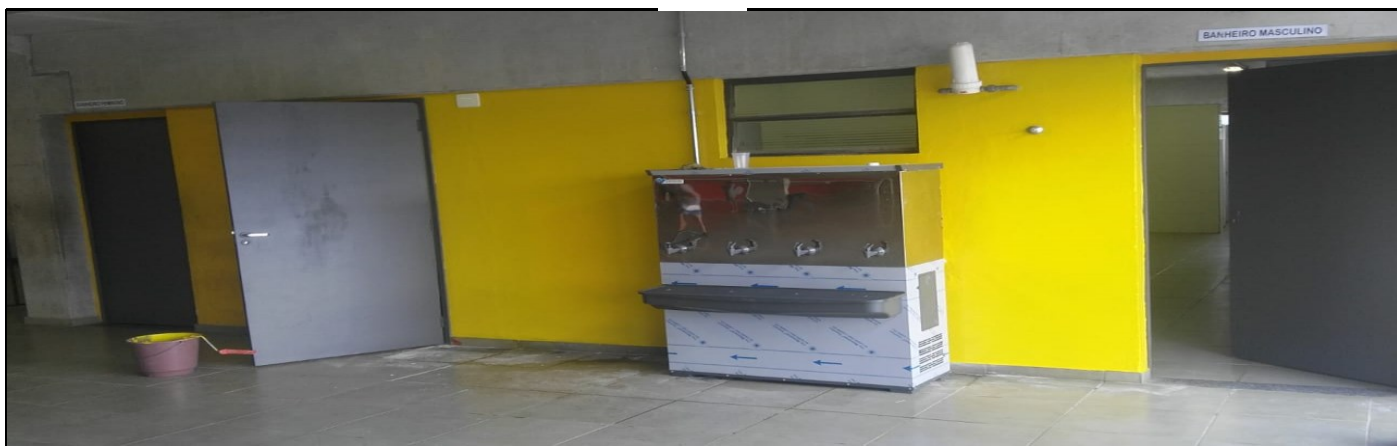
EXECUÇÃO DE TUBULAÇÃO ELÉTRICA PARA ALIMENTAÇÃO DO BEBEDOURO DE ÁGUA NOVO
