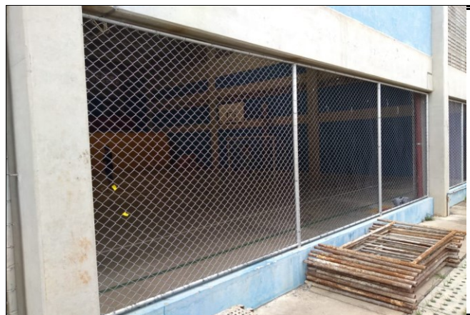
INSTALAÇÃO DE TELA NO ALAMBRADO DA QUADRA
