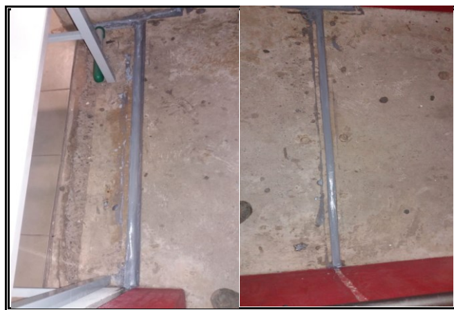
APLICAÇÃO DE MASTIQUE EM JUNTAS DE DILATAÇÃO
