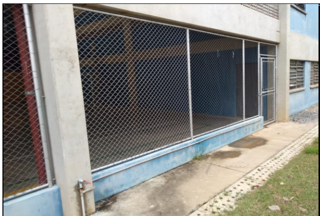
INSTALAÇÃO DE TELA NO ALAMBRADO DA QUADRA
