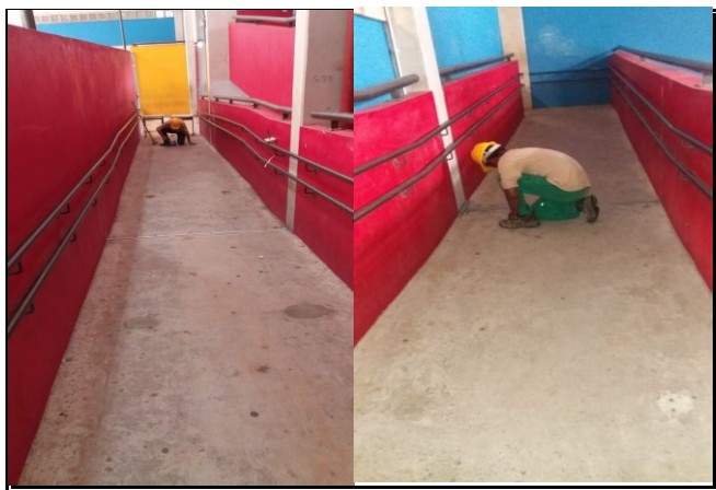
APLICAÇÃO DE MASTIQUE EM JUNTAS DE DILATAÇÃO
