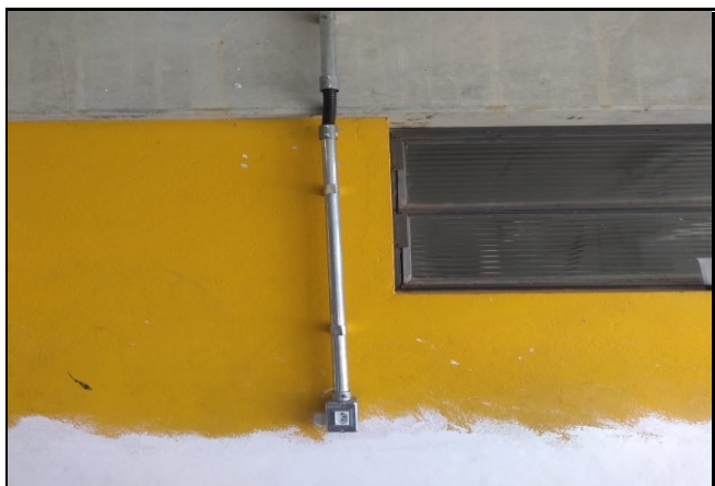
EXECUÇÃO DE TUBULAÇÃO ELÉTRICA PARA ALIMENTAÇÃO DO BEBEDOURO DE ÁGUA NOVO
