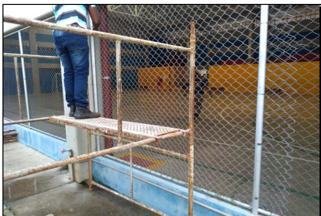
INSTALAÇÃO DE TELA NO ALAMBRADO DA QUADRA
