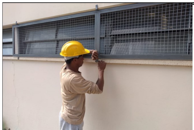
INSTALAÇÃO DE GRADES DE PROTEÇÃO NOS SANITÁRIOS DOS ALUNOS
