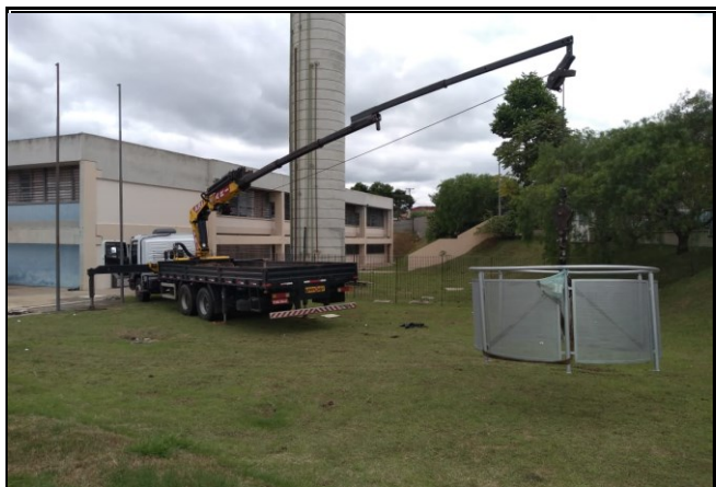
INSTALAÇÃO DE GUARDA CORPO NO RESERVATÓRIO DE ÁGUA
