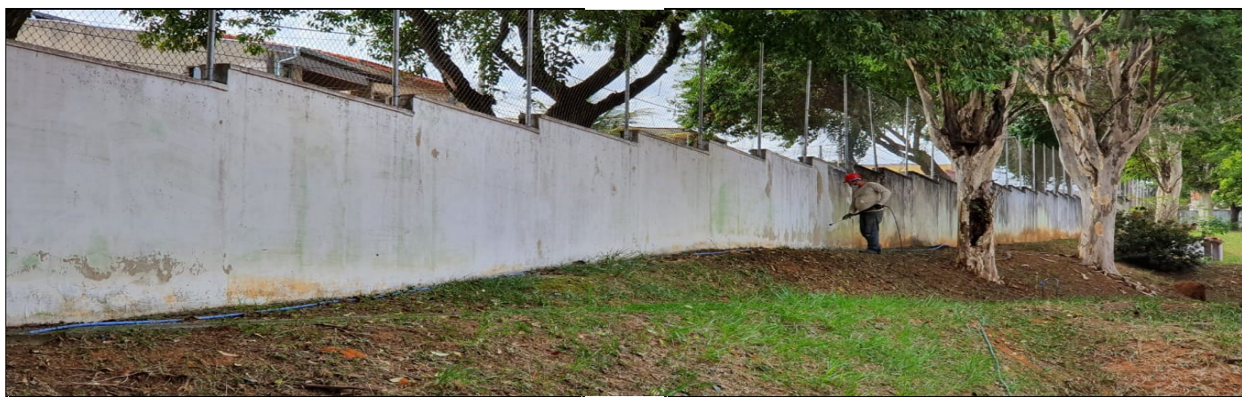
LIMPEZA DOS MUROS PARA PINTURA
