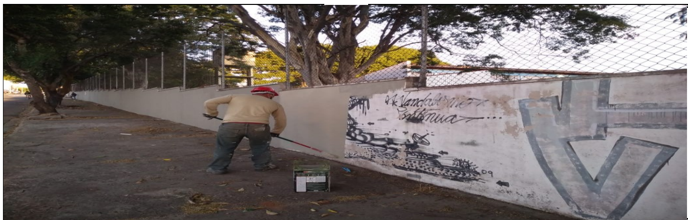
PINTURA DOS MUROS
