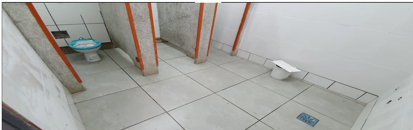
REFORMA DOS SANITÁRIOS ADMINISTRATIVOS
