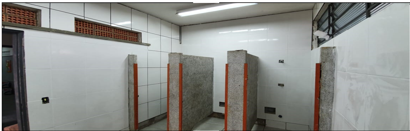
REFORMA DOS SANITÁRIOS ADMINISTRATIVOS
