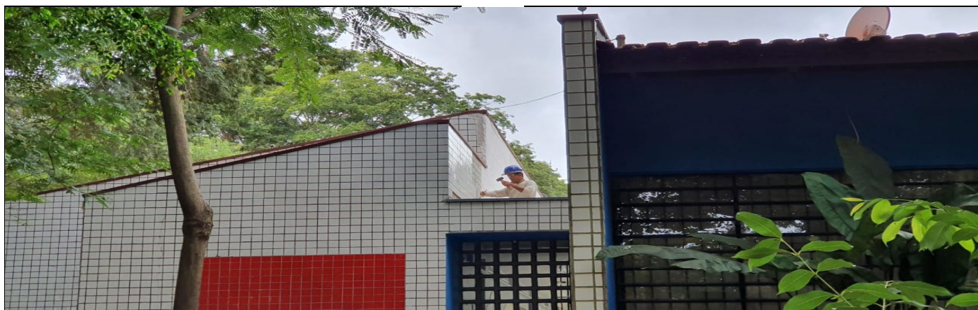
RETIRADA DAS PASTILHAS E CONCRETAMENTO
