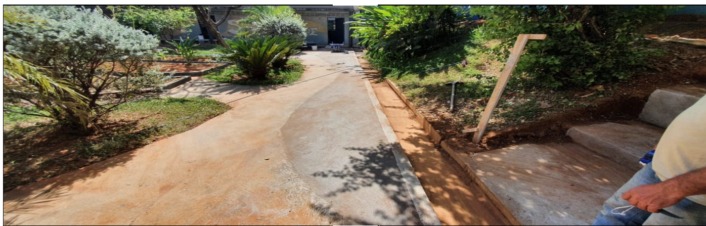
EXECUÇÃO DE PISO CIMENTADO
