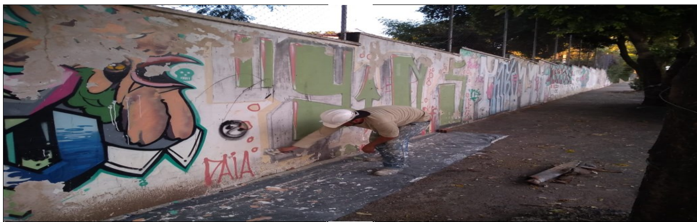
LIMPEZA DOS MUROS PARA PINTURA
