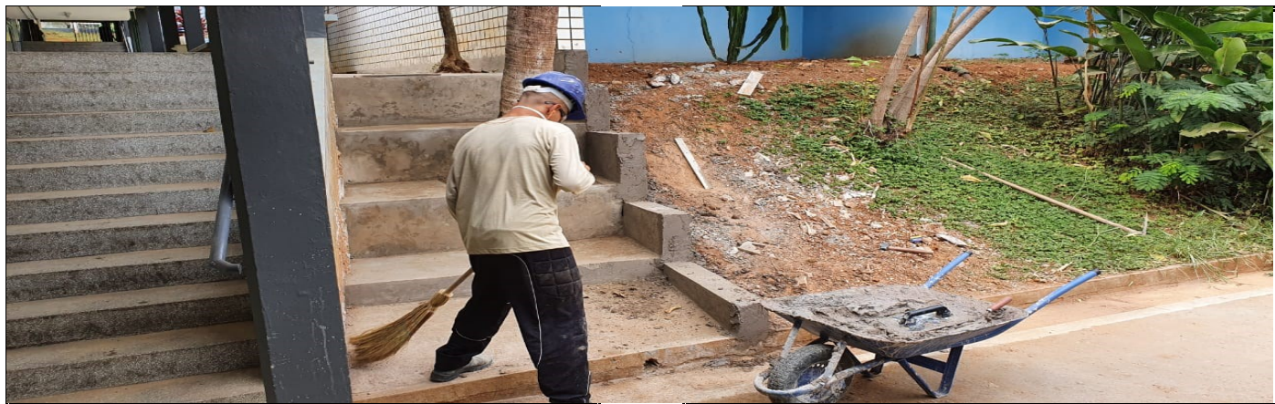
EXECUÇÃO DE PISO CIMENTADO E UMA ESCADA HIDRÁULICA
