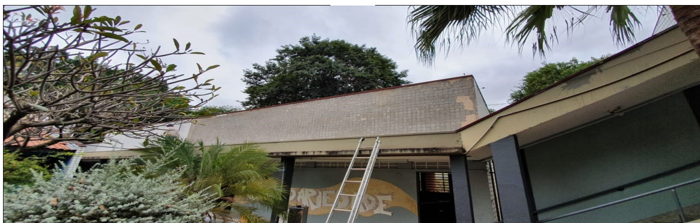
RETIRADA DAS PASTILHAS E CONCRETAMENTO
