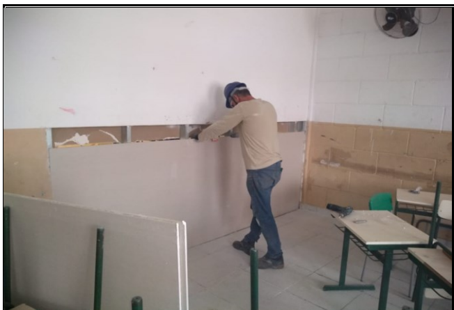
EXECUÇÃO DE PAREDE DE GESSO
