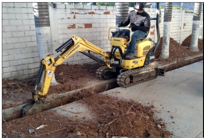
EXECUÇÃO DE NOVAS CANALETAS PARA ESCOAMENTO DE ÁGUA PLUVIAL
