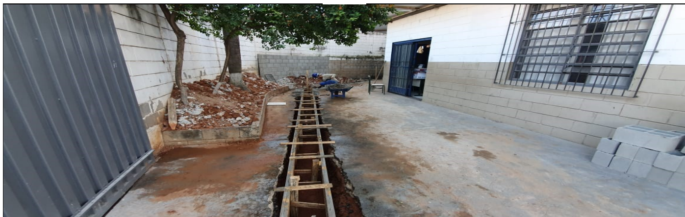
EXECUÇÃO DE NOVAS CANALETAS PARA ESCOAMENTO DE ÁGUA PLUVIAL
