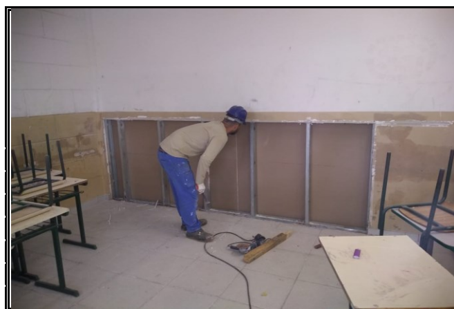
EXECUÇÃO DE PAREDE DE GESSO
