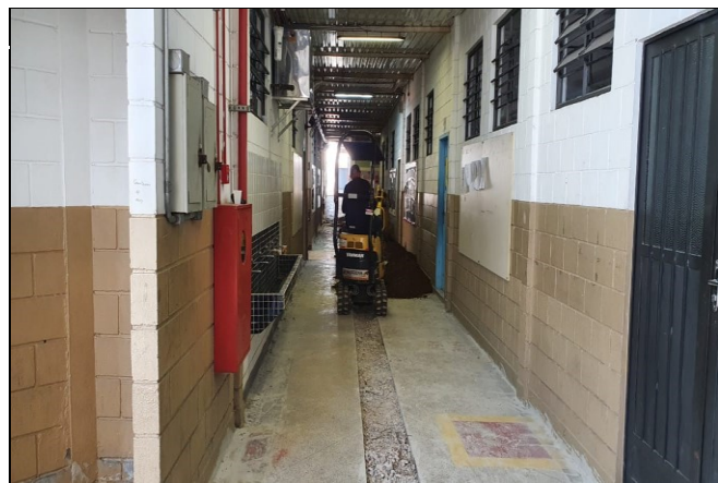
EXECUÇÃO DE NOVAS CANALETAS PARA ESCOAMENTO DE ÁGUA PLUVIAL
