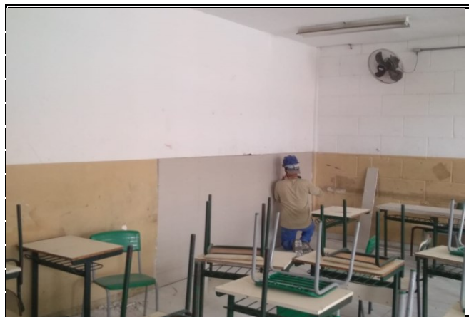
EXECUÇÃO DE PAREDE DE GESSO
