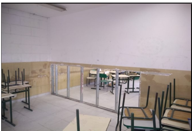
EXECUÇÃO DE PAREDE DE GESSO
