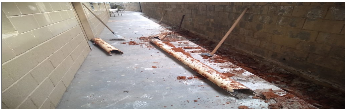
EXECUÇÃO DE NOVAS CANALETAS PARA ESCOAMENTO DA ÁGUA DA CHUVA
