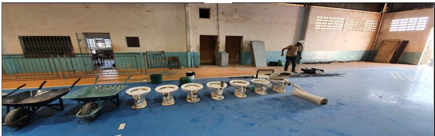
DEMOLIÇÃO DOS REVESTIMENTOS DOS VESTIÁRIOS E RETIRADA DE VASOS, PORTAS, LAVATÓRIOS, ETC.
