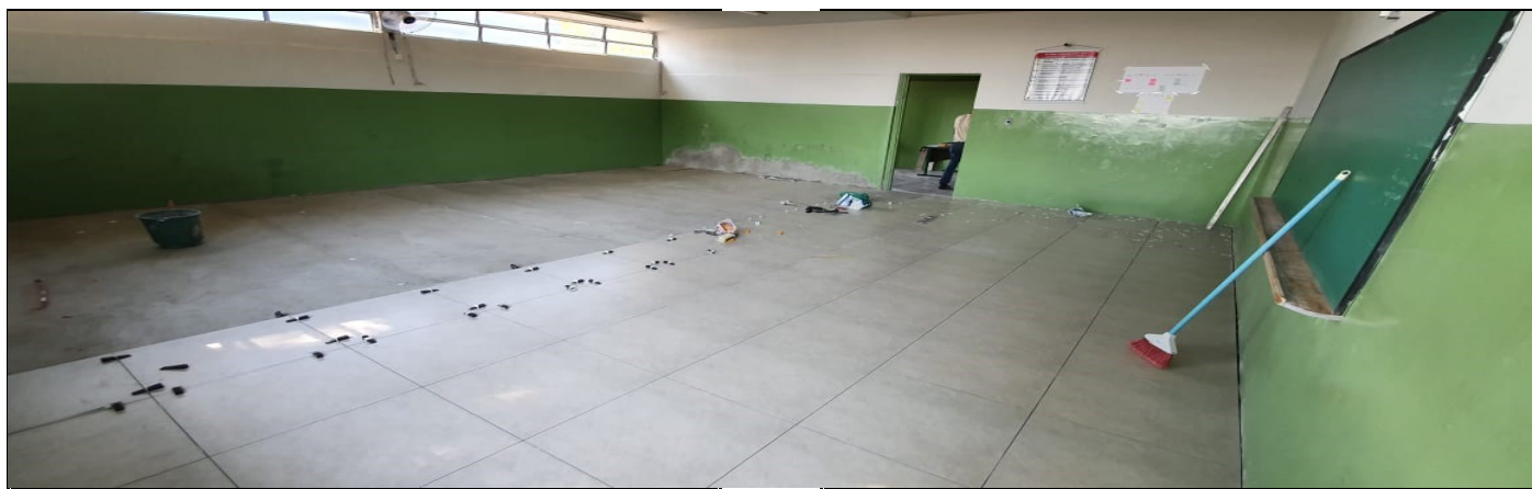
COLOCAÇÃO DE PISO EM UMA ÚNICA SALA DE AULA
