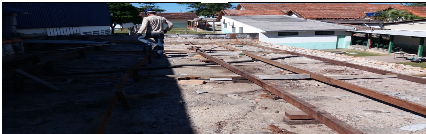
TROCA DE TELHAS E ESTRUTURA DO TELhado DOS SANITÁRIOS DOS ALUNOS
