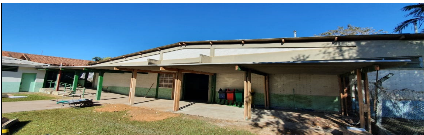
RECOLOCAÇÃO DE NOVA ESTRUTURA E TELHAS DA PASSARELA RETIRADA
