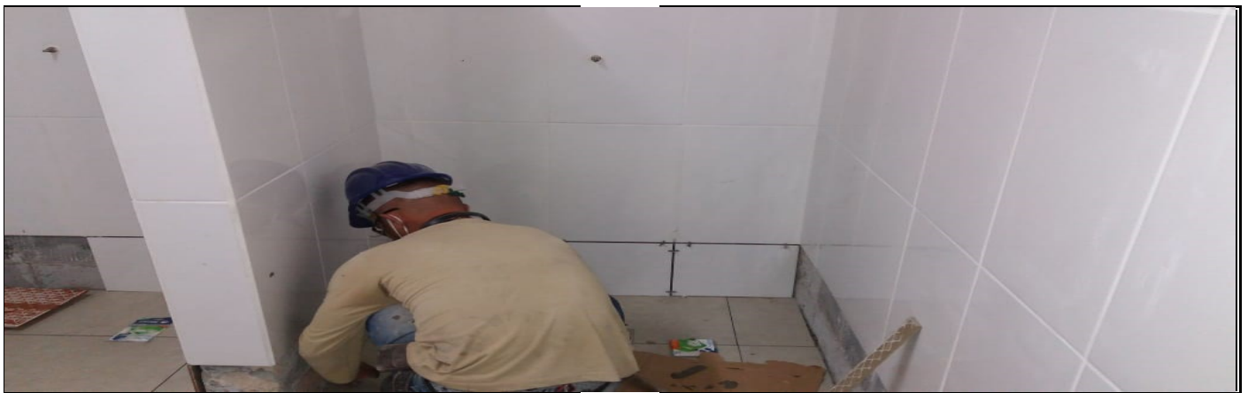
REFORMA DO SANITÁRIO DO GINÁSIO DE ESPORTES
