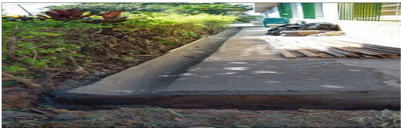
EXECUÇÃO DE NOVAS CALÇADAS E CANALETAS
