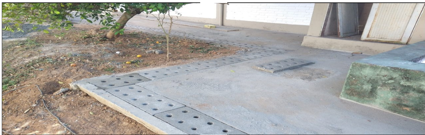
EXECUÇÃO DE NOVAS CALÇADAS E CANALETAS
