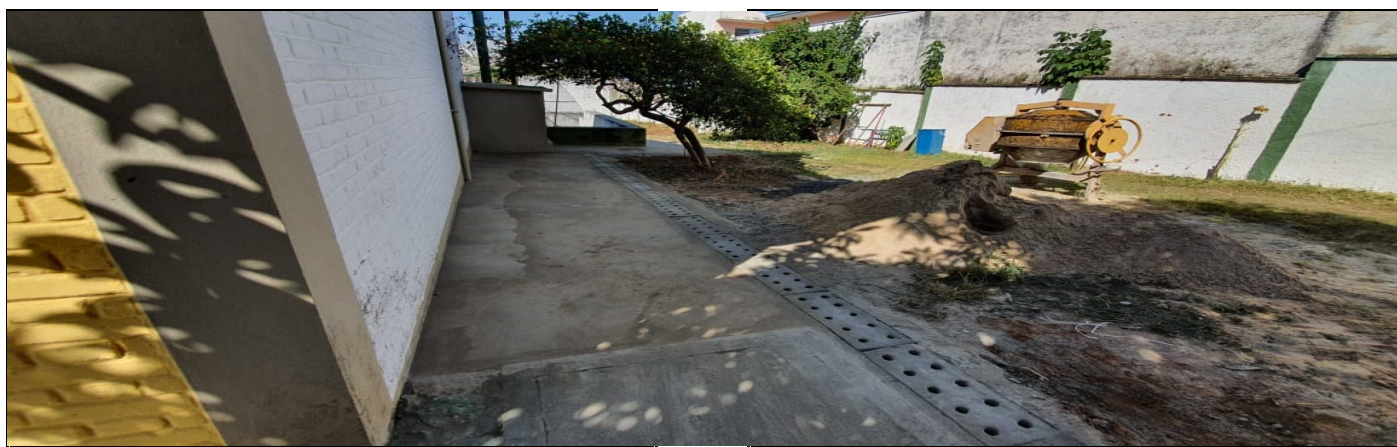
EXECUÇÃO DE NOVAS CALÇADAS E CANALETAS
