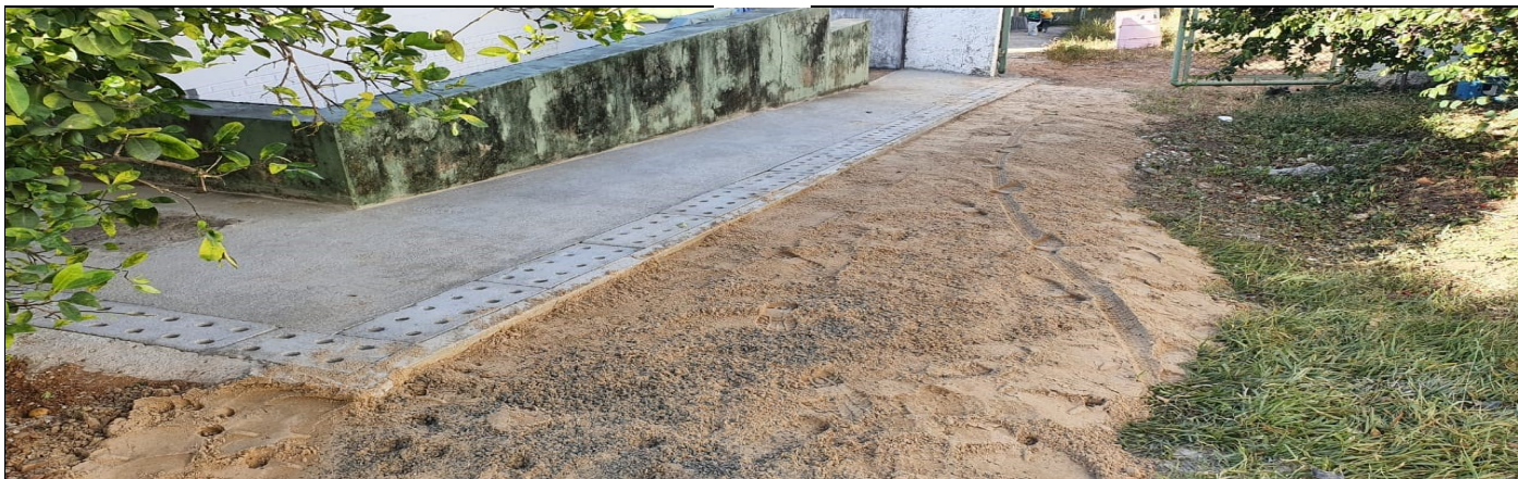
EXECUÇÃO DE NOVAS CALÇADAS E CANALETAS
