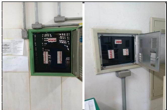
COLOCAÇÃO DE PAINEL ACRÍLICO NO BARRAMENTO DA CAIXA DE ENERGIA
