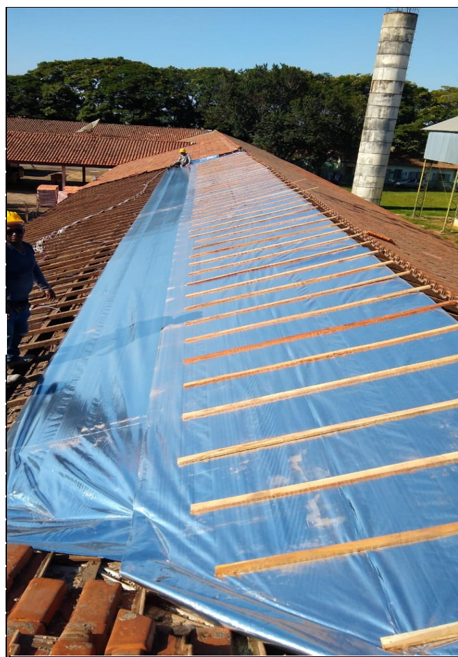
INSTALAÇÃO DE MANTA ALUMINIZADA, TROCA DE TELHAS CERÂMICAS, CALHAS, RIPAS, ETC
