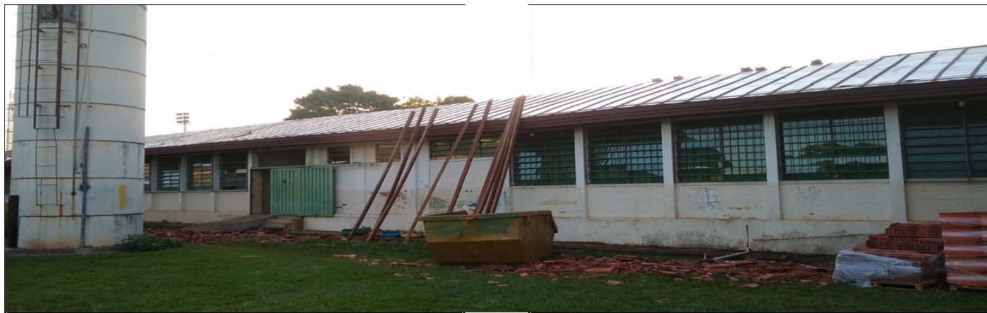
INSTALAÇÃO DE MANTA ALUMINIZADA, TROCA DE TELHAS CERÂMICAS, CALHAS, RIPAS, ETC
