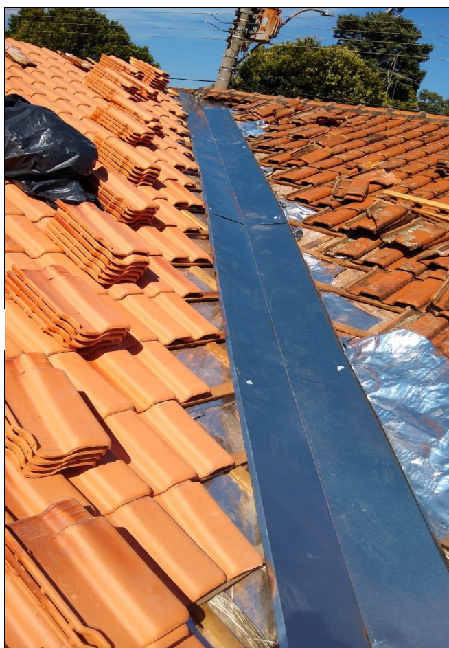
INSTALAÇÃO DE MANTA ALUMINIZADA, TROCA DE TELHAS CERÂMICAS, CALHAS, RIPAS, ETC
