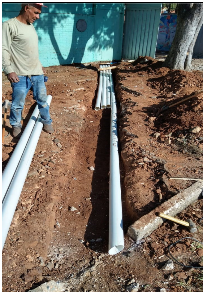
COLOCAÇÃO DE TUBULAÇÃO PARA ESCOAMENTO DE ÁGUA PLUVIAL
