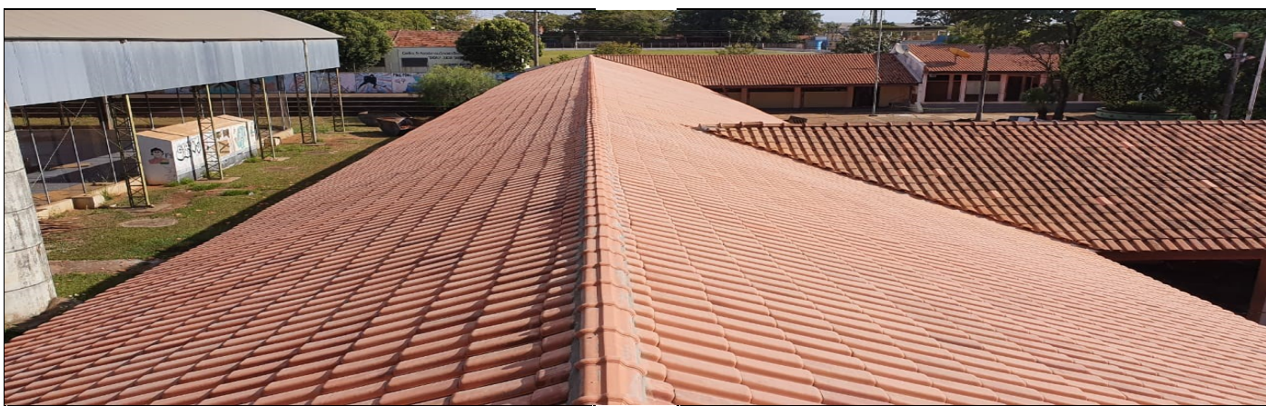
FINALIZAÇÃO DA REFORMA DO TELHADO
