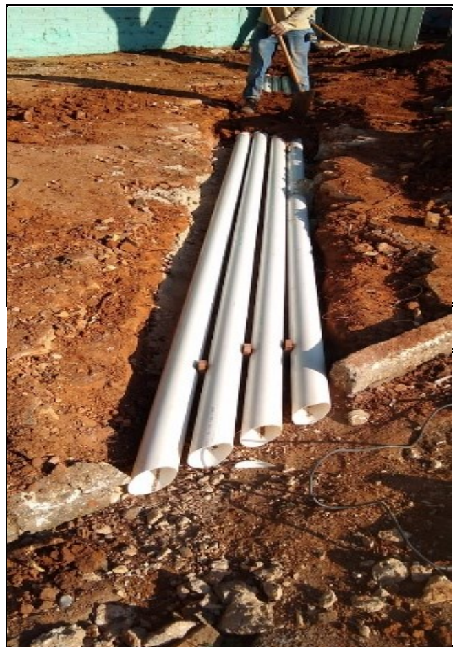
COLOCAÇÃO DE TUBULAÇÃO PARA ESCOAMENTO DE ÁGUA PLUVIAL
