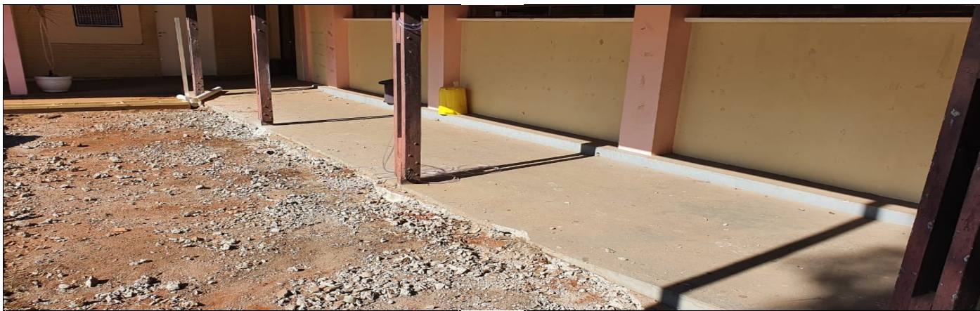
EXECUÇÃO DE NOVO PISO DE CONCRETO NO PÁTIO
