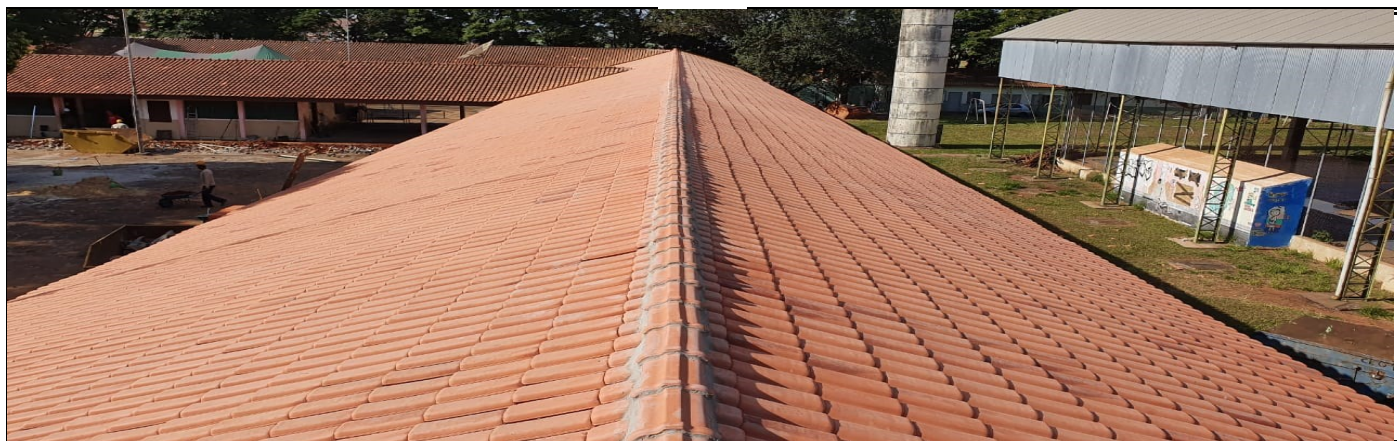
FINALIZAÇÃO DA REFORMA DO TELHADO
