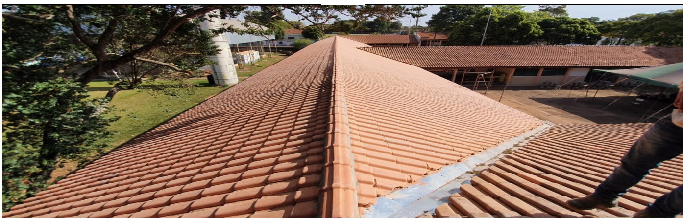
FINALIZAÇÃO DA REFORMA DO TELHADO
