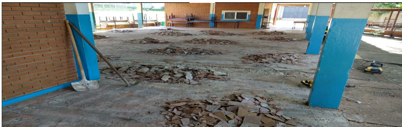
DEMOLIÇÃO PISO CERÂMICO DOS CORREDORES E SALAS DE AULA
