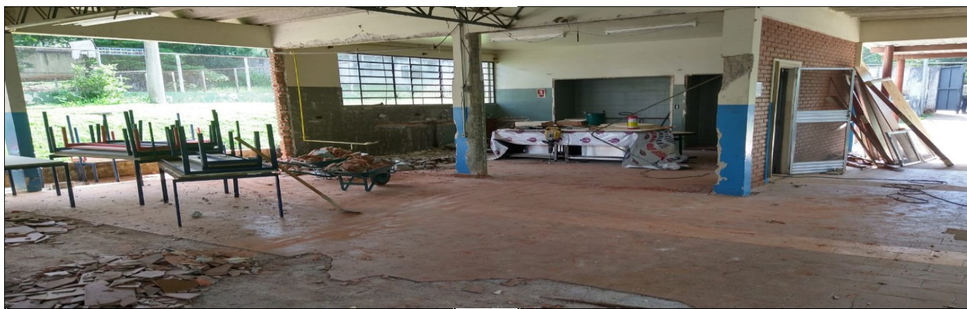
DEMOLIÇÃO ANTIGA COZINHA E EXECUÇÃO DE NOVA ALVENARIA NA COZINHA E DESPENSA
