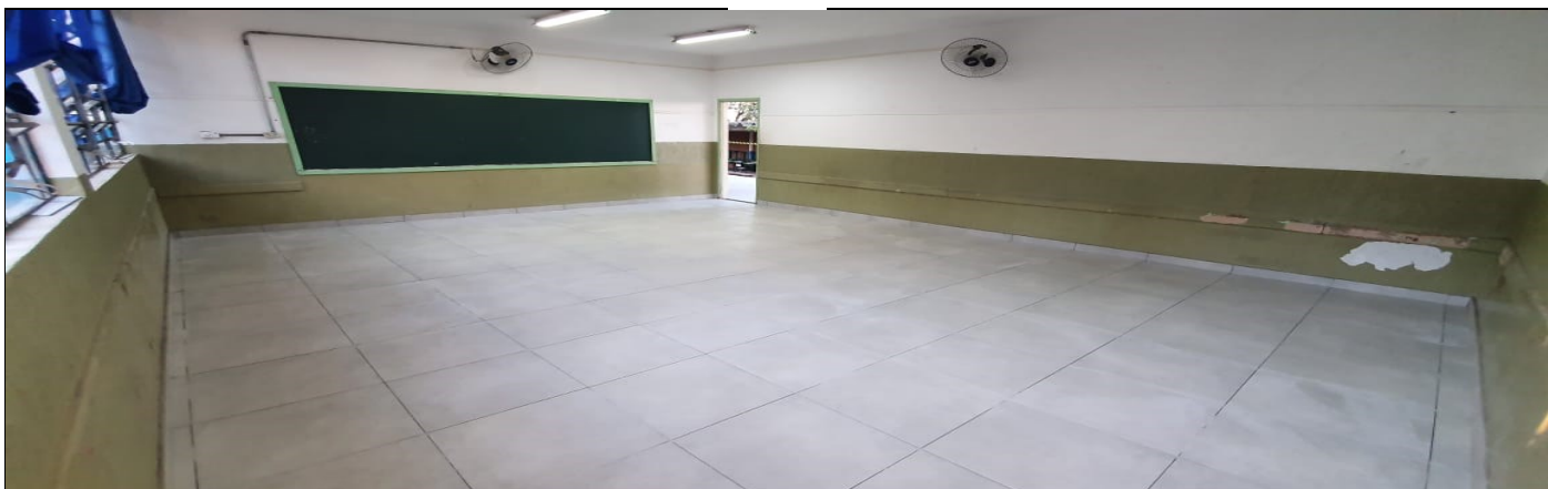
COLOCAÇÃO PISO NA SALA DE AULA
