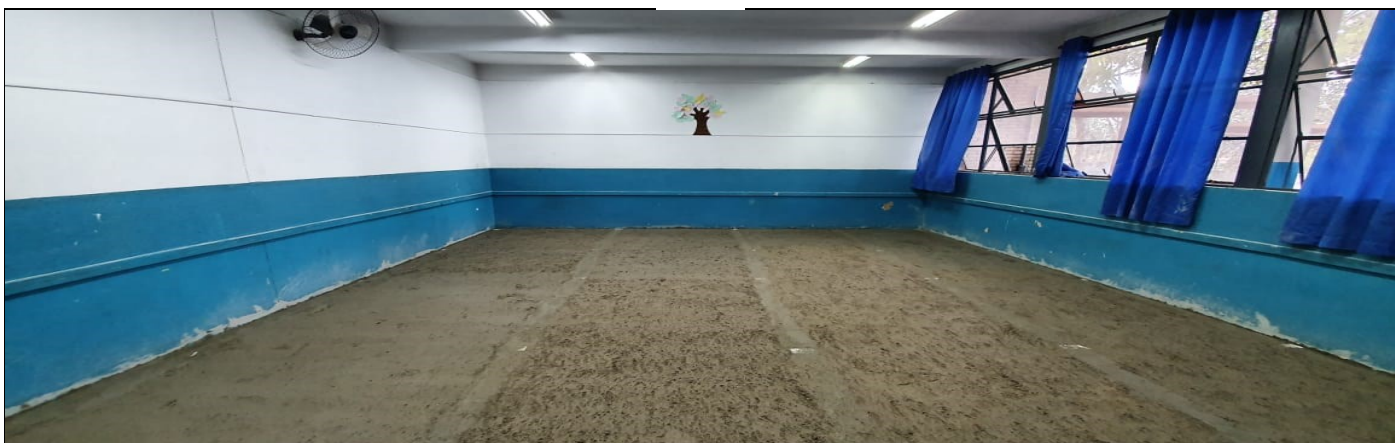
COLOCAÇÃO PISO NA SALA DE AULA
