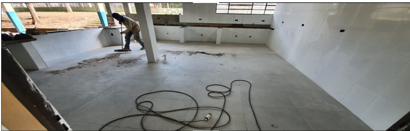
REFORMA DA COZINHA
