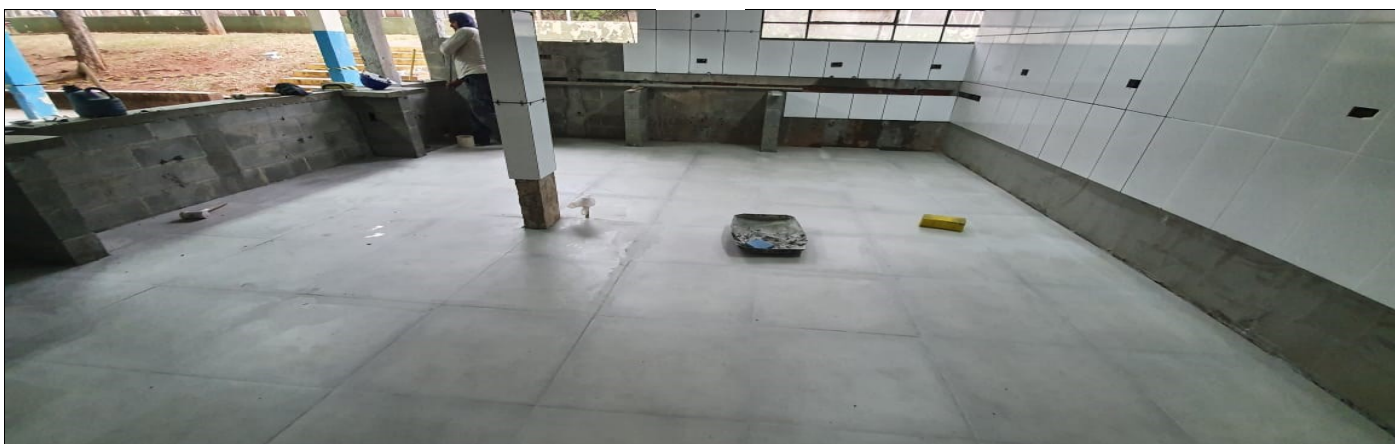
REFORMA DA COZINHA
