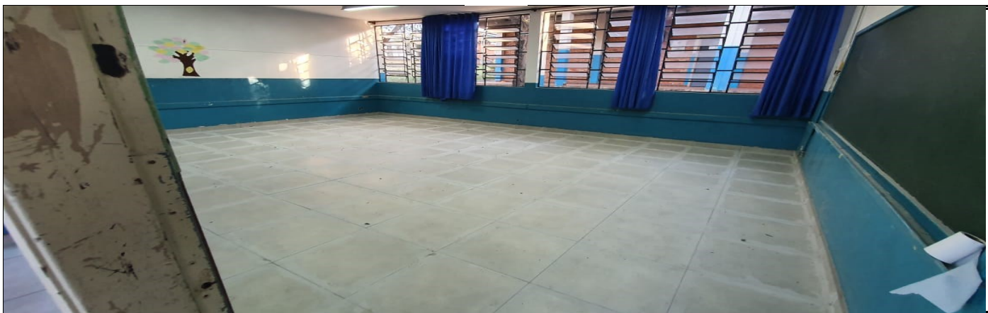
COLOCAÇÃO PISO NA SALA DE AULA
