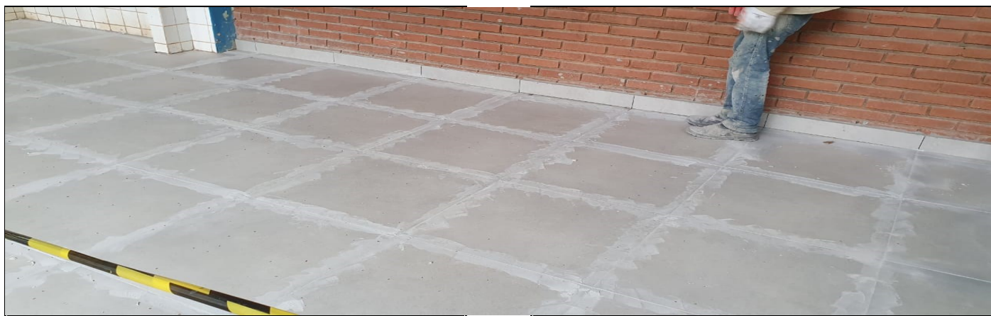
COLOCAÇÃO DE PISO NO CORREDOR DO TERCEIRO PAVIMENTO
