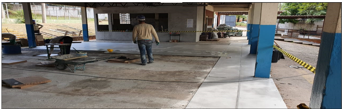
COLOCAÇÃO DE PISO
