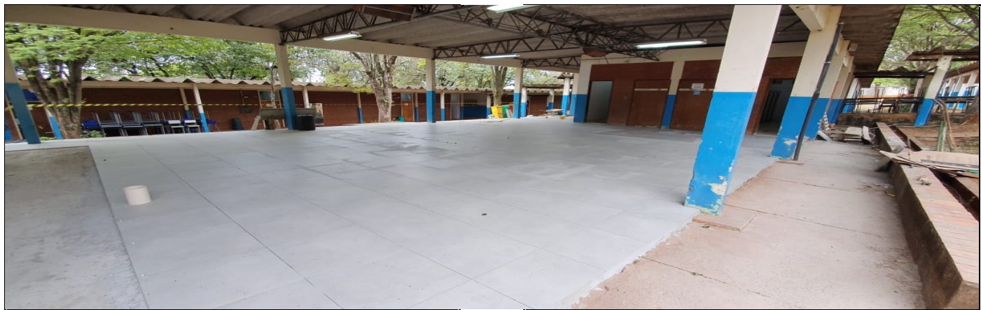
COLOCAÇÃO DE PISO
