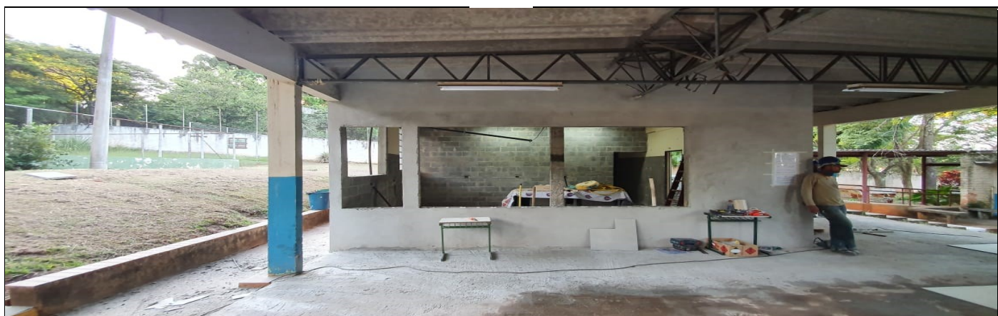
REFORMA DA COZINHA E DESPENSA
