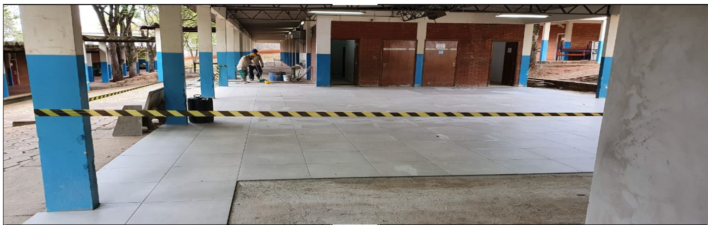
COLOCAÇÃO DE PISO
