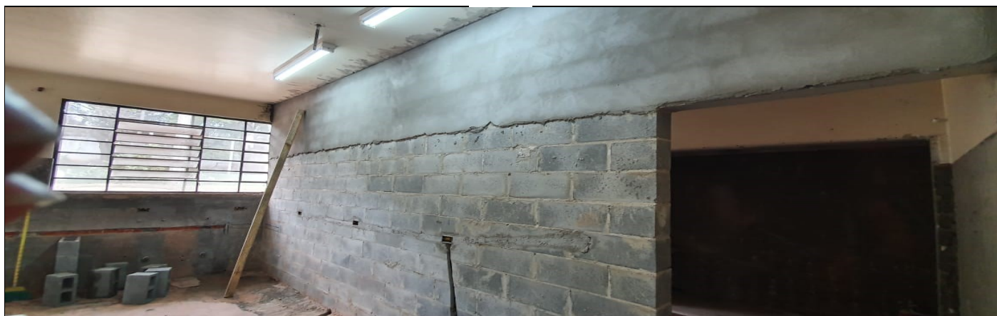
REFORMA DA COZINHA E DESPENSA
