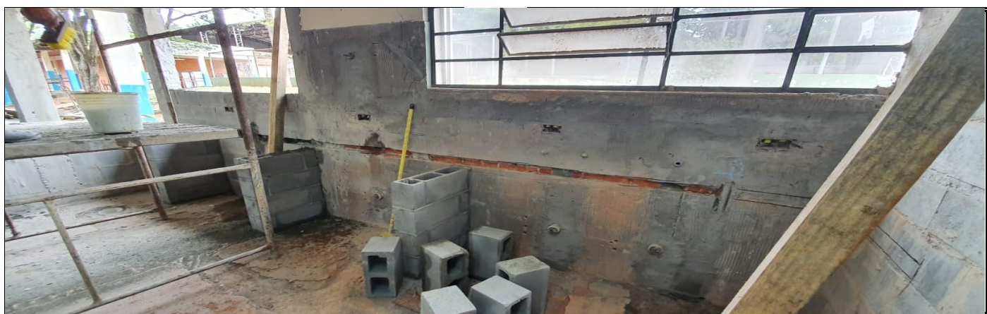
REFORMA DA COZINHA E DESPENSA
