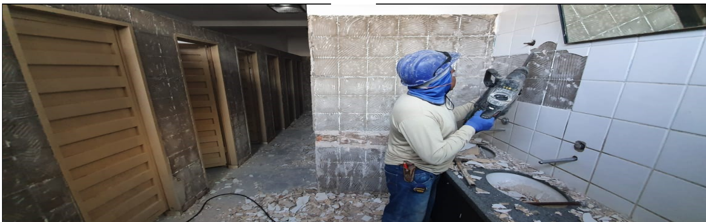
DEMOLIÇÃO DE REVESTIMENTO COM RETIRADA DE VASOS, LAVATÓRIO E MICTÓRIO DO SANITÁRIO DOS ALUNOS
