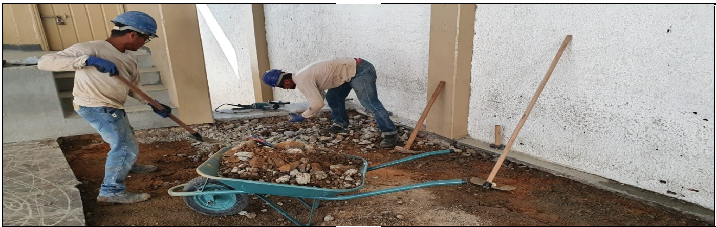
PREPARAÇÃO DO PISO DO REFEITÓRIO PARA ASSENTAMENTO DE PORCELANATO
