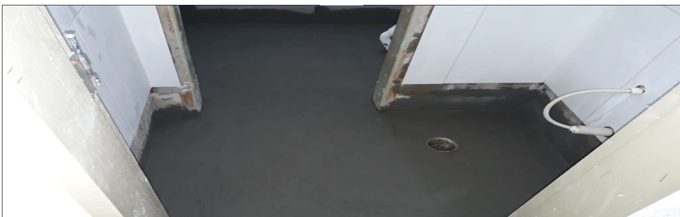
REFORMA DOS SANITÁRIOS ADMINISTRATIVOS
