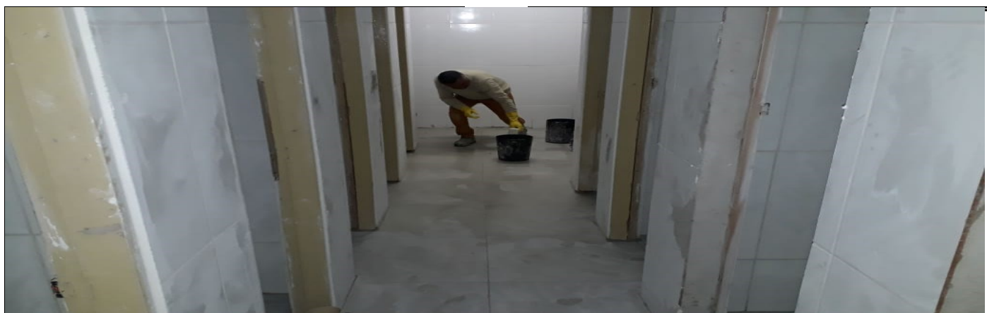
REFORMA DOS SANITÁRIOS DOS ALUNOS
