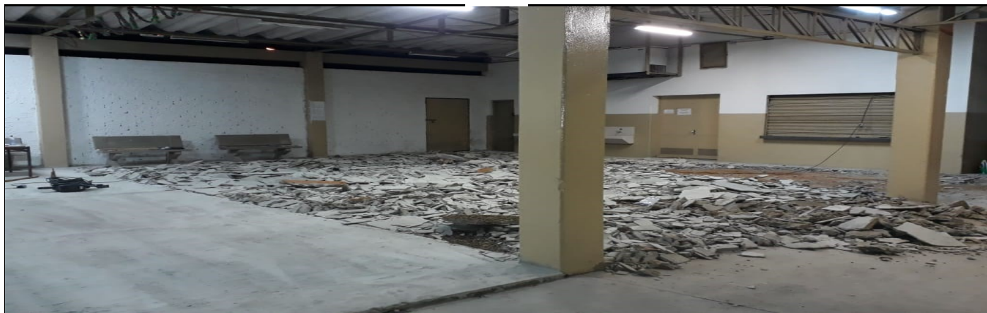
EXECUÇÃO DO PISO DO PÁTIO COBERTO (TEVE QUE QUEBRAR, POIS O PISO NÃO TINHA TELA)
