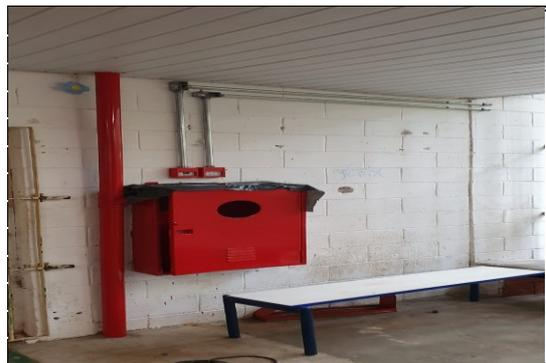
EXECUÇÃO DE TUBULAÇÃO ELÉTRICA PARA BOTOEIRAS DO ALARME DE INCÊNDIO E ACIONAMENTO DA BOMBA DE INCÊNDIO
