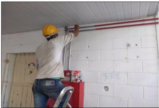
EXECUÇÃO DA PINTURA DA TUBULAÇÃO DE INCÊNDIO
