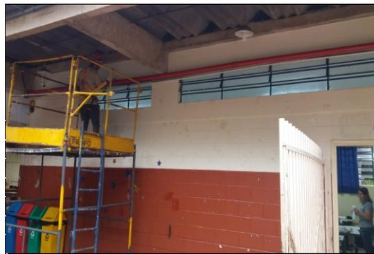
EXECUÇÃO DA PINTURA DA TUBULAÇÃO DE INCÊNDIO
