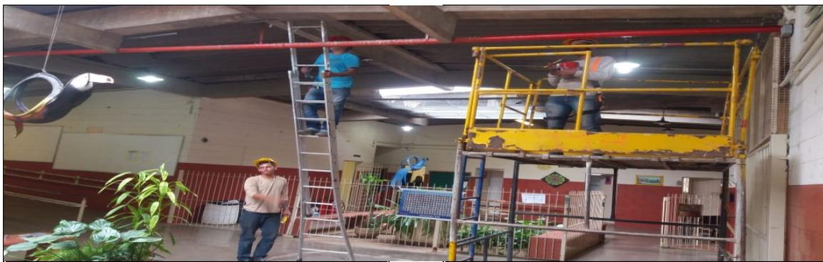
EXECUÇÃO DA PINTURA DA TUBULAÇÃO DE INCÊNDIO
