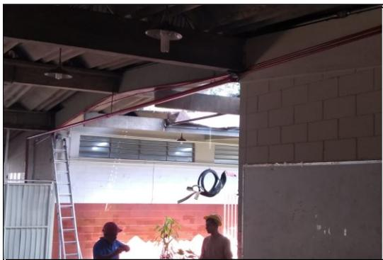
EXECUÇÃO DA PINTURA DA TUBULAÇÃO DE INCÊNDIO
