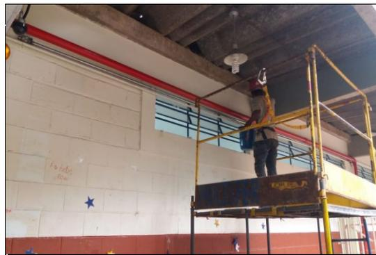
EXECUÇÃO DA PINTURA DA TUBULAÇÃO DE INCÊNDIO
