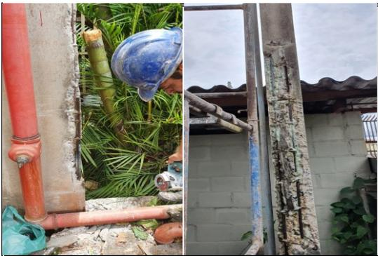
EXECUÇÃO DE REPARAÇÃO ESTRUTURAL NO RESERVATÓRIO SUPERIOR
