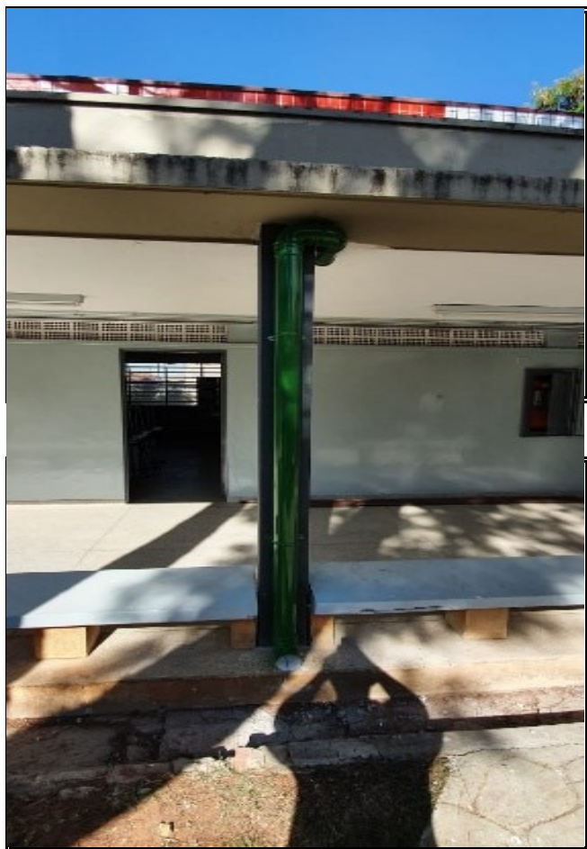
TROCA DE TUBULAÇÃO EXTERNA
