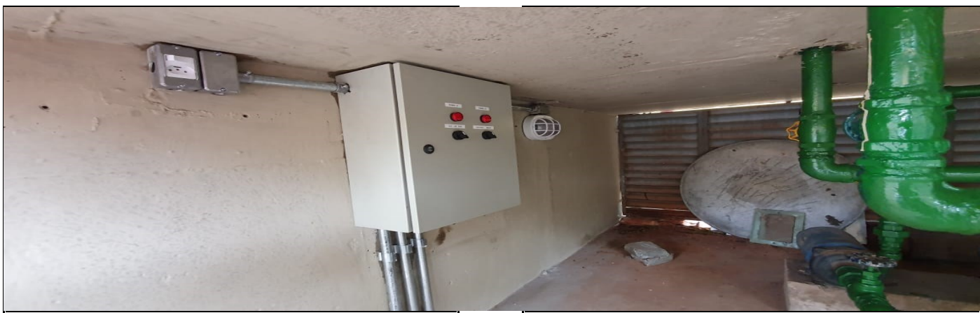
REFORMA ELETRICA DA CAIXA DE FORÇA DA BOMBA D'ÁGUA
