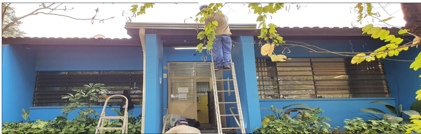
COLOCAÇÃO DE CALHAS
