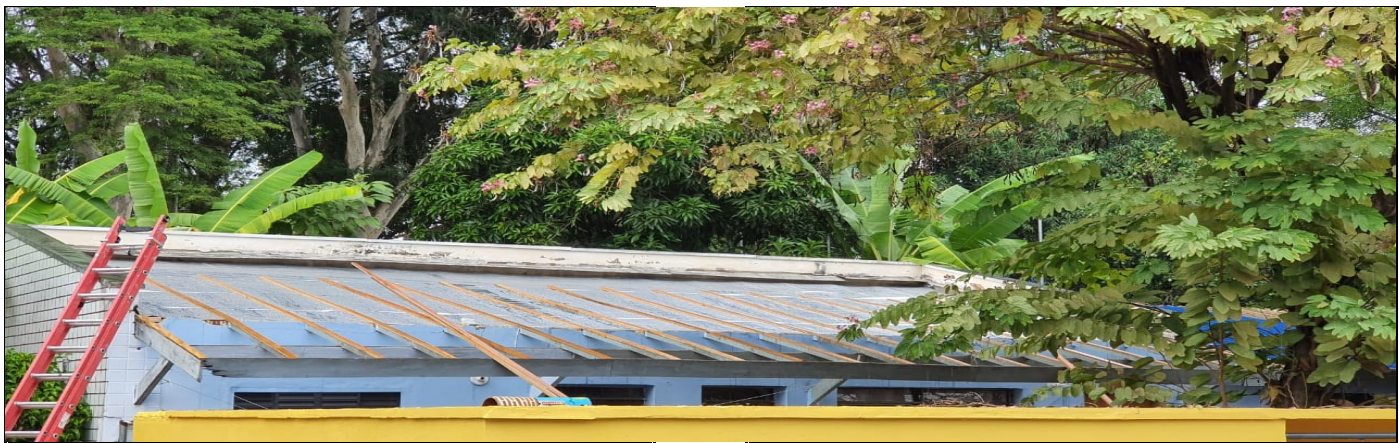
REFORMA DO TELHADO DA PARTE ADMINISTRATIVA
