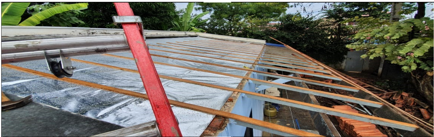
REFORMA DO TELHADO DA PARTE ADMINISTRATIVA
