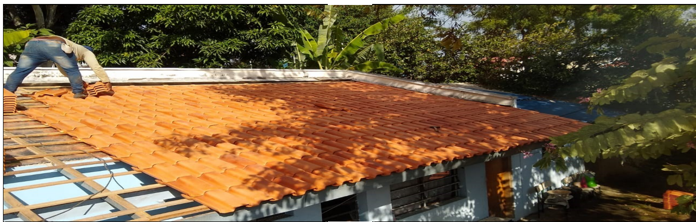
REFORMA DO TELHADO DA PARTE ADMINISTRATIVA
