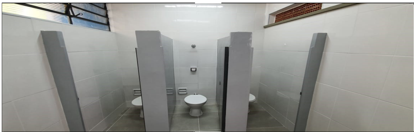
REFORMA DOS SANITARIOS ADMINISTRATIVOS
