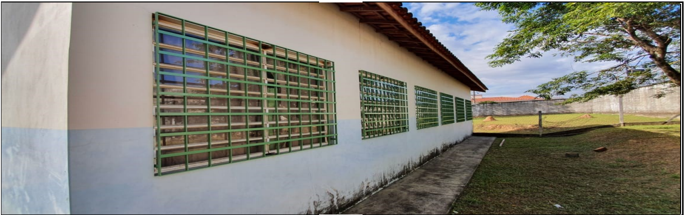
COLOCAÇÃO DE GRADE
