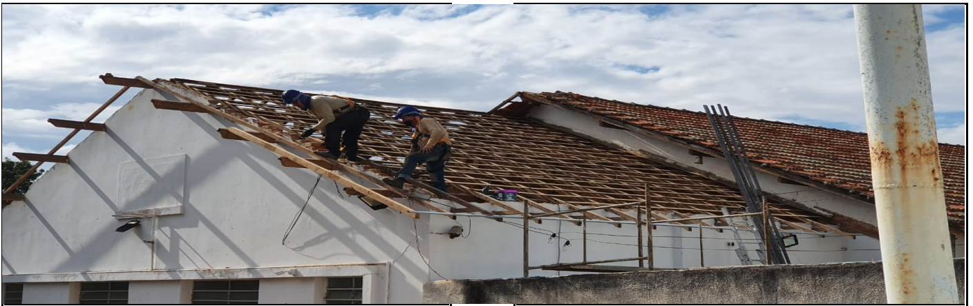
REFORMA DO TELHADO DA AREA ADMINISTRATIVA
