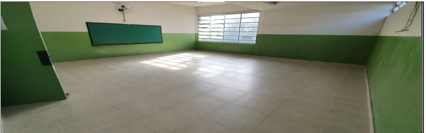
COLOCAÇÃO DE PISO NA SALA DE AULA
