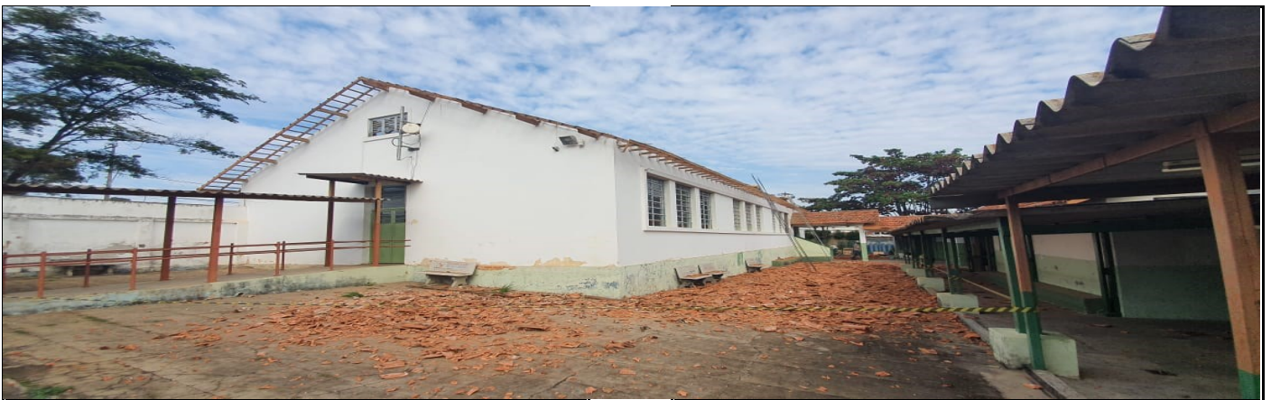
REFORMA DO TELHADO DA AREA ADMINISTRATIVA
