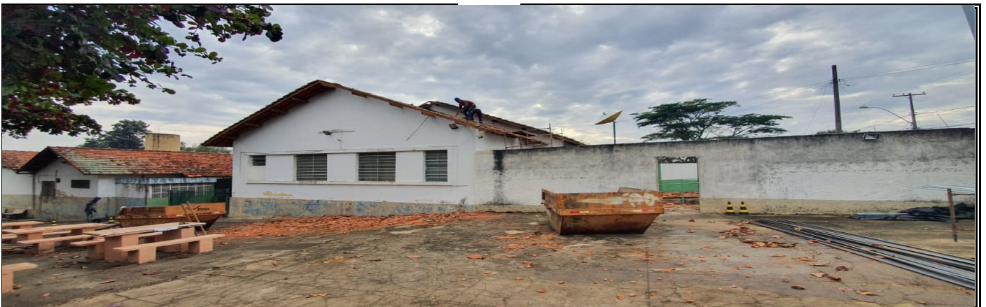
REFORMA DO TELhado DA AREA ADMINISTRATIVA
