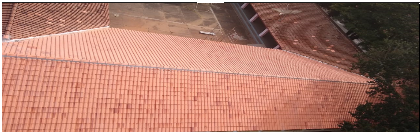
REFORMA DO TELHADO
