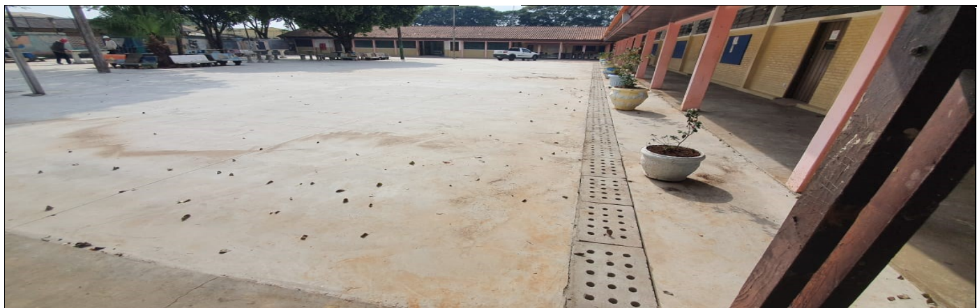
REFORMA DO PISO DE CONCRETO INTERNO E NOVA REDE DE ÁGUA PLUVIAL
