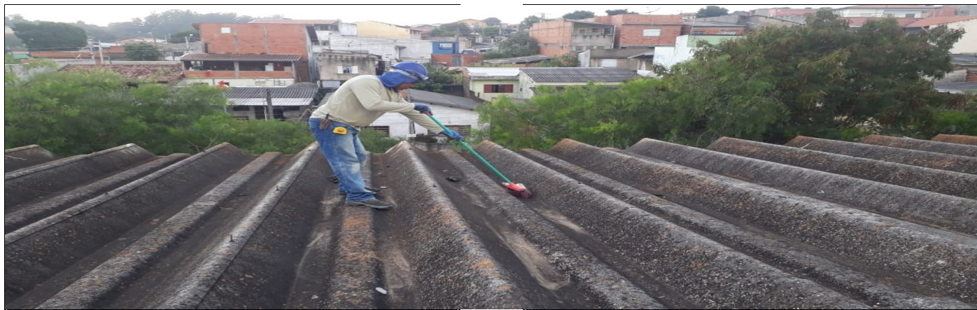
LIMPEZA DO TELHADO
