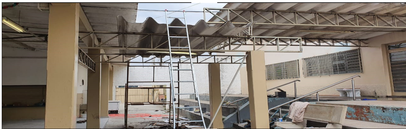
TROCA DE TELHAS
