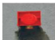
**9-** Agora a válvula de descarga está fixa e rebocada, deixando um espaço aberto para instalar o tubo de descarga.
