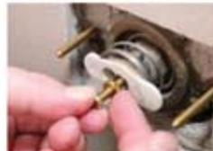
10 - Após a verificação, enrosque a porca até a base da chave e em seguida ajuste novamente com a chave-de-boca
