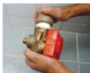
**4-** Fixar o adaptador já com a fita veda-rosca na válvula de descarga apertando-a posteriormente com a chave de cano.
