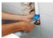
**10-** Com o vaso sanitário devidamente alinhado, marque onde o tubo de descida deve ser cortado.
