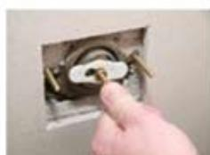
5 - Em seguida, durante a regulagem, faça testes apertando o parafuso que impulsiona a válvula de descarga até o final e...
