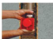
**7-** Use um adesivo plástico para tubo de VC para unir o adaptador com a válvula de descarga, tendo a certeza de que eles estejam alinhados com a parede.
