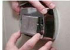
9 - Para saber se está na posição adequada, coloque o acabamento e verifique se as teclas estão levemente frouxas (cerca de 1 mm)
