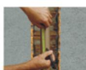
**5-** No intuito de preencher os requisitos ergonômicos, a válvula de descarga deve ser instalada a uma altura de aproximadamente 1,10m do chão ao centro da mesma. Utilize uma fita métrica e uma caneta para marcar a altura correta no tubo.
