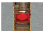
**8-** O tubo está pronto para receber o reboco e ser fixado junto com a válvula de descarga. A parte inferior da válvula deverá permanecer com o tampão de proteção que acompanha o produto e livre para depois ser instalado o tubo de descarga.
