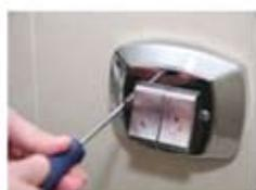
1 - Desparafuse os niples (parafusos) com a chave-de-fenda 1/4"
