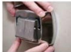
11 - Coloque o acabamento na posição adequada, posicione o niples (parafuso) e aperte com a chave-de-fenda
