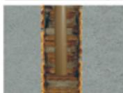
**2-** Deixar a extremidade do tubo livre para a instalação da válvula de descarga antes de embutir (fixar) o tubo.
