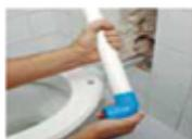
**12-** Una e cole o cotovelo azul no final do tubo. Não esqueça de colocar primeiro a porca de acoplamento (que acompanha a válvula de descarga) entre o encaixe do cotovelo e o final do tubo.
