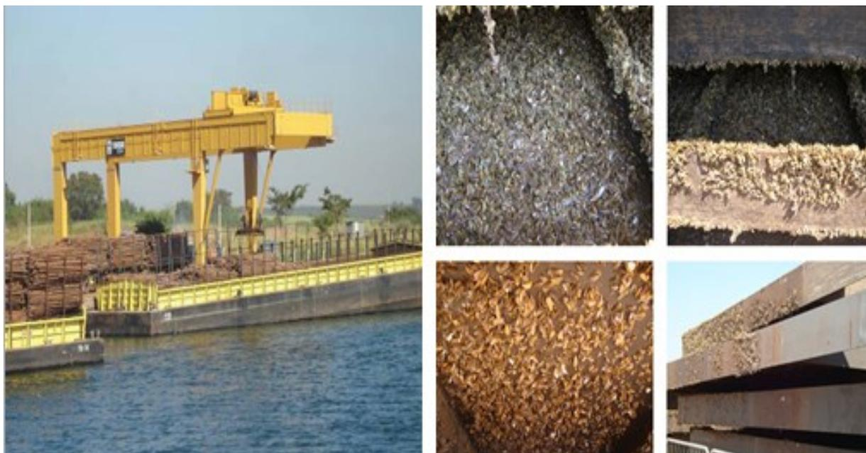
Figura 3: Macrofouling de mexilhão dourado em estrutura do Estaleiro do rio Tietê na região de Araçatuba / SP. Fonte: Chiarioni et al. (2011)
