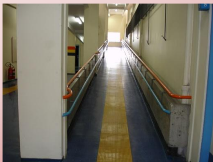
Rampa de entrada do prédio do CAPE
