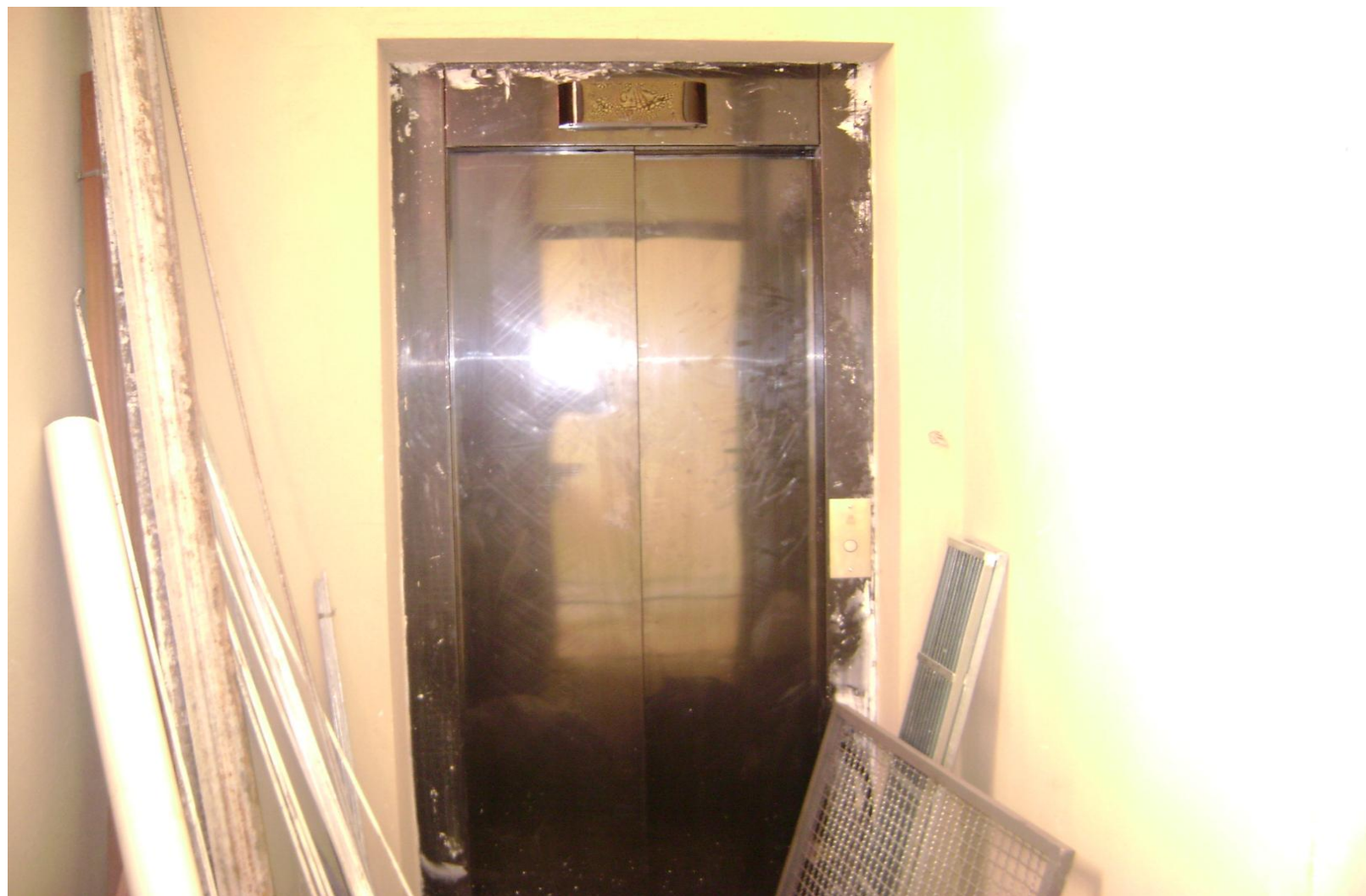
ELEVADOR EM MONTAGEM
