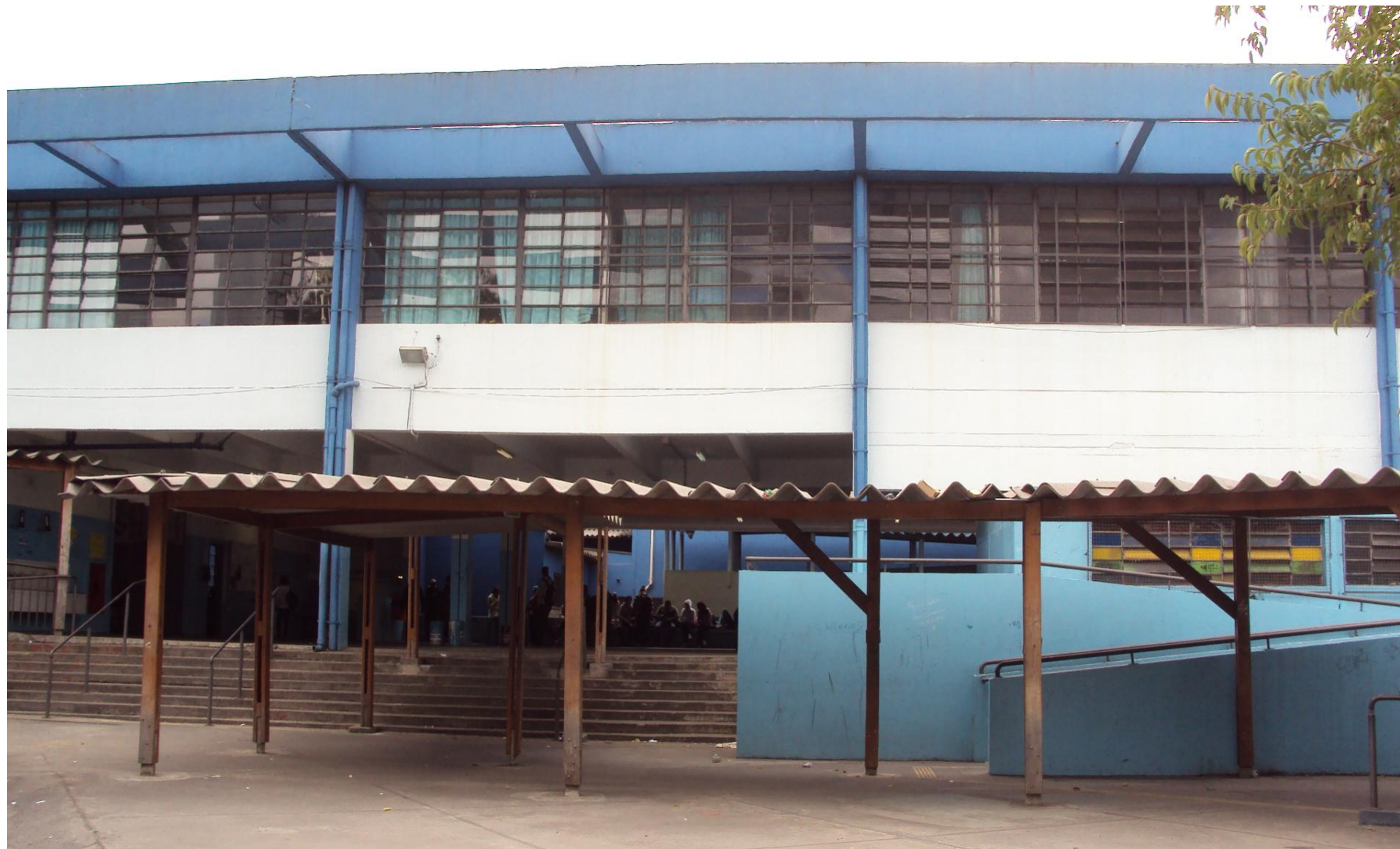
FOTO DA RAMPA (ACESSIBILIDADE) DA E. E. BUENOS AIRES
