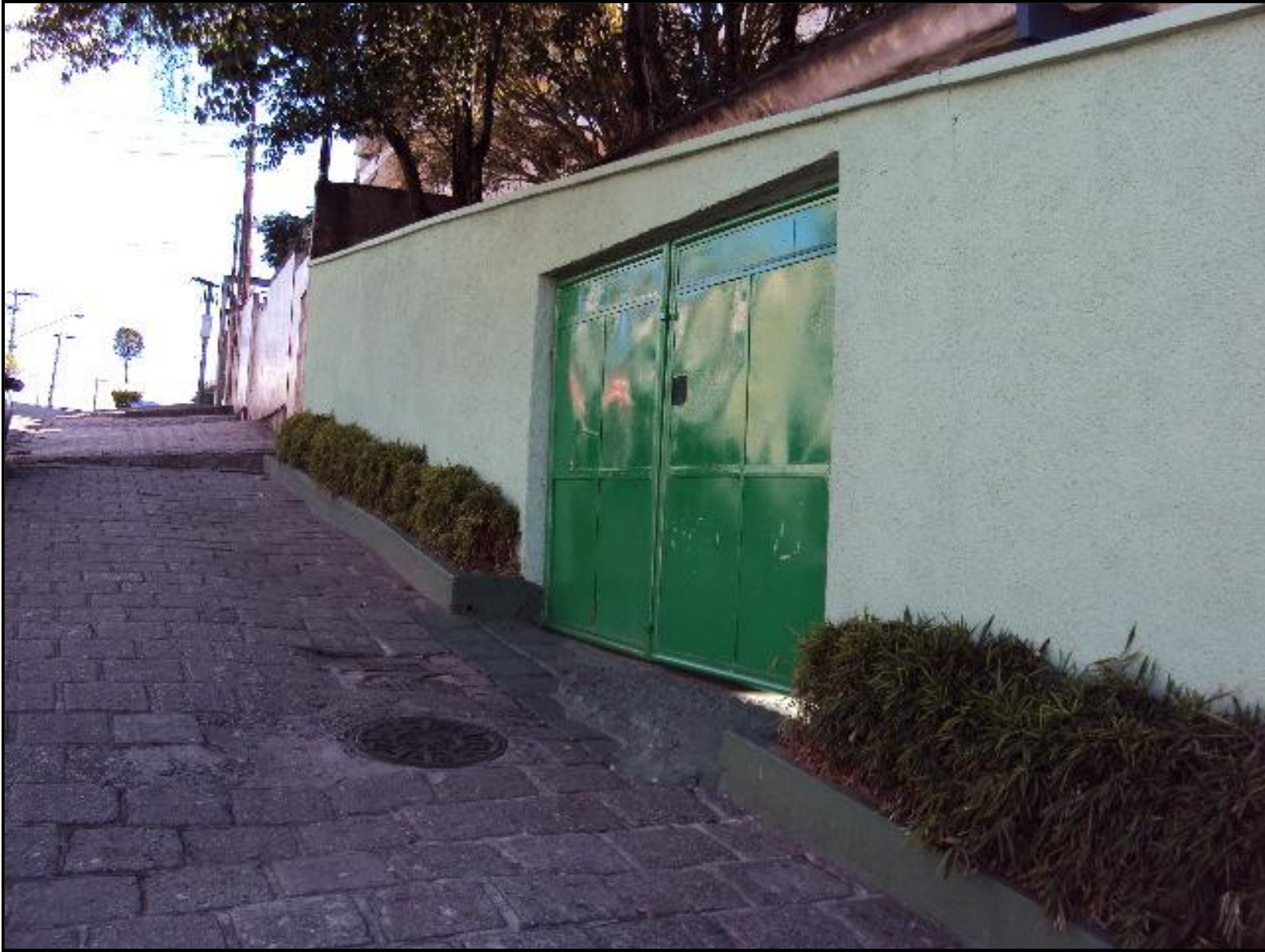
Portão de Entrada
