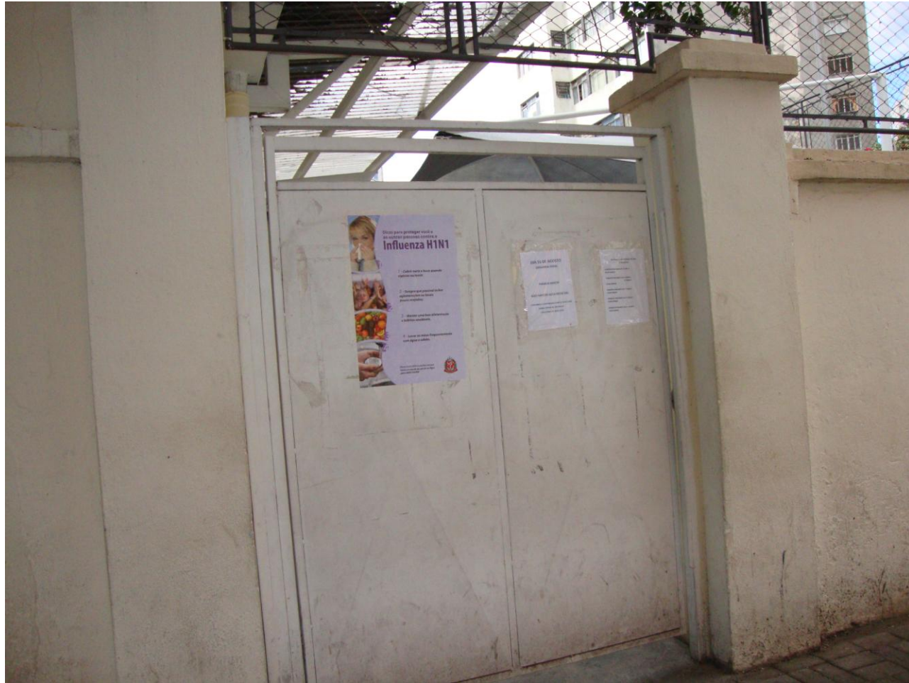
PORTÃO DE ENTRADA
