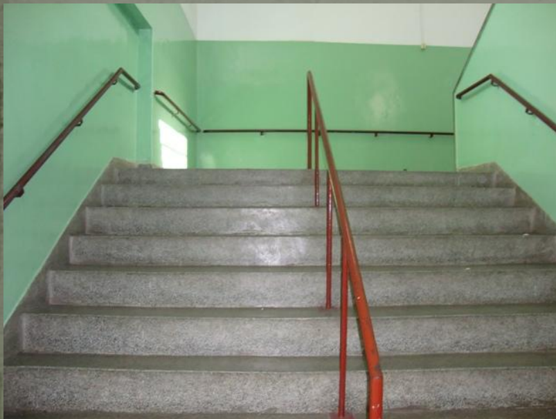
Escada interna –acesso piso superior –lado esquerdo
