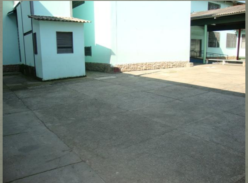
Casa de máquinas – elevador (Patio descoberto)
