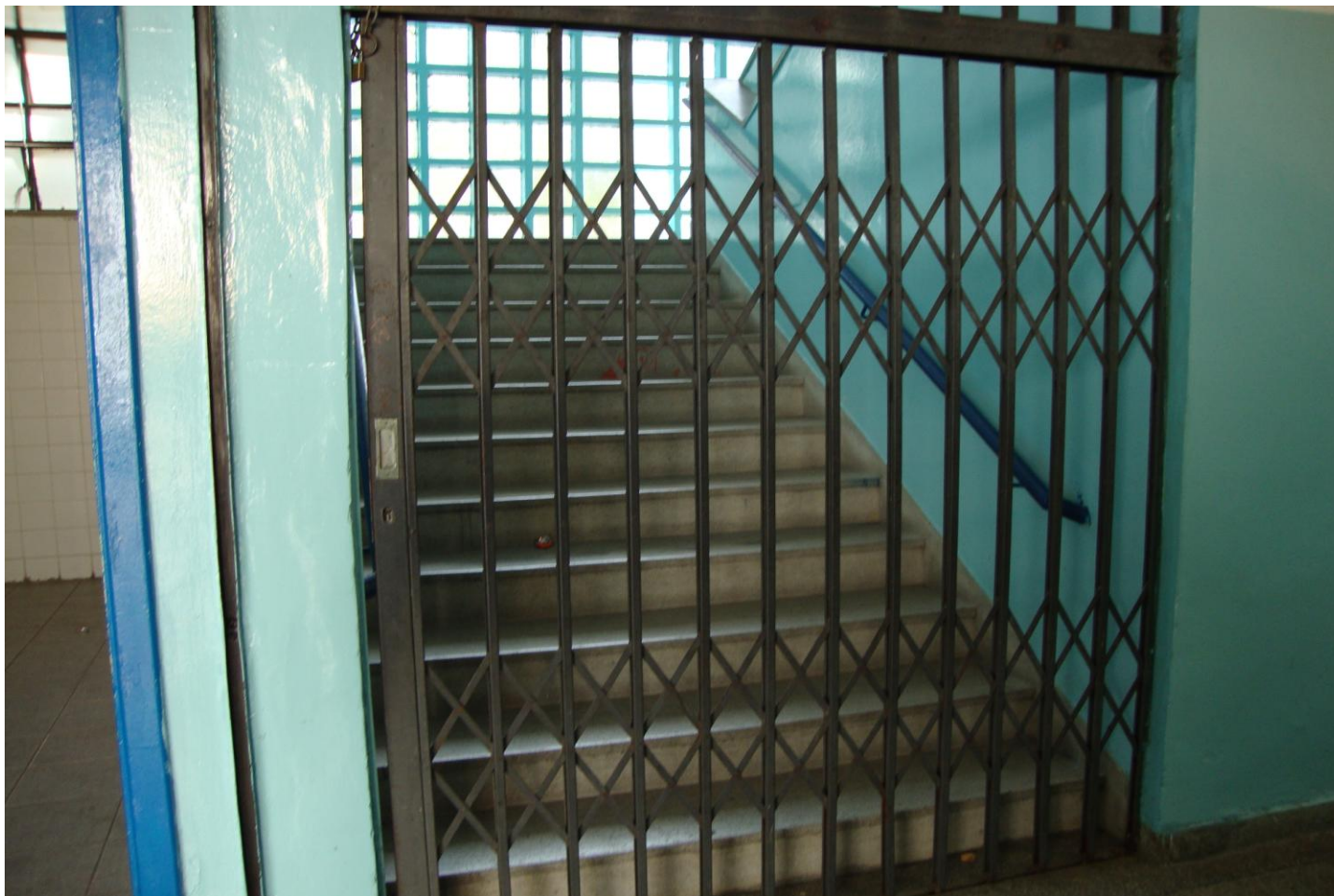
ESCADA DE ACESSO AO PÁTIO
